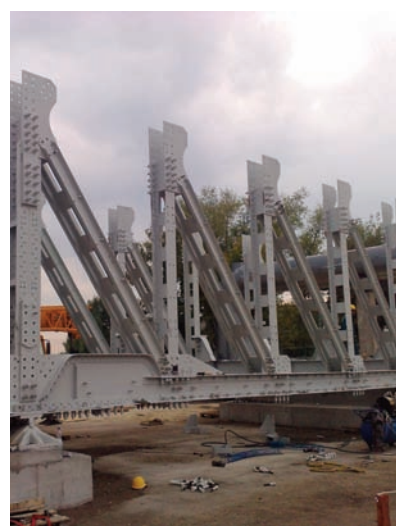
5. ábra. Az első szint szerelése
