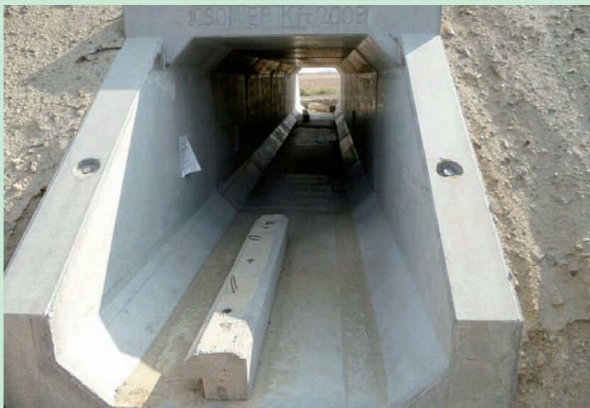
3. ábra. Vasbeton kerethíd építés közben
