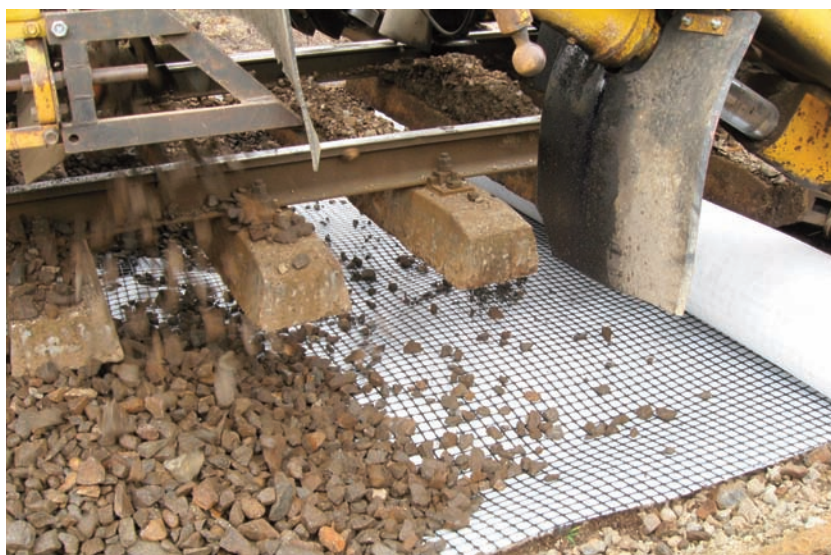
SSLA georács beépítése rostálás közben
