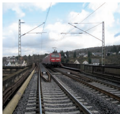
10. ábra. Az elkészült a hídburkolat
