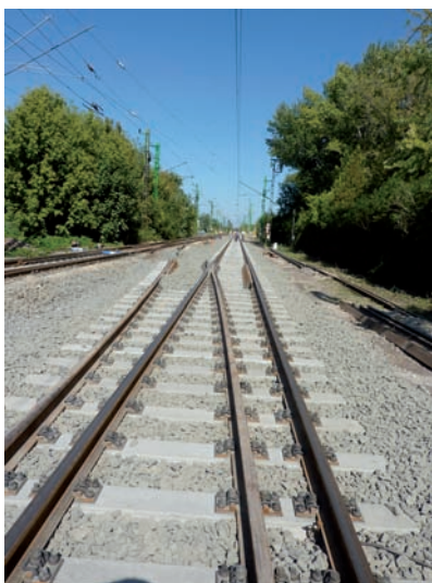
Gárdony állomás vágánykapcsolatának átépítése
