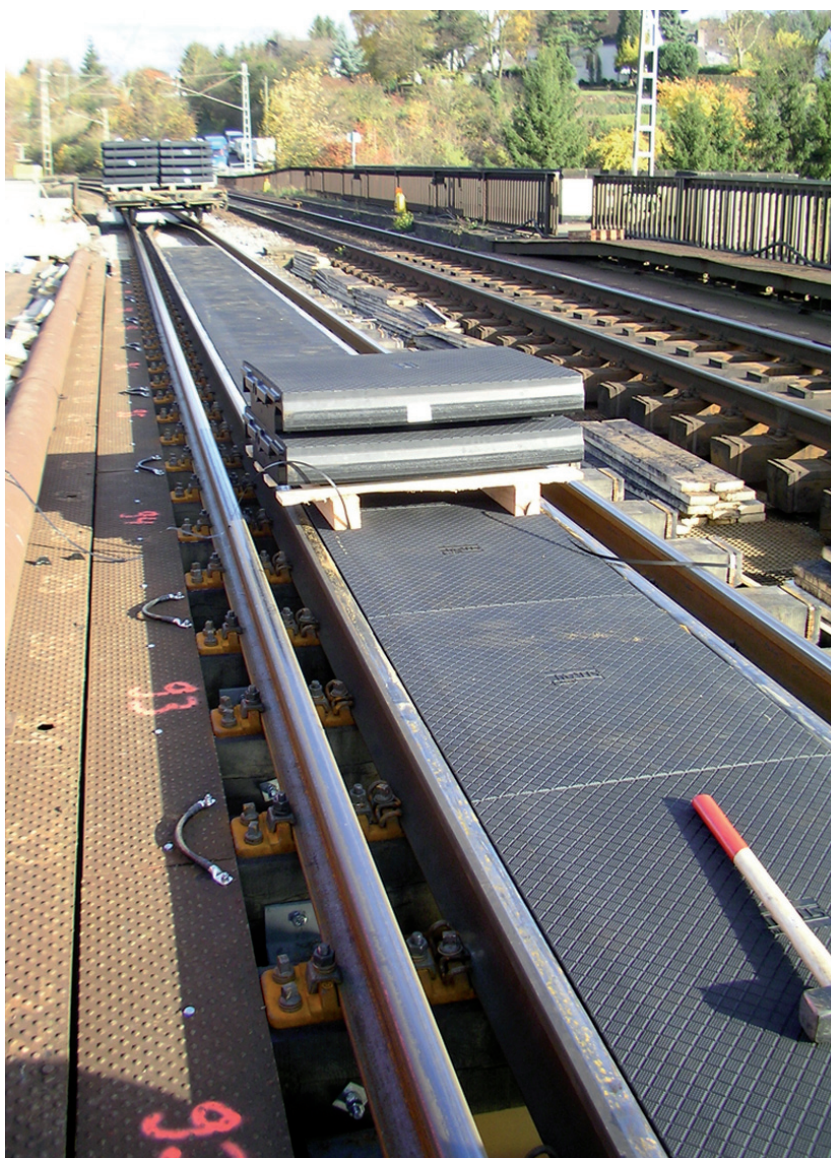
7. ábra. Beépített pedeSINGLE elemek
