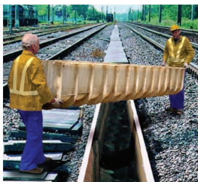
Rétegtelt üvegszövet-erősítésű műanyag heveder
