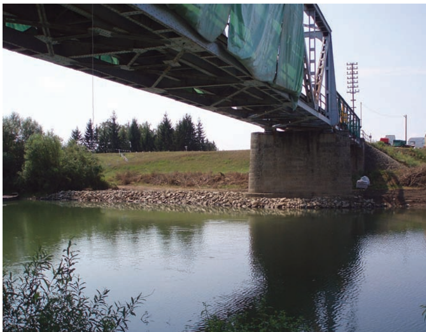
7. kép. Fekete-Körös vasúti híd 2007. évi helyreállítási munkái
