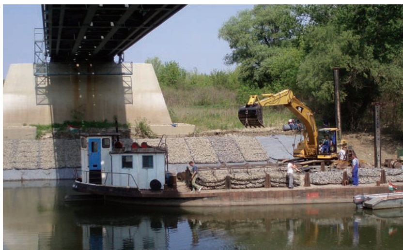
4. kép. A kunszentmártoni vasúti híd 2007. évi helyreállítási munkái, Reno matracos partvédelem
