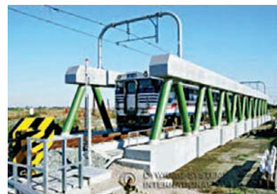
5. kép. Alsópályás vasúti nyitott híd, feszített vasbeton övekkel, rácsos gerinccel (forrás: http://www.dywidag-systems.com/references/details/article/yamaguragawa-bridge-japan.html )
