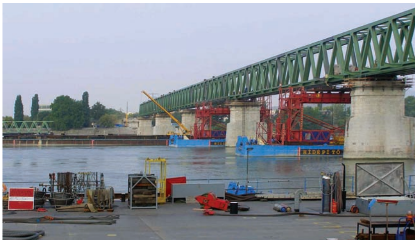
5. kép. Északi vasúti összekötő híd
