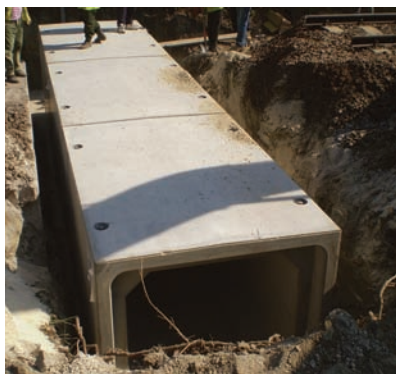
7. kép. Összehúzott keretelemek
