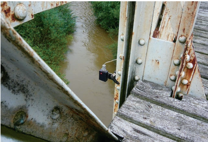
2. kép. Pinka-híd (MÁV) próbaterhelése, középső keresztmetszetben elhelyezett jeladó
