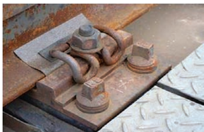
1. kép. CDM-ISO-DPHI füles sínalátét és CDM-ISO-UBP alátétlemez a Déli összekötő vasúti hídon
