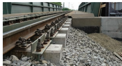
10. kép. Beépített kiegyenlítő lemez
