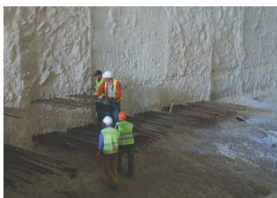
3. kép. Alaplemezsíkgig együtemű földkiemelés és résfal-alaplemez kapcsolata lentonok alkalmazásával
