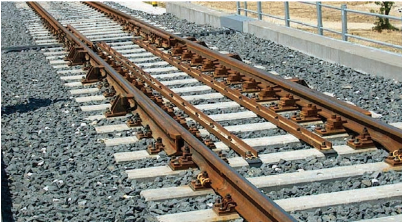
3. kép. Nagynyitású, VM rendszerű síndilatációs készülék a nagyrákosi völgyhídnál
