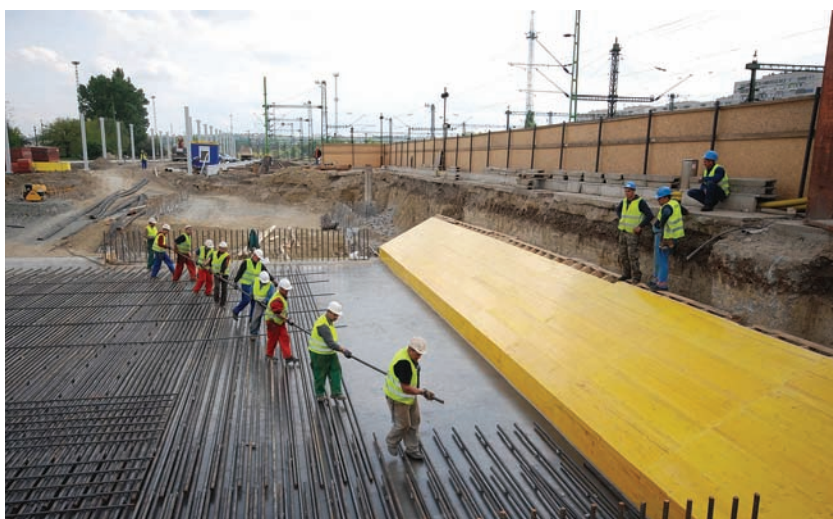
6. kép. Monolit vasbeton lemezhid vasszerelése, látszóbeton zsaluzat
