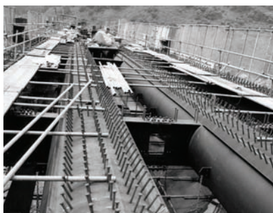
1. kép. Fejes csapos nyírt kapcsolat a csőgerendán (Nakamura et al. 2002)
