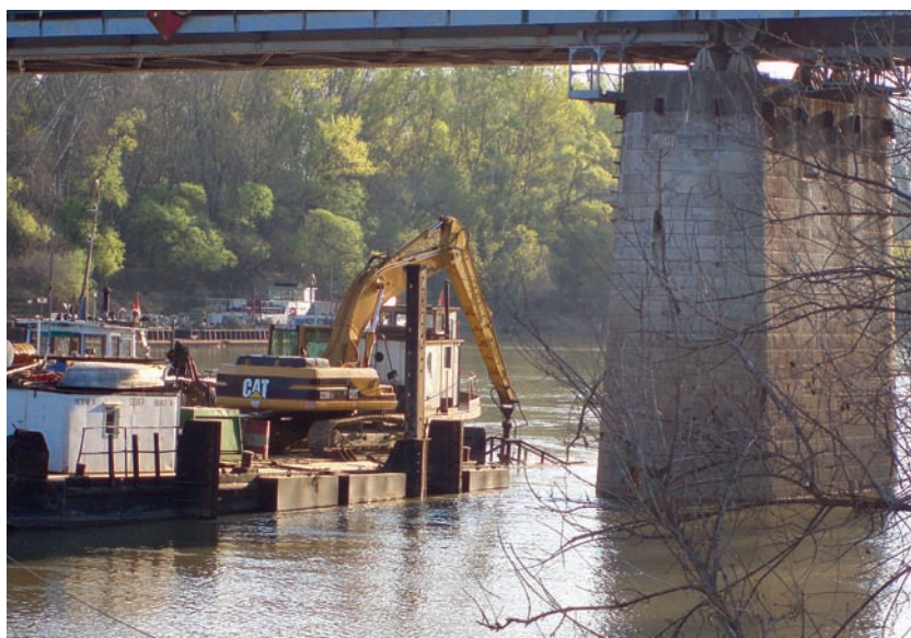
3. kép. Az algyői vasúti híd 2007. évi helyreállítási munkája, Reno matrac beépítése víz alatt
