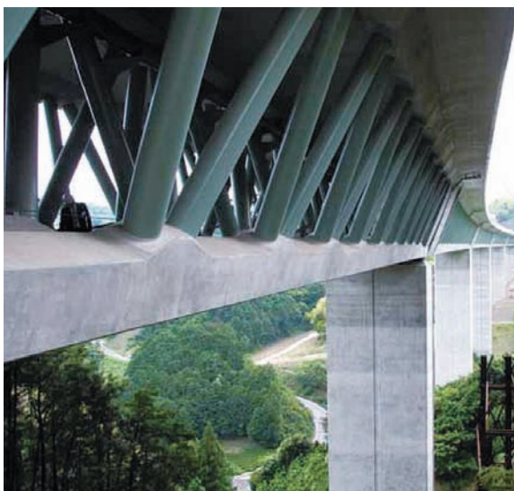
3. kép. Felsőpályás közúti híd, feszített vasbeton övekkel, rácsos gerinccel (fotó: Mizoguchi, S.)
