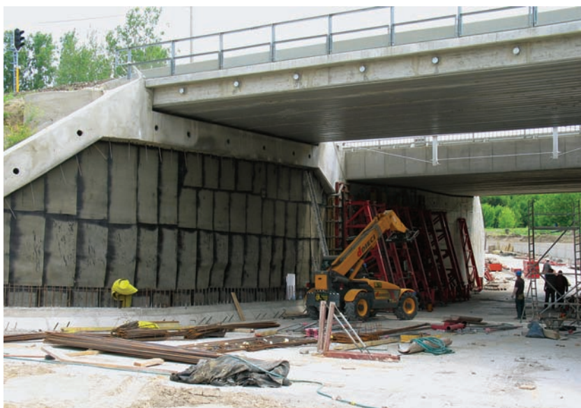
4. kép. HÉV-híd a bélésfal építése közben, háttérben a közúti híd
