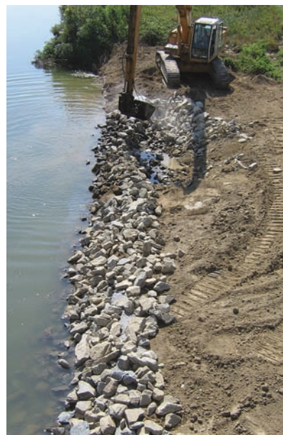
8. kép. Fehér-Körös vasúti híd 2007. évi helyreállítási munkái
