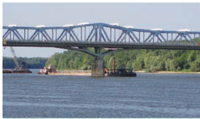
1. kép. A bajai vasúti híd 2007. évi helyreállítási munkája, kőszórás készítése
