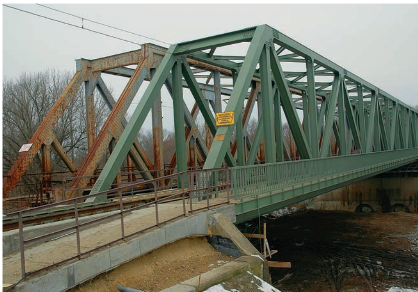
3. kép. Gyomaendrődi Hármas-Körös vasúti híd
