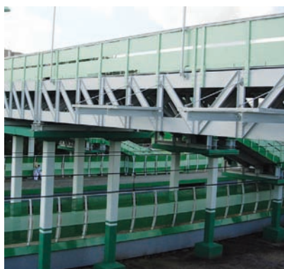
Műanyag alapanyagú hídszerkezetek
