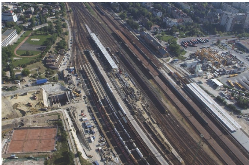
1. kép. Az épülő Kelenföldi pályaudvar metróállomás – légi fotó
