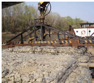
2. kép. Algyői vasúti híd, Reno matrac beemelő kerettel
