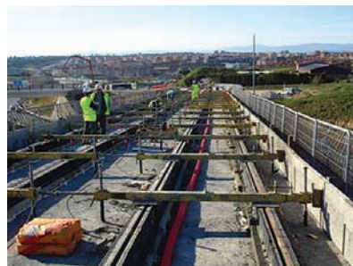
4. kép. CDM-PREFARAIL®-GSF rendszer építése hídon
