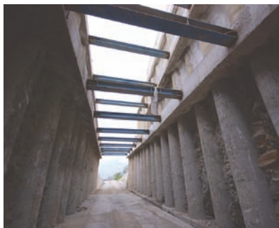
8. kép. Ideiglenes lejárórampa: acéldúccokkal kitámasztott hézagos fűrt cölöpfal
