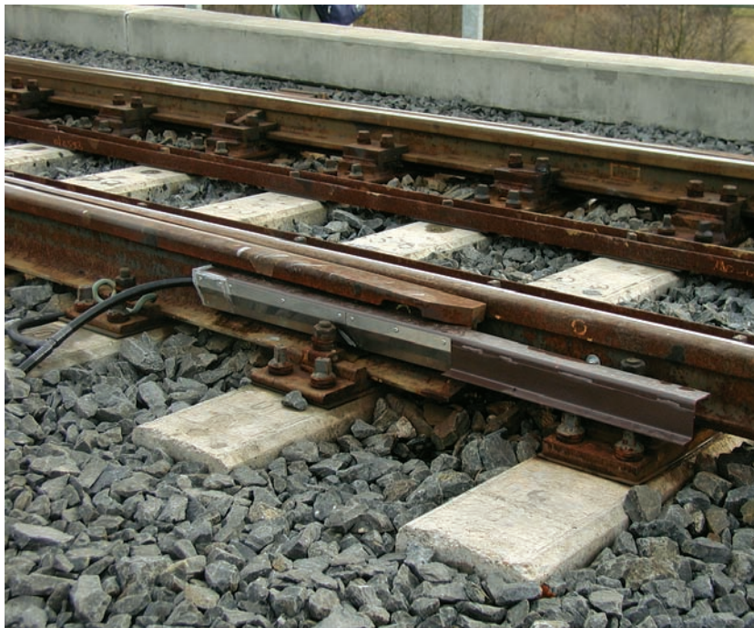
7. kép. Nagyrákosi völgyhíd, síndilatáció-mérés
