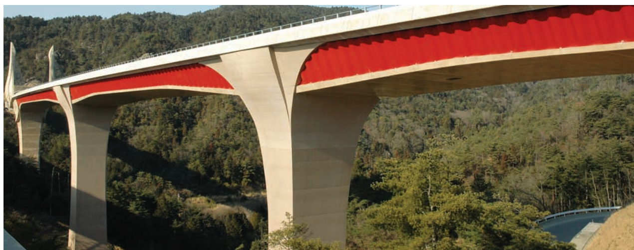
4. kép. Felsőpályás közúti híd, feszített vasbeton övekkel, trapézlemez gerinccel (fotó: dr. Dunai L.)
