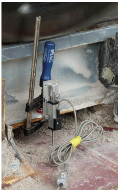
3. kép. Északi összekötő vasúti híd, Edilon sínleerősítés alakváltozás-mérése
