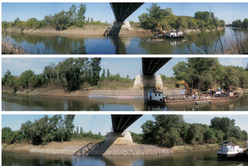
5. kép. A kunszentmártoni vasúti híd 2007. évi helyreállítási munkái
