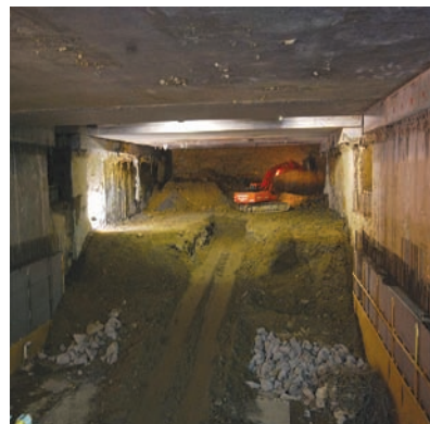
2. kép. Földkiemelés a vasúti hidak alól
