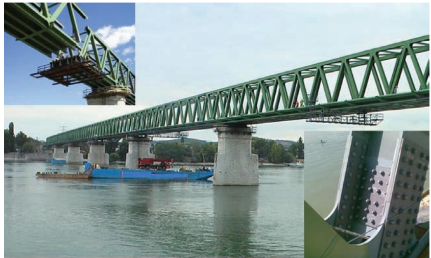
6. kép. Hídelemek összekapcsolása
