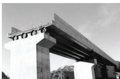
2. kép. Szerkezetkész kibetonozott csőgerendás öszvérhíd (Nakamura et al. 2002)
