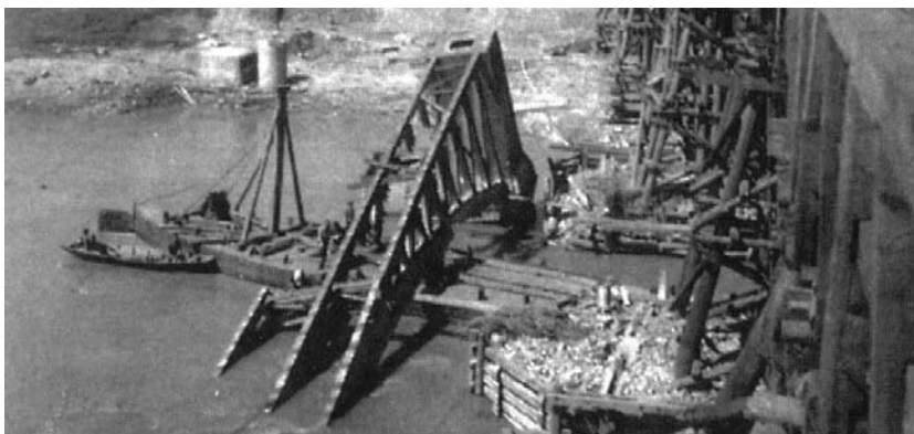
5. kép. A felrobbantott híd egyik, folyóba zuhant áthidaló szerkezetének roncskiemelése
