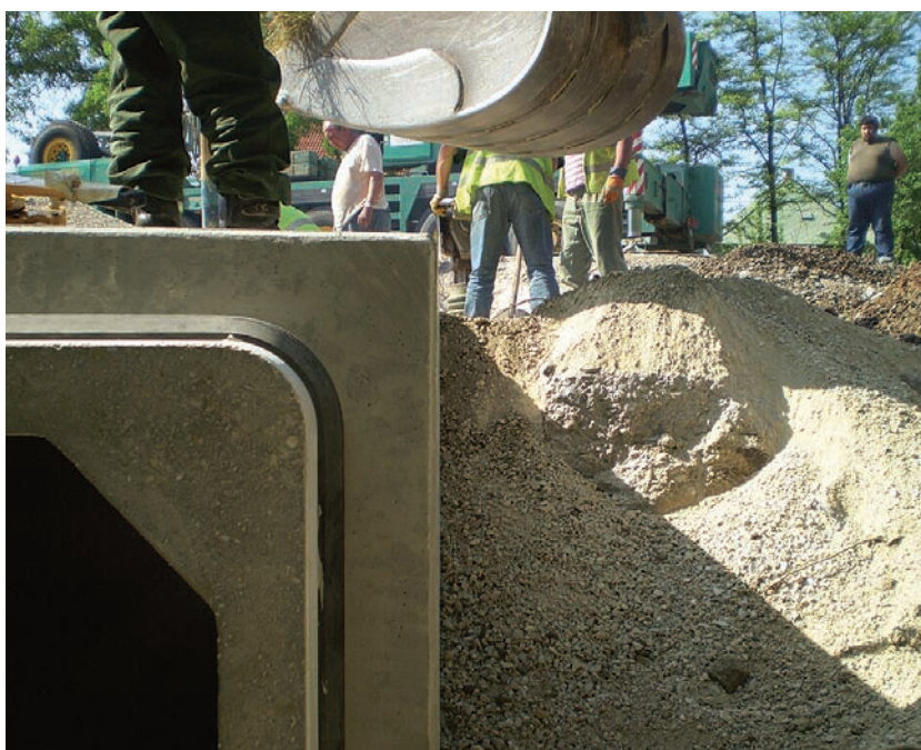
8. kép. Visszatöltés tömörítéssel
