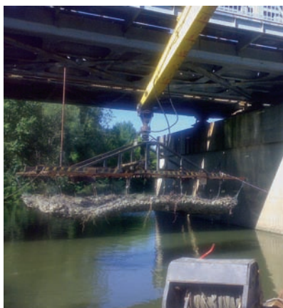
6. kép. Gyomai vasúti híd, Reno matrac beemelése
