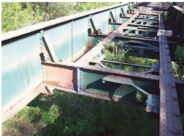
Félig ellopott vasúti híd üzemszüneteltetett vasútvonalon
