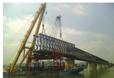
3. kép. Régi hídelem leemelése
