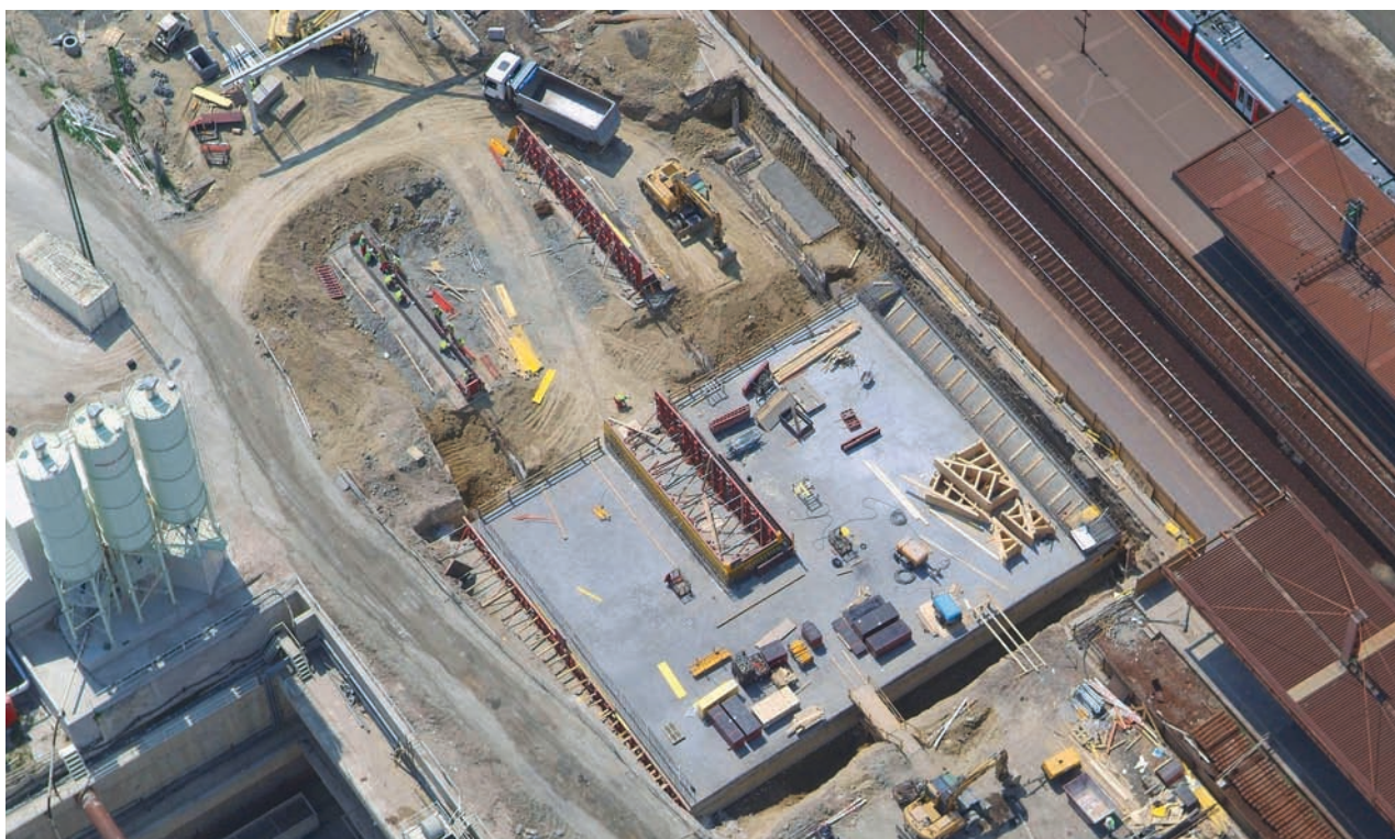
7. kép. Az U alaprajzú, három vágányt átvezető 8. lemezhid építése
