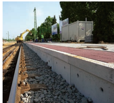
14. kép. EU L30 elemekből épített peron, Ukk
