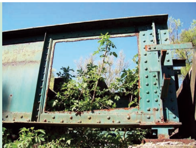
Félig ellopott vasúti híd üzemszüneteltetett vasútvonalon
