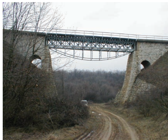
13. ábra. A 656+37 szelvényben levő híd, az alatta lévő földútról
