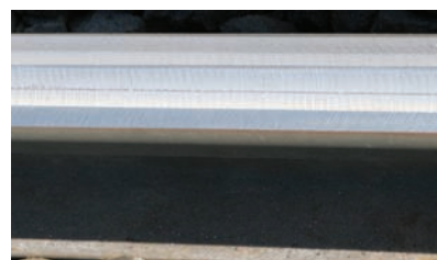
15. ábra. Mosonmagyaróvári 14-es kitérő síncsiszolás után. A köszörülés miatt szemmel nem láthatók a HC sínhibák
