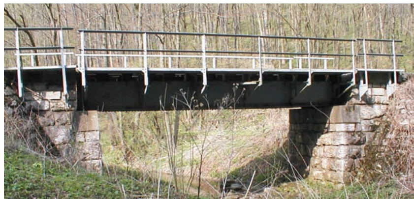
7. ábra. A híd jobb oldalról a 460+93 szelvényben
