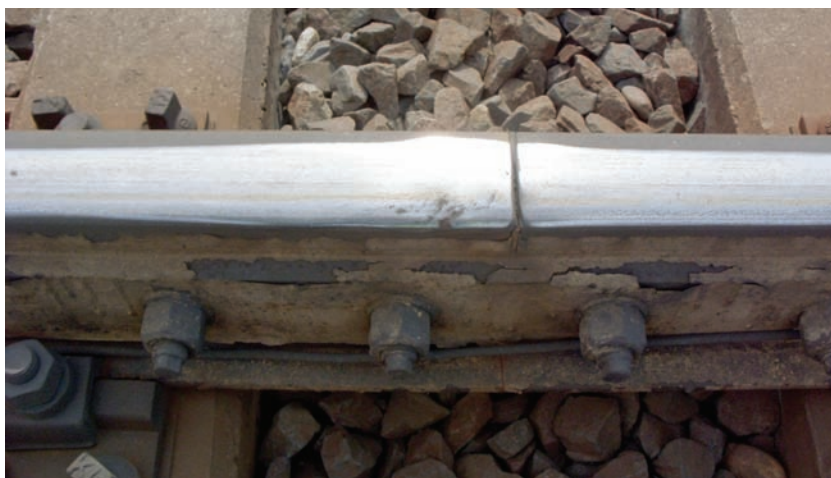
8. ábra HC hiba ragasztott szigetelt illesztésben
