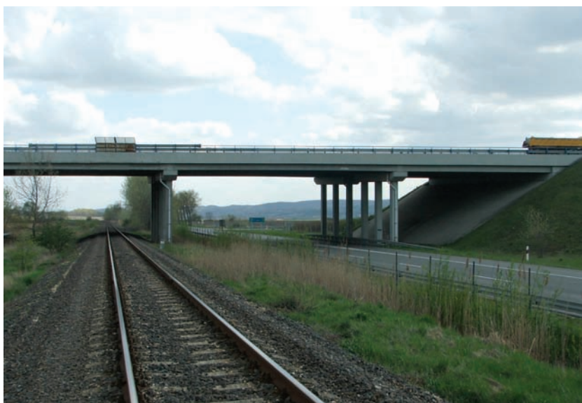
1. ábra. Az M1-es autópálya hídja a vasútvonal felett
