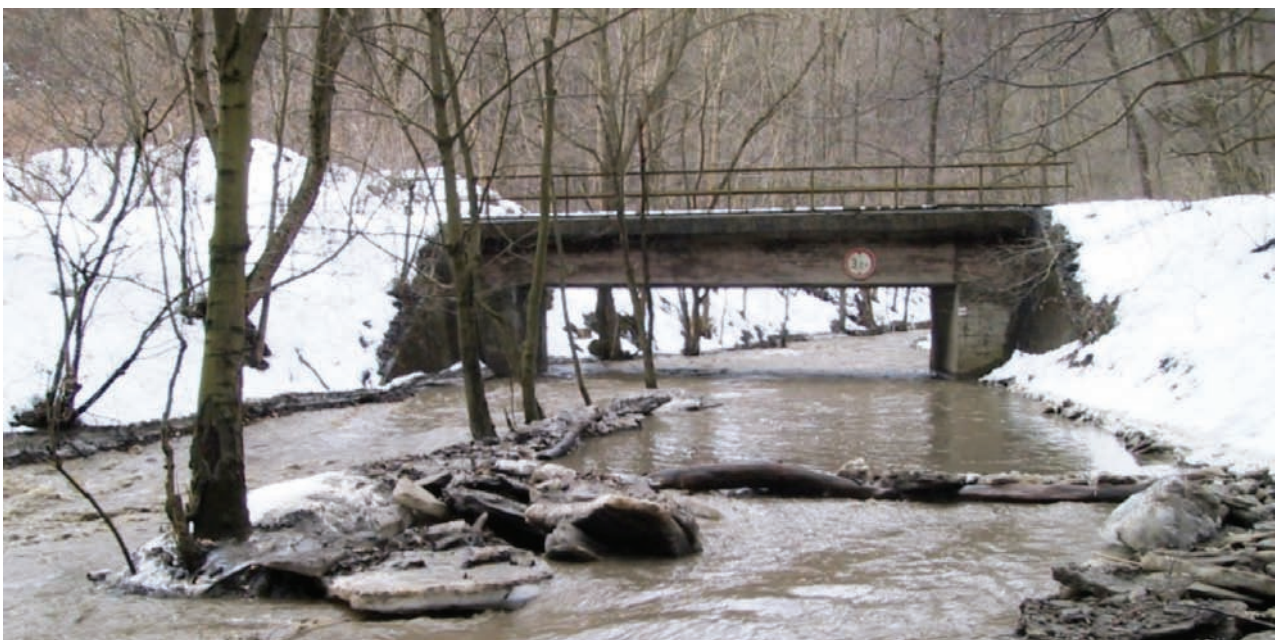
8. ábra. Híd a 416+96 szelvényben hóolvadáskor
