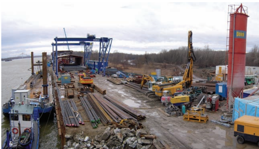
4. ábra. Építési terület
