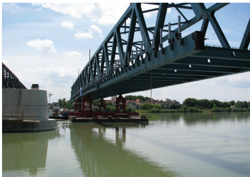
7. ábra. Az új szerkezet beúsztatása
