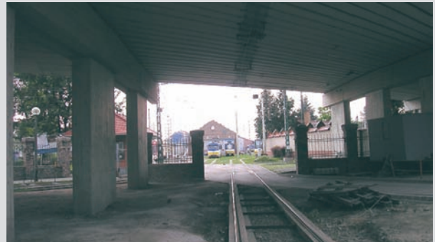
Remízbejáró vágány az Izabella híd alatt
