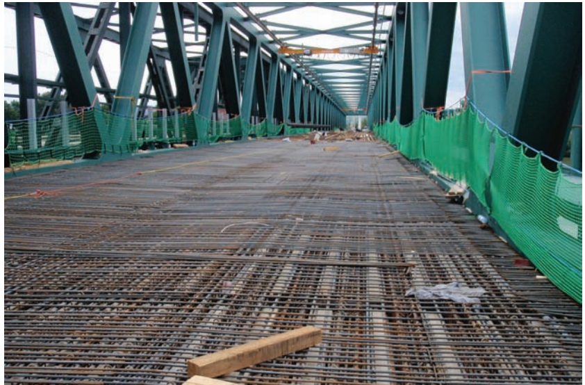
8. ábra. Pályalemez vasszerelés a portáldaruval
