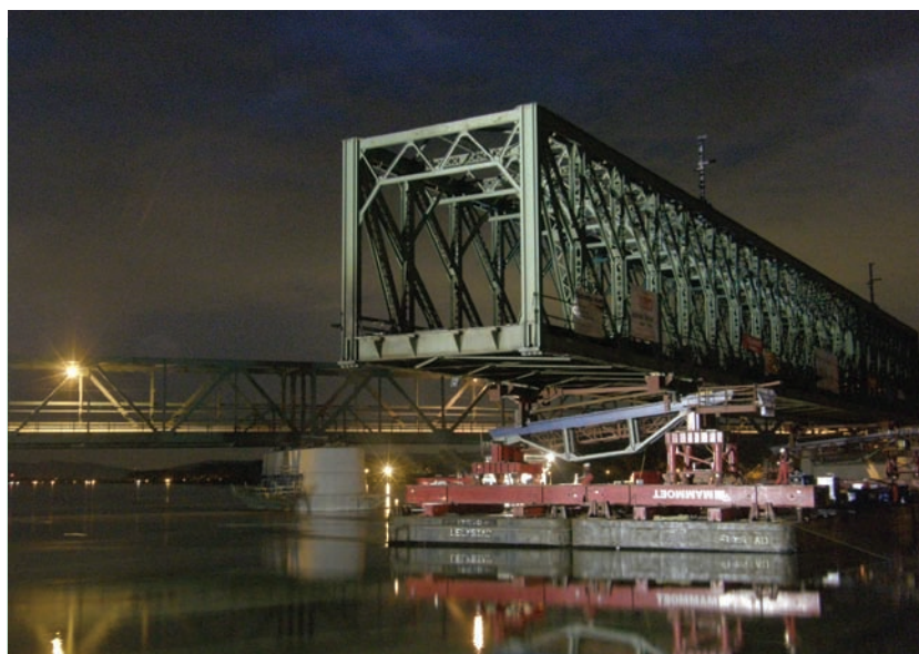
6. ábra. A régi szerkezet kiúsztatása
