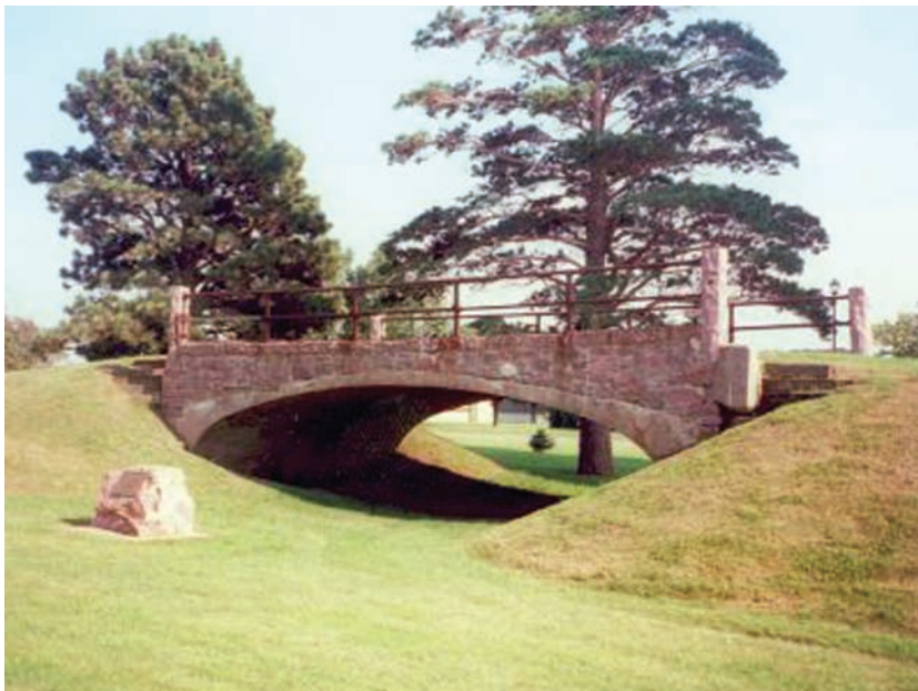
1. ábra. Rock Rapids Bridge (1894), Rock Rapids, Iowa, USA, az első Melan-rendszerű híd [7]
