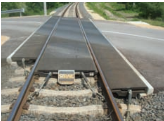
2. ábra. InnoSTRAIL burkolatú vasúti átgáró
