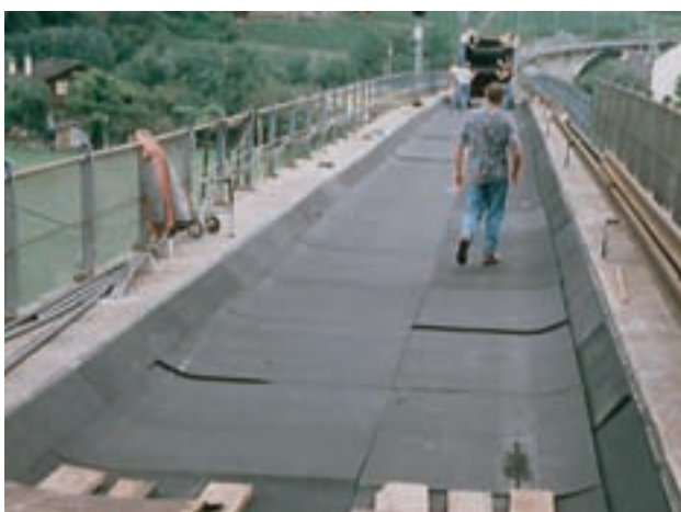
9. ábra. Ágyazat alatti szőnyeg (STRAILastic-USM) a svájci Sembrancher viadukton
