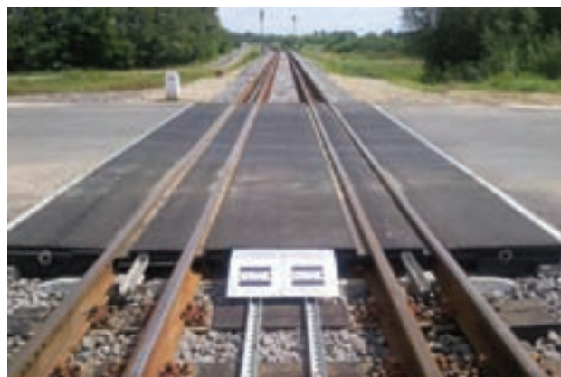
11. ábra. Forgalmobiztos speciális megoldás fonódott vágányban átépítés után
