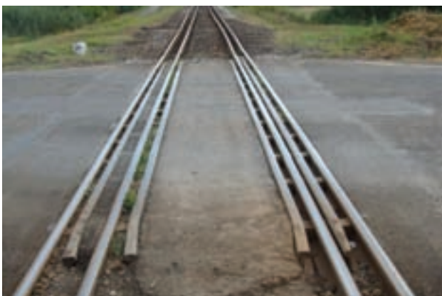
10. ábra. Fonódott vágány útátjárója átépítés előtt
