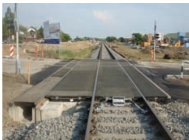
5. ábra. VeloSTRAIL víznyelőrácscsal kombinálva
