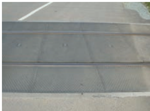
3. ábra. InnoSTRAIL-burkolat 90 cm-es elemekkel
