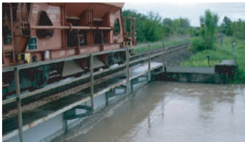
3. ábra. A 81-es vonalat keresztező Szuha-patak vízszintje elérte a hídszerkezetet
