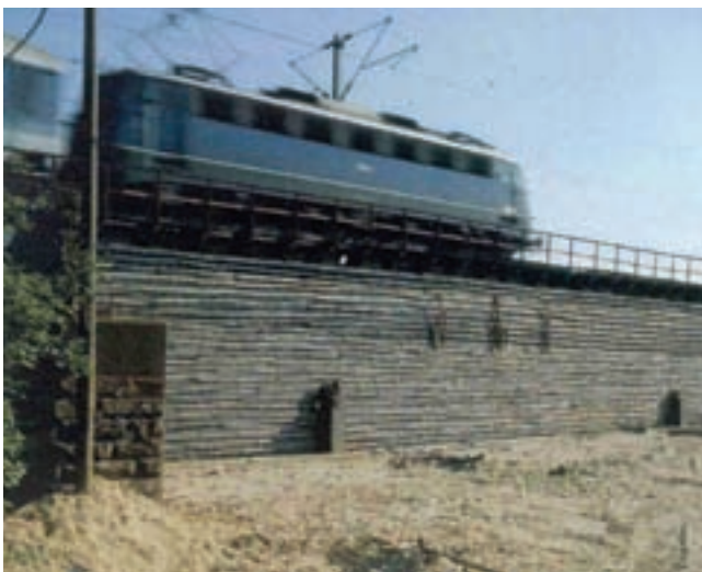
8. ábra. Vasalt támfal Heathrow-ban
