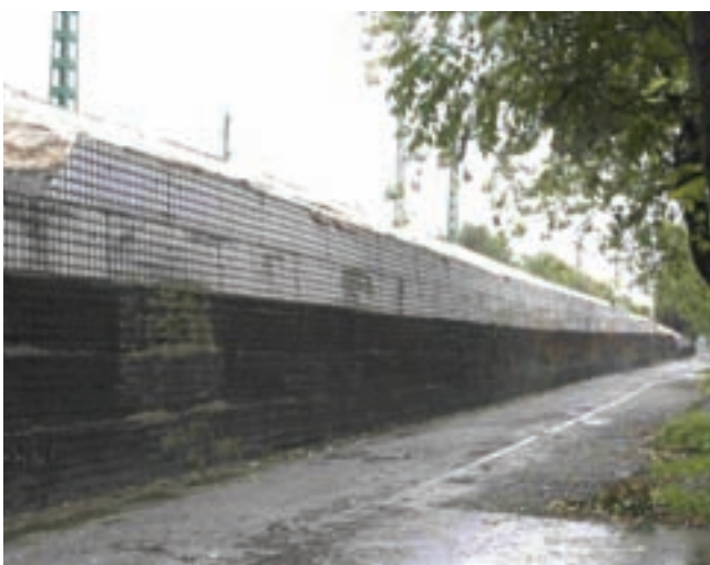
7. ábra. Töltésmeg- támasztás a csepeli HÉV vonalán
