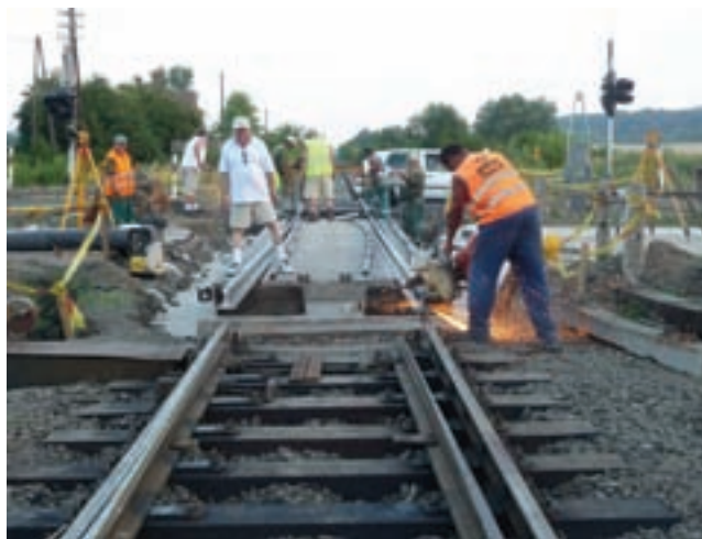
6. ábra. Sín beépítése útátjáró elembe
