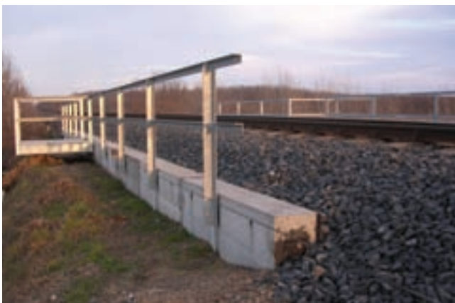
2. ábra. Beépített utófeszített bordás teherelosztó lemez
