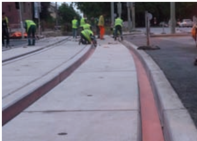
7. ábra. Átjáróelemek sínelhelyezés előtt
