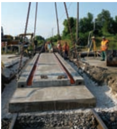
5. ábra. Helyére emelt Edilon rendszerű átjáróelem
