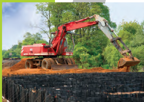
Töltésalapozás épített geocellával
