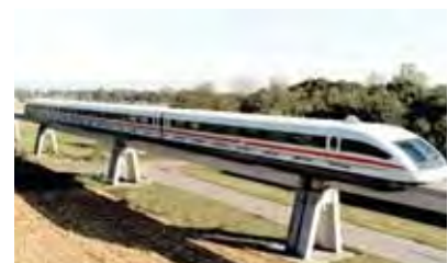
1. ábra. Pálya kiterpesztett oszlopokkal megtámasztva
