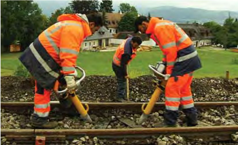
3. ábra. Y aljak alávérese függőleges kézi aláverővel
