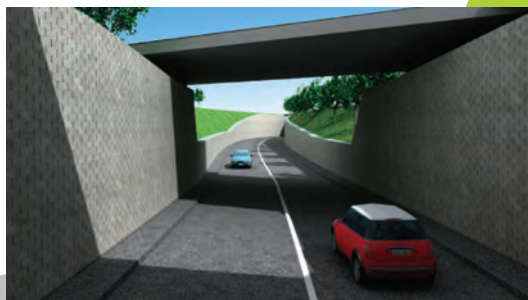
Georáccsal erősített hídhattöltések
