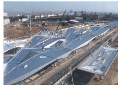
2. ábra. A tagolt tetőszerkezetű csarnok
