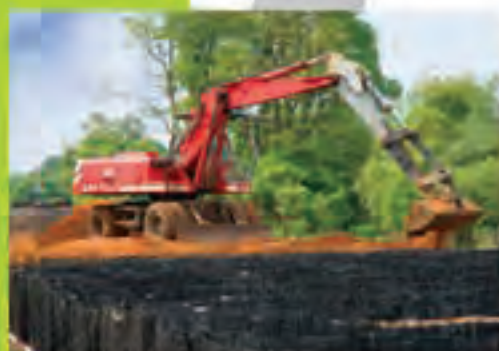
Töltésalapozás épített geocellával
