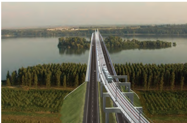
13. ábra. A Vidin–Calafat híd bevezető szakasz látványa
