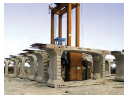
15. ábra. A Vidin–Calafat híd előre gyártott szekrénytartó elemei
