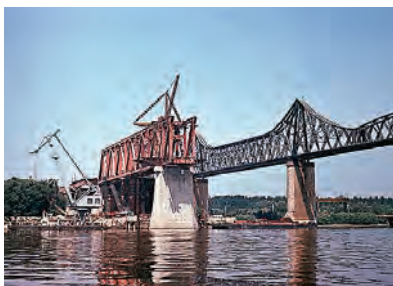
8. ábra. A Fetesti–Cernavoda híd szabadszerelése
