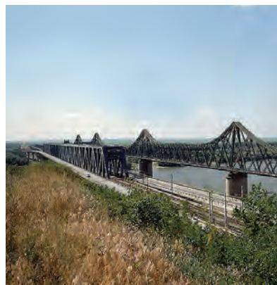
9. ábra. A Fetesti–Cernavoda híd és az I. Károly király híd
