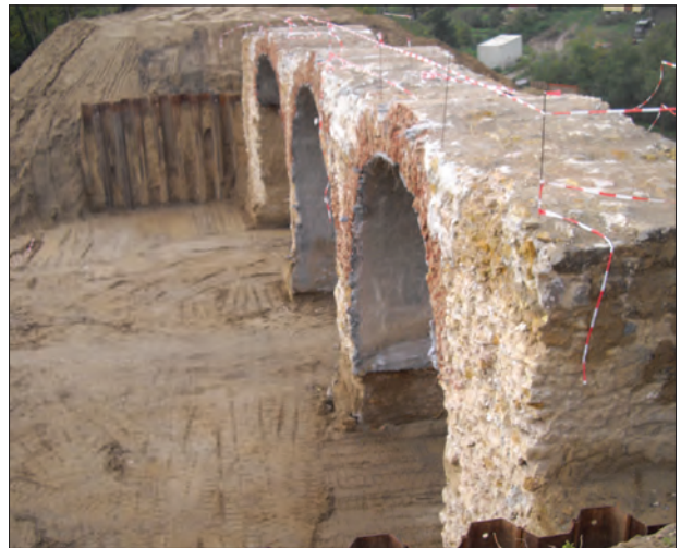
6. ábra. Pilisvörösvár, Tó utcai műtárgy átépítése
