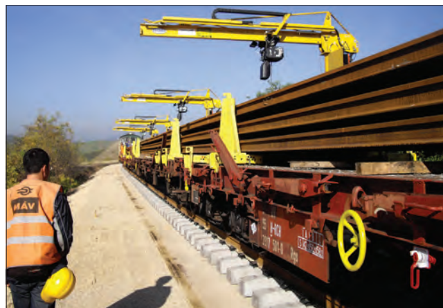
10. ábra. A bontott sínek felszedése hosszúsínfelszedő szerelvényrel
