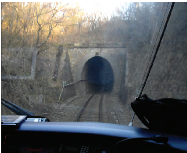
7. ábra. Az alagút bejárata vágánybontás előtt
