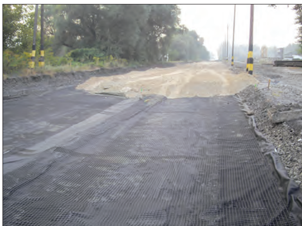
3. ábra. Az alépitmény teherbírásának javítása
