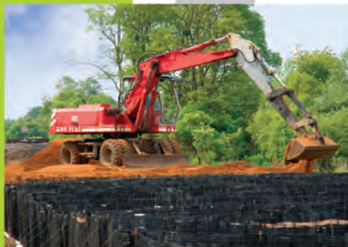
Töltésalapozás épített geocellával
