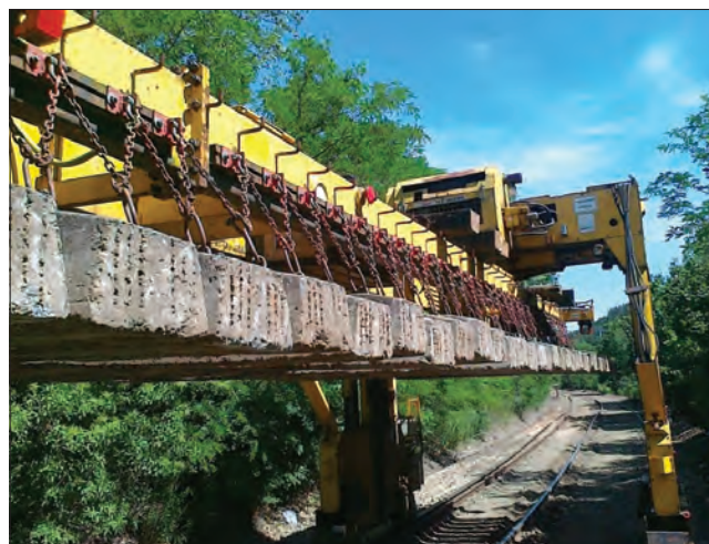
11. ábra. A bontott aljak összeszedése Donelli portáldaruval
