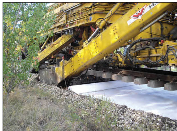
4. ábra. Geotextília beépítése rostalógéppel
