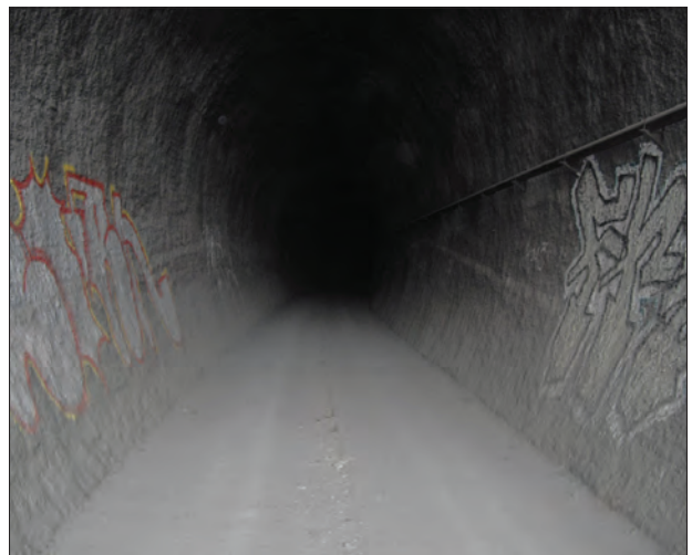
8. ábra. Az alagút vágánybontás után
