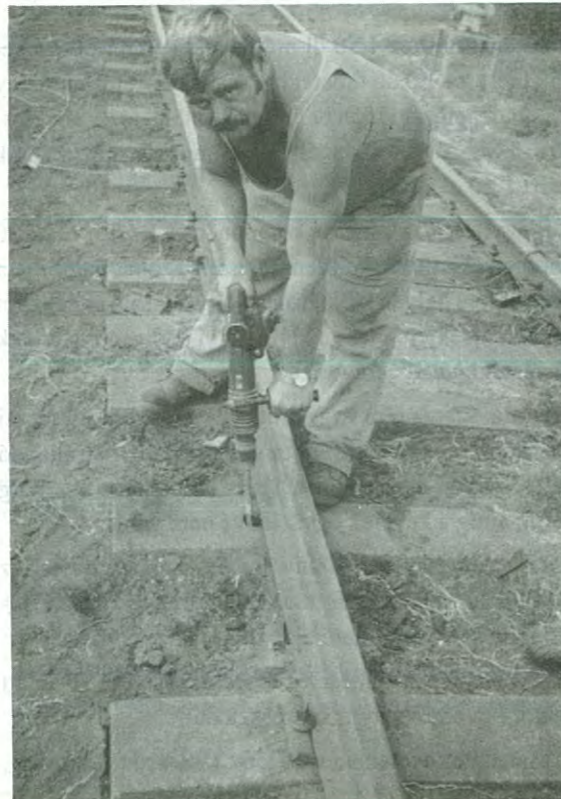
18. ábra Fabetétek felhasítása HILTI TE 72 tip.ütvefúróval
