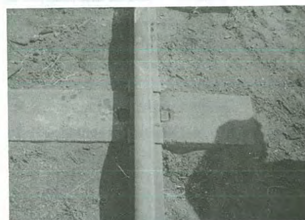
23. ábra Csonkagúla alakú fabetéttel javított vasbetonalj
