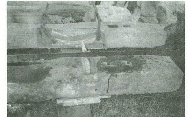
41. ábra Betonalj felület javítás előtt és után
