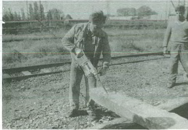
37. ábra A beton leverése KANGO 37. típusú elektromos ütve-vésővel
