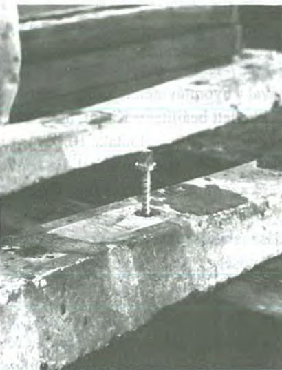
2. ábra Behajtó segédeszköz kivétele
