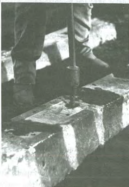
3. ábra A síncsavar behajtása
