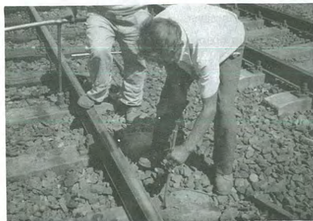
25. ábra A fabetét maradványok felhasítása vésővel és kézi kalapáccsal
