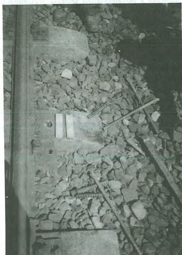
27. ábra Kézi szerszámok és összeilleszthető kétféle hullámos fabetét
