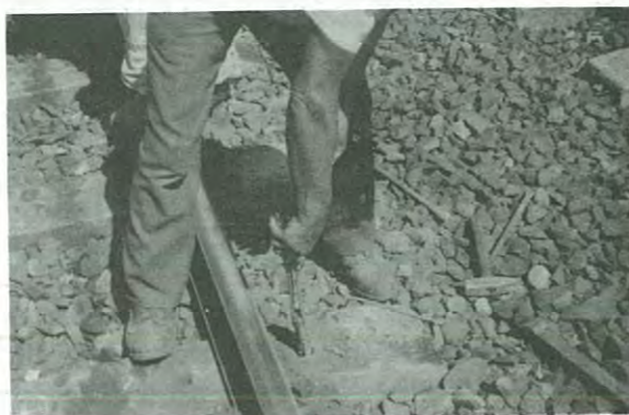
26. ábra A felhasított fabetét darabok kiszedése kovács tüzi fogóval
