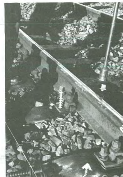
5. ábra Spirál behajtása üzemben lévő pályán
