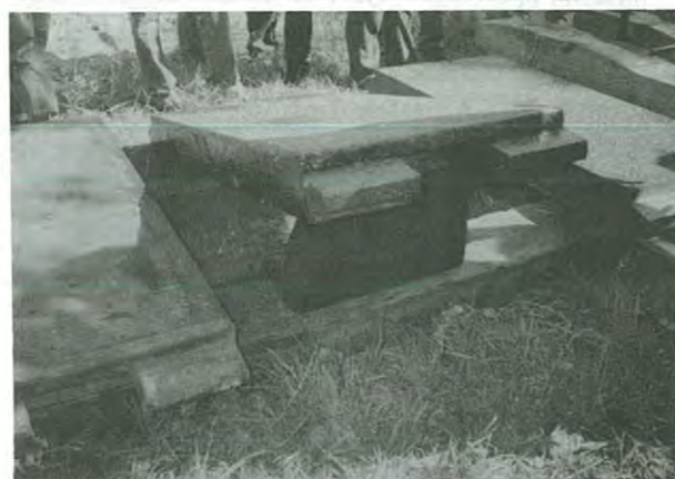
43. ábra Bodan útátjáró elem javítása
