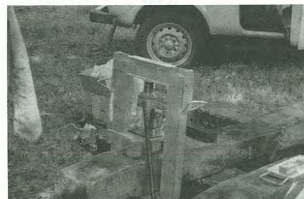
10. ábra T jelű aljából fabetéte eltávolítása
