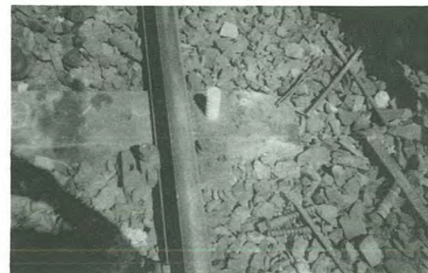
28. ábra Összeillesztett hullámos műanyagbetét félig beütve
