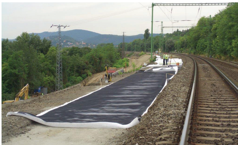
9. ábra. A cementes talajkezelésre elhelyezett szivárgópaplan (Fotó: Pokorny Bence)
