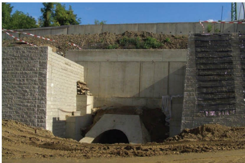
7. ábra. Az alsó támfal megszakítása és befordítása a 395+63 szelvényben lévő áteresznél (Fotó: Pokorny Bence)
