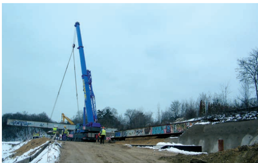
6. ábra. A provizórium bontása (Fotó: Seres Attila)
