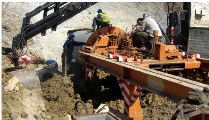
13. ábra. A Rocla áteresztő sajtolása (Fotó: Seres Attila)
