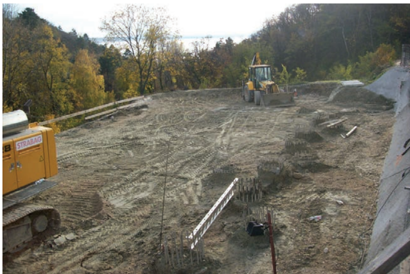
2. ábra. Az elkészült cölöpök (Fotó: Radvánszky Réka)
