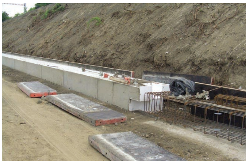
3. ábra. A homlokfelület elemeinek alapozása (Fotó: Pokorny Bence)
