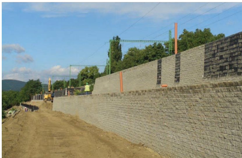
2. ábra. A kétfélepcsős megtámasztás kiselemes homlokfelülete (Fotó: Pokorny Bence)
