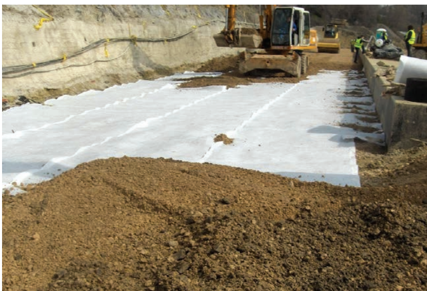
9. ábra. A geodrén paplan fektetése (Fotó: Seres Attila)
