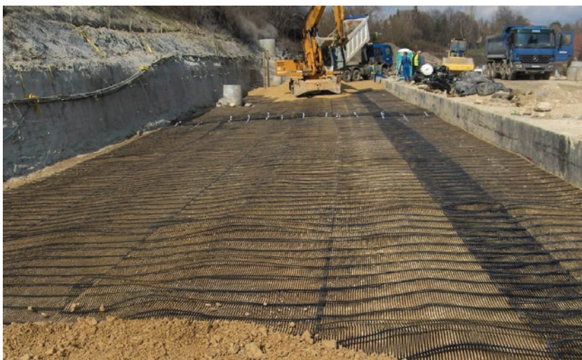
10. ábra. Georács és töltésanyag beépítése (Fotó: Seres Attila)
