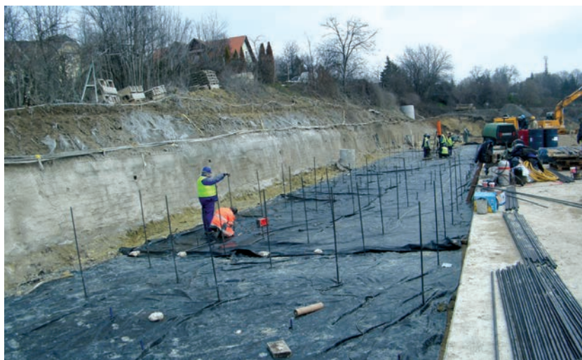
7. ábra. Az altalaj vizsgálata és injektálása (Fotó: Radvánszky Réka)
