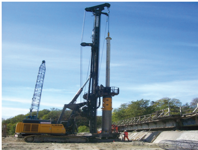
1. ábra. Párhuzamos cölöpfal építése (Fotó: Radvánszky Réka)
