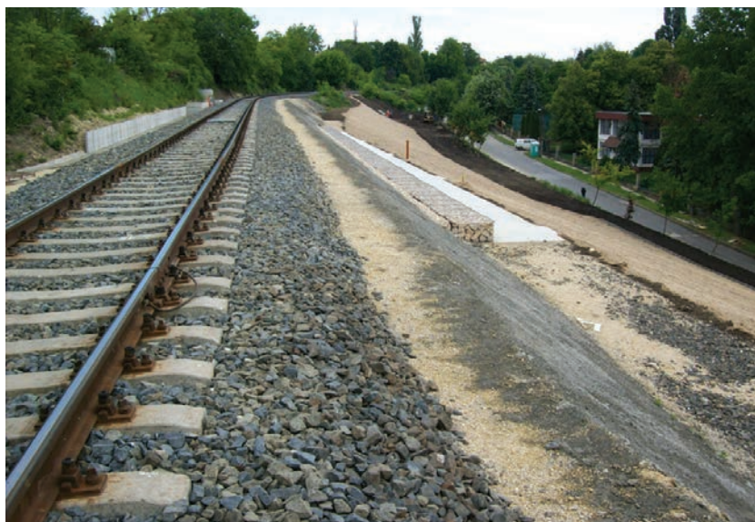
17. ábra A megvalósult rézsűstabilizálás (Fotó: Radvánszky Réka)
