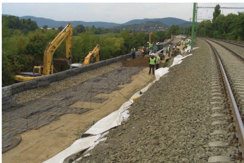
5. ábra. A támfaltestben elhelyezett georácsok (Fotó: Pokorny Bence)
