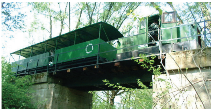
10. ábra. A 10+65 szelvényben lévő acélhíd oldalnézete (Fotó: Barabás Tibor)
