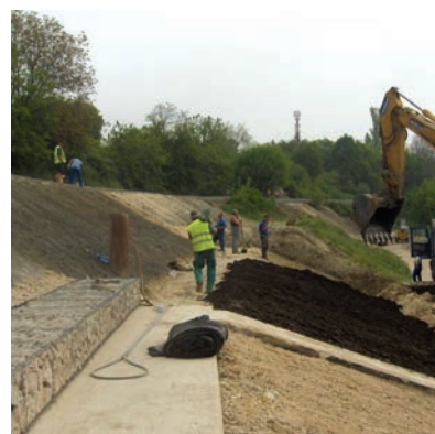
16. ábra. Kivitelezés utáni tereprendezés és rézsűvédelem készítése (Fotó: Radvánszky Réka)
