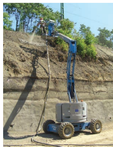
8. ábra. Talajszegezés a munkatér biztosítása érdekében (Fotó: Pokorny Bence)
