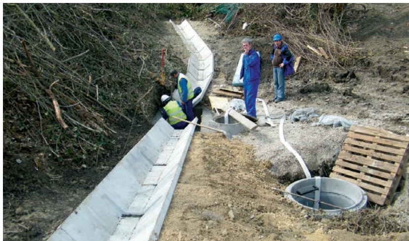
14. ábra. A végpont felőli víztelenítő rendszer kialakítása (Fotó: Radvánszky Réka)
