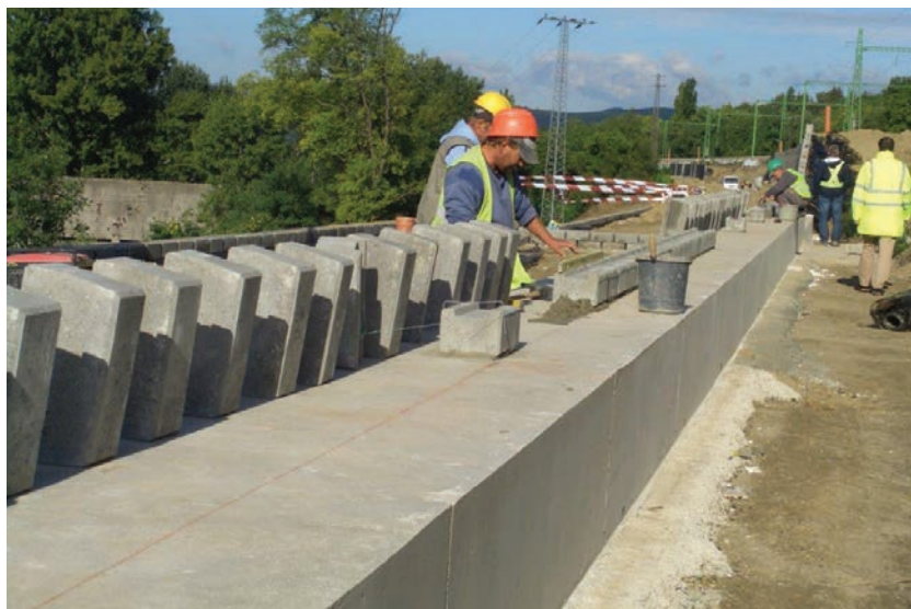
4. ábra. A homloklapló első elemsorának beépítése (Fotó: Pokorny Bence)
