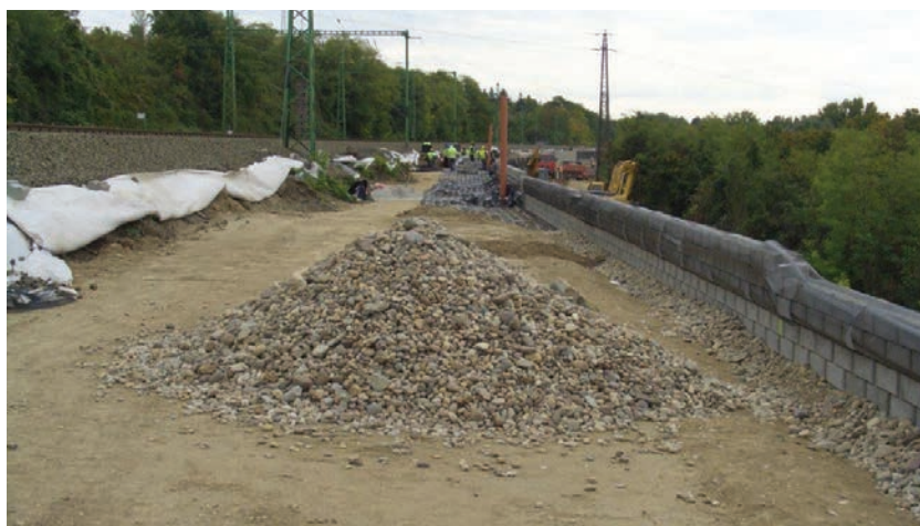
6. ábra. A homloklapló felület és a támfaltest közé kerülő páraszellőztető kavicsréteg (Fotó: Pokorny Bence)
