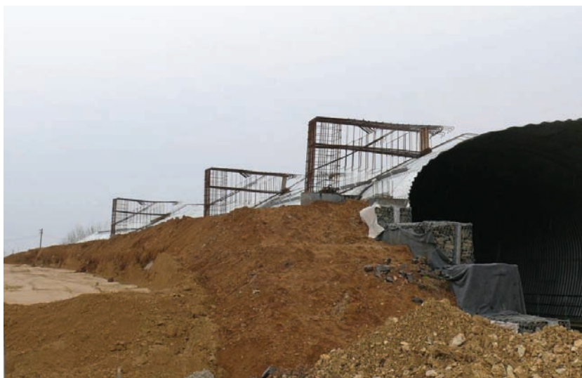
9. ábra. Földfeltöltés és a merevítőborda készítése (Fotó: Horváth Henrietta)
