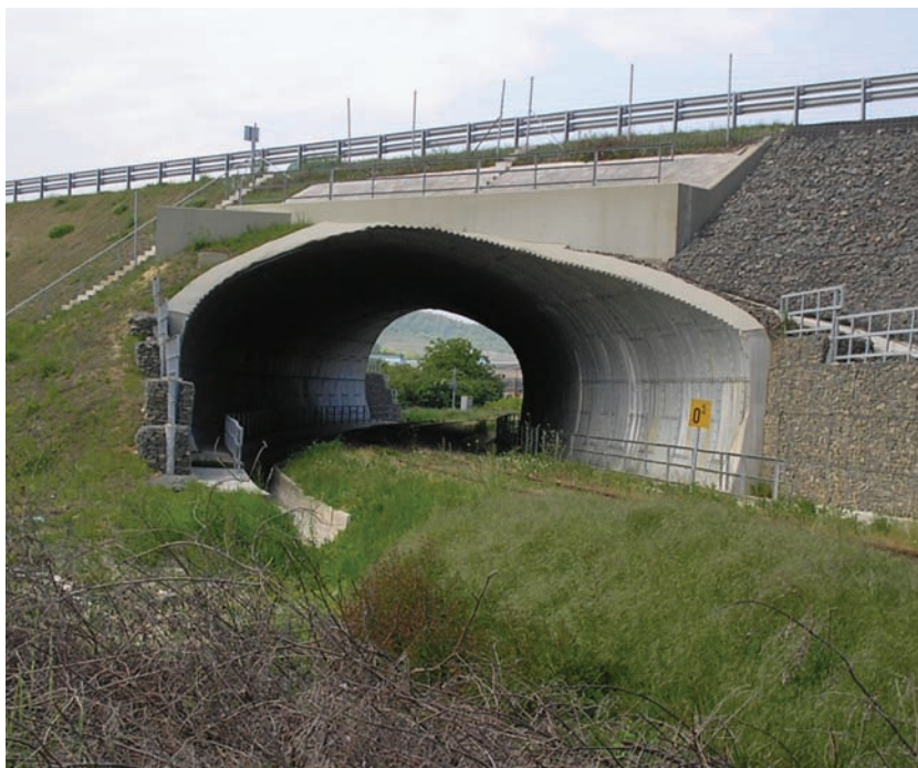
1. ábra. Tubosider műtárgy az M6-os autópálya alatt (Fotó: Bata Andrásné)
