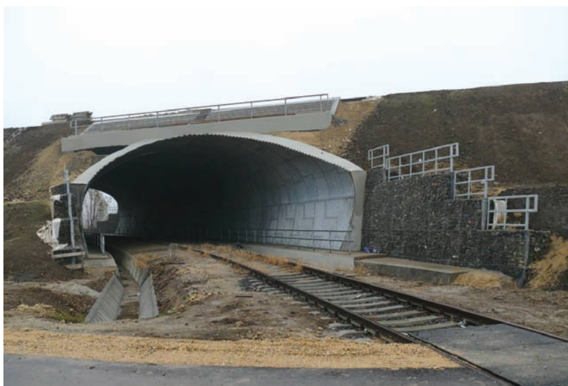
10. ábra. A befejező tereprendezési munkák a műtárgy körül (Fotó: Bata Andrásné)
