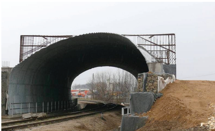
8. ábra. Földfeltöltés és gabion fal készítése (Fotó: Horváth Henrietta)
