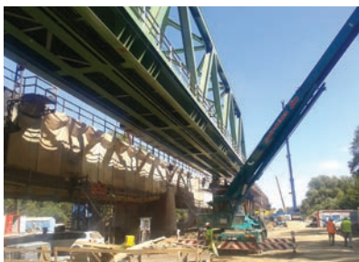
2. ábra. Az új bal vágányú szerkezet behúzása
