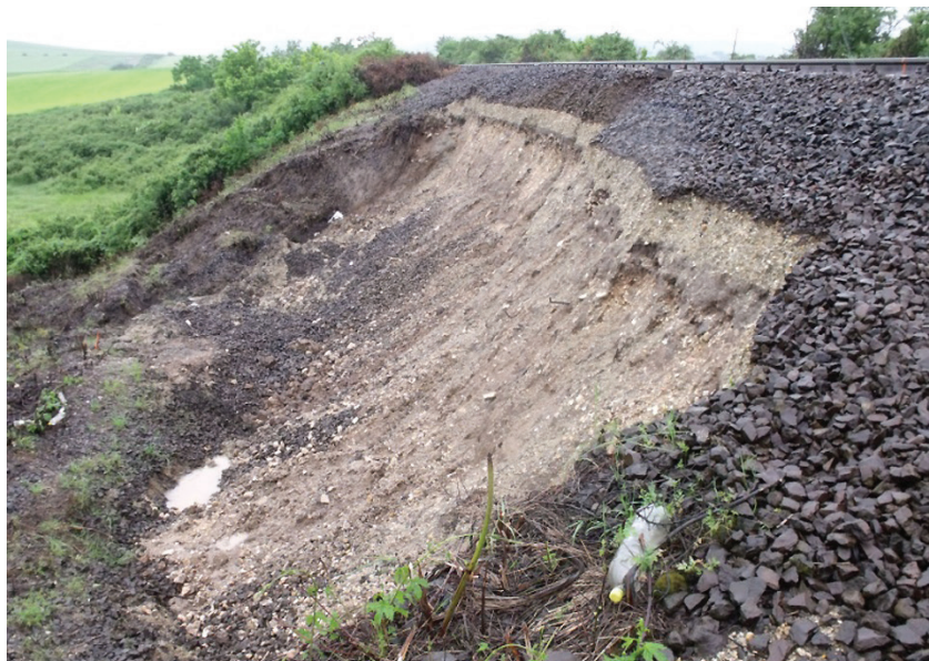
2. ábra. Átázás miatt károsodott alépítményű pályaszakasz
