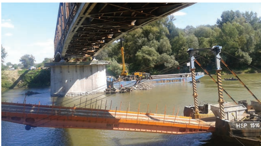
1. ábra. A segédjárom építése a Tiszán
