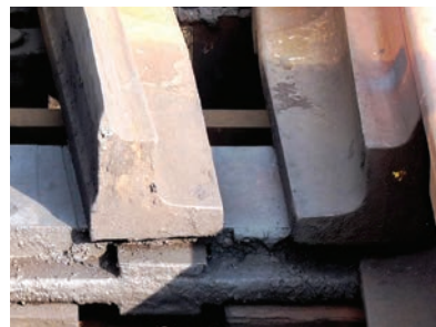
2. ábra. A sínszéken csúszó elmozdulással létrejövő váltóállító
