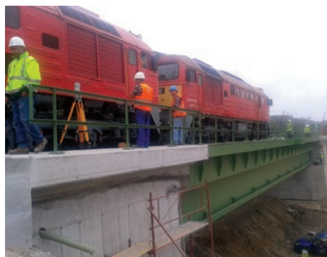
12. ábra. Az új ártéri híd próba-terhelése
