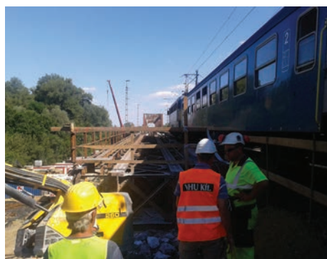
6. ábra. A megmaradó ártéri szerkezetek megerősítése
