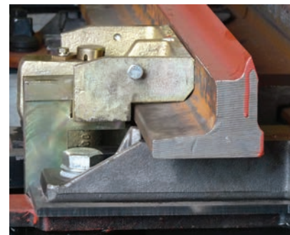
18. ábra. Az állítóerők támadási síkjai egyes 60-as rendszerű kitérőknél
