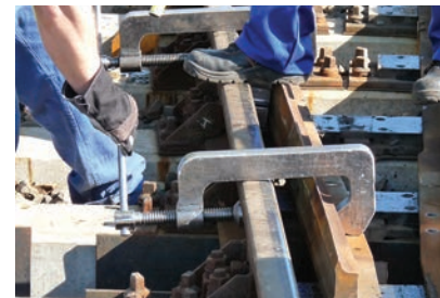
17. ábra. Alacsony szelvényű csúcscsín geometriai helyreállítása
