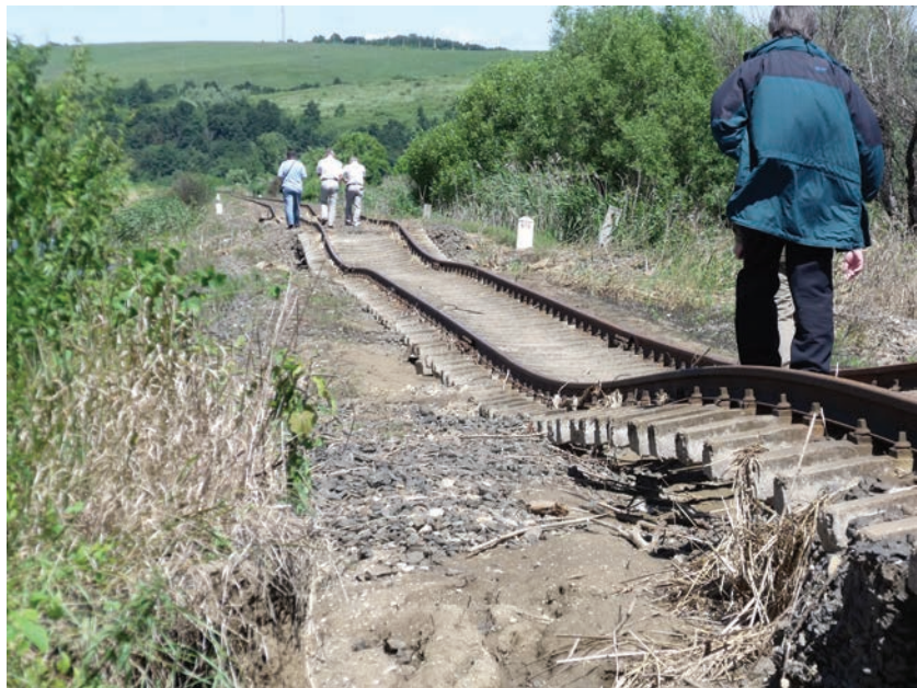
1. ábra. Leromlott alépítményű, károsodott pályaszakasz
