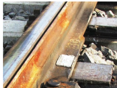
21. ábra. 54-es rendszerű átszelési kitérők csúcscsínjének gyengített talpszélessége
