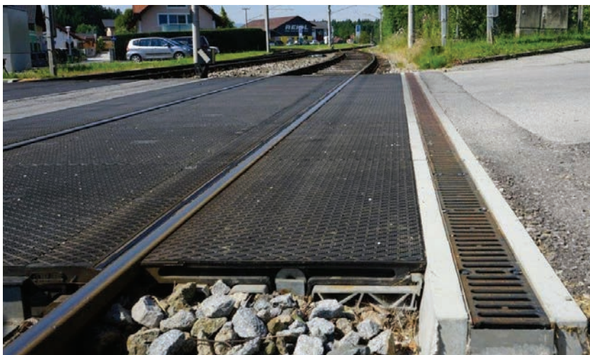
2. ábra. Szegélygerendába integrált vízvezető csatorna
