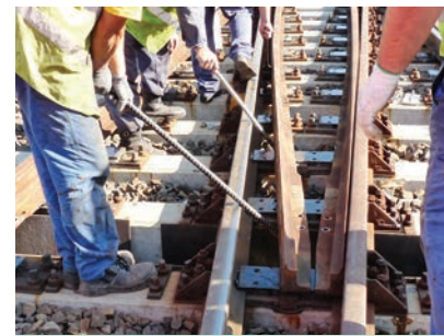
15. ábra. Leszerelt zárszerkezetek és összekötő rudak mozgatása
