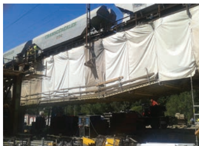
3. ábra. Vonatforgalom alatt készül az ártéri szerkezetek korrózióvédelme
