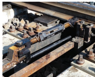
20. ábra. Új rendszerű összekötő rudazat csatlakozása
