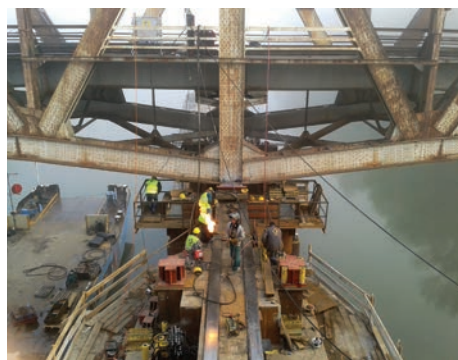
10. ábra. Az új híd-szerkezet bal vágánytengelybe húzásának előkészületei
