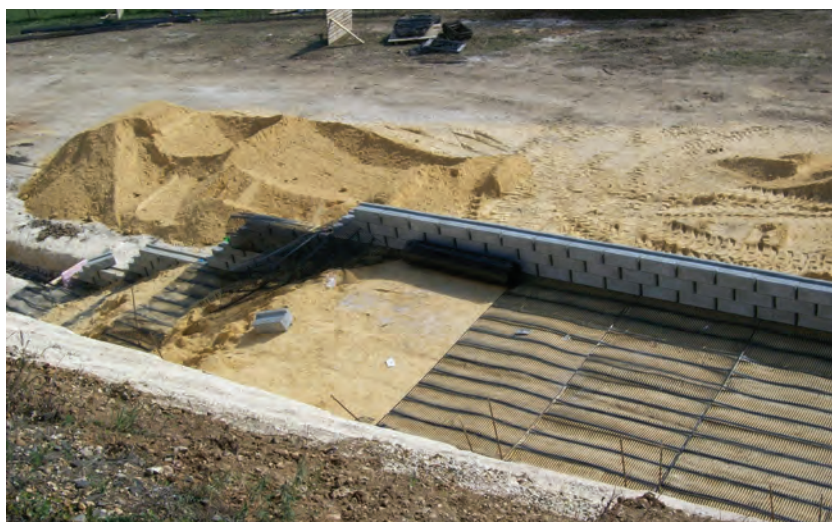
13. ábra. Kiselemes támfal hátrahorgonyzása (Fotó: Radvánszky Réka)
