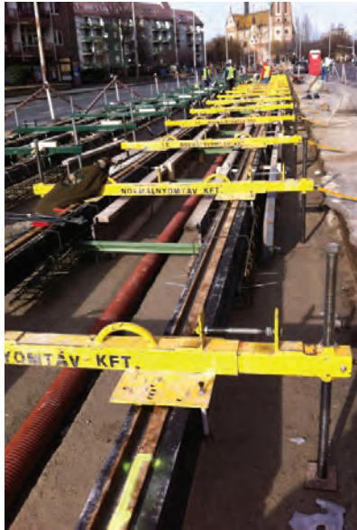
4. ábra. Épülő füves vágány a 3-as vonalon
