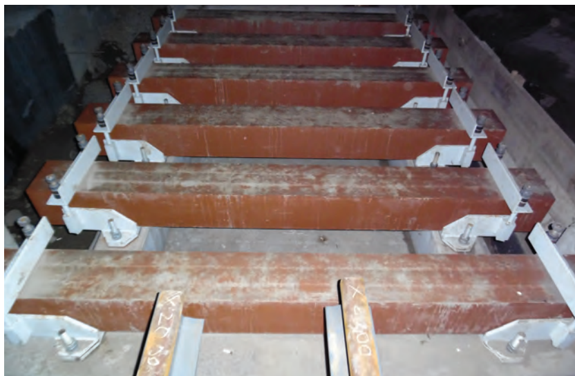
7. ábra. Bordás kiegyenlítő lemez beépítése (Fotó: Szeifert Tamás)
