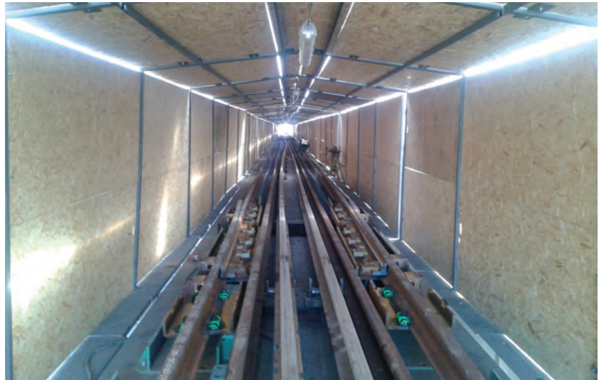
3. ábra. Fűthető sátor az Edilon kiöntéshez (Fotó: Vörös József)
