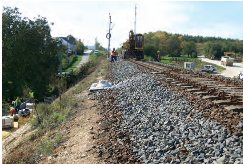
18. ábra. Felépítmény és felsővezeték-tartó oszlop bontása (Fotó: Radvánszky Réka)
