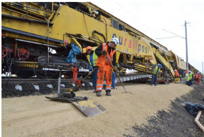
7. ábra. Alépitmény-javító géplánc, (PM200-2R) (Fotó: Virág Mihály)
