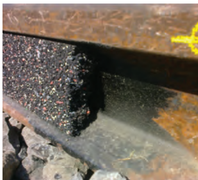
2. ábra. Bitumenes kenés és rugalmas kamraelem a 14-es villamos vonalán
