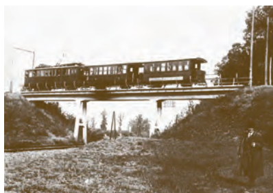
5. ábra. A sóstói felüljáró a villamossal
