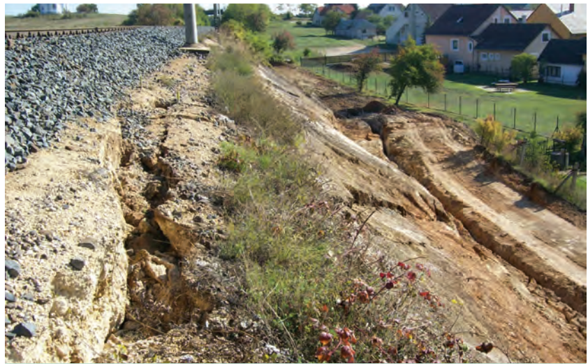
3. ábra. Töltésrészű-szakadás, 2013. október 4. (Fotó: Radvánszky Réka)
