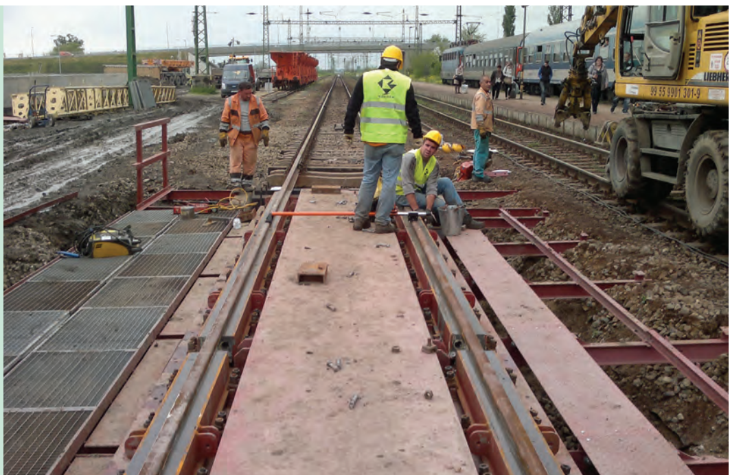
18. ábra. Rugalmas szigeteléssel kiöntött provizórium Mezőberény állomáson (Fotó: Maller Tibor).
