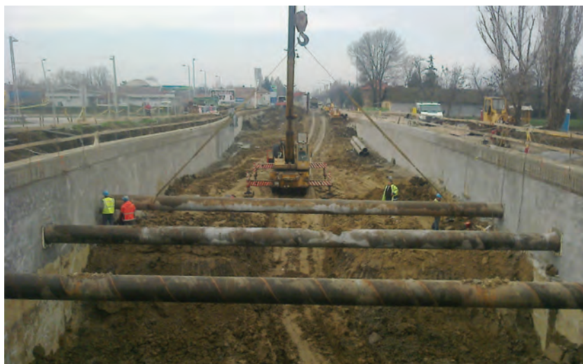
9. ábra. Földkiemelés megkezdése az épülő gyomai aluljáró rámpás szakaszán (Fotó: Vörös József)
