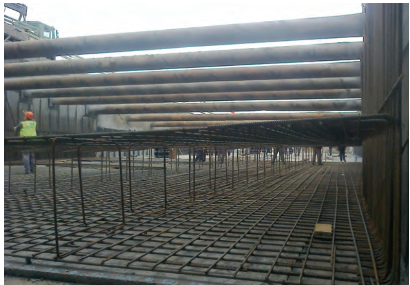
10. ábra. Feneklemez vasszerelés az aluljáró rámpás szakaszán (Fotó: Vörös József)
