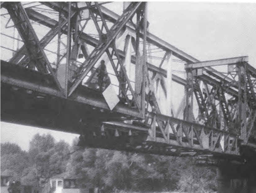
4. ábra. A gyomai Körös-híd, közepén emelhető nyílással (Fotó: Dr. Koller Ida)
