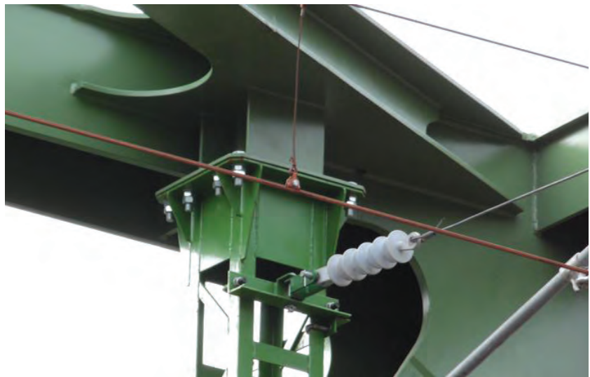
5. ábra. Villamos felsővezeték szerelése a hídon (Fotó: Szeifert Tamás)
