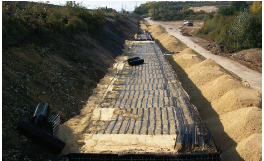
6. ábra. Jobb oldali talajtámfal építése (Fotó: Radvánszky Réka)
