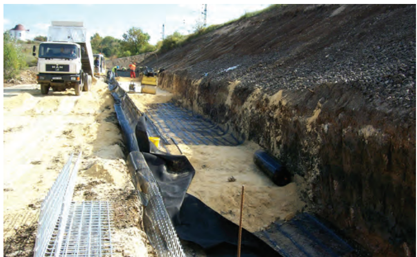
4. ábra. Jobb oldali talajtámfal alsó síkjának kialakítása (Fotó: Radvánszky Réka)
