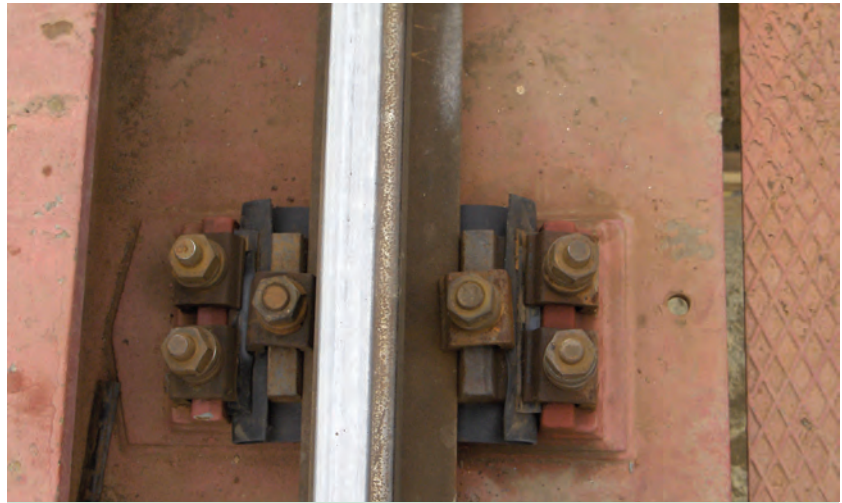
17. ábra. Biztosítóberendezési zavart okozó sínleerősítés
