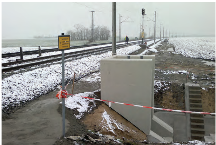
13. ábra. Zsiliplezáró az 543+03 szelvényben épült műtárgynál (Fotó: Maller Tibor)
