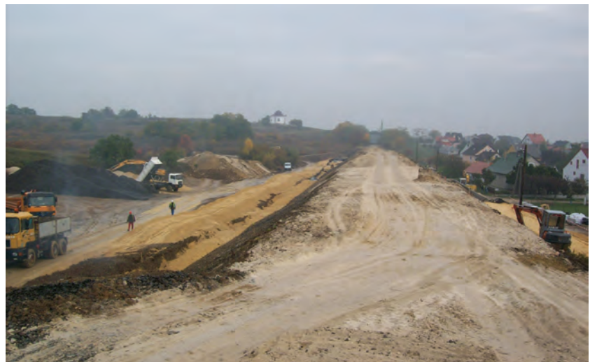
9. ábra. Földmű felső zónájának visszabontása (Fotó: Radvánszky Réka)
