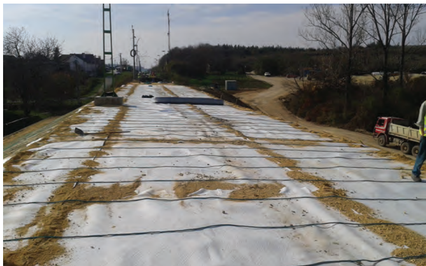
11. ábra. Szivárgópaplant terítése az új töltésanyag felületére (Fotó: Borbély Viktor)
