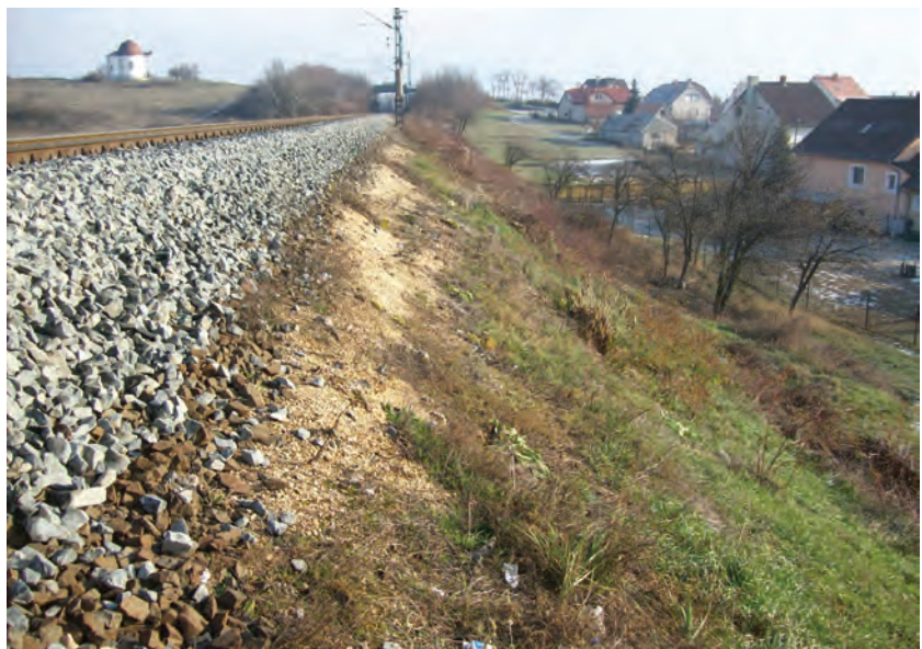
1. ábra. Deformálódott koronaél a töltés bal oldalán, 2012. december (Fotó: Radvánszky Réka)
