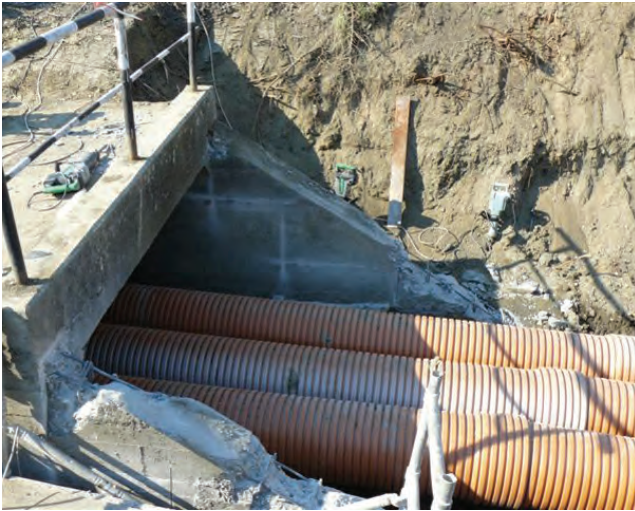
14. ábra. Ideiglenes vízátervezés a 634+70 szelvényben levő műtárgy átépítésénél (Fotó: Maller Tibor)
