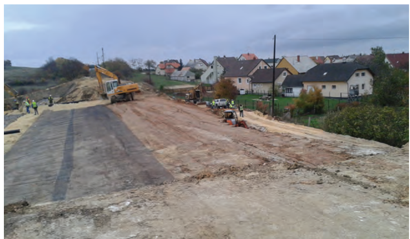
10. ábra. Georács terítése a földmű visszabontási szintjén (Fotó: Borbély Viktor)
