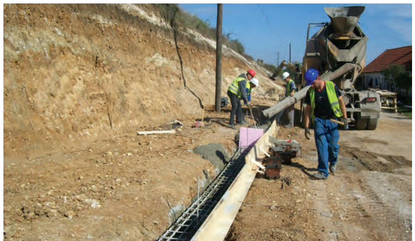
7. ábra. Bal oldali támfal alaptest építése (Fotó: Radvánszky Réka)
