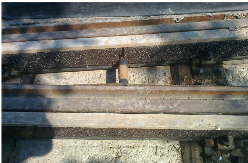
1. ábra. Az első kamraelemekkel burkolt kiterő építés közben
