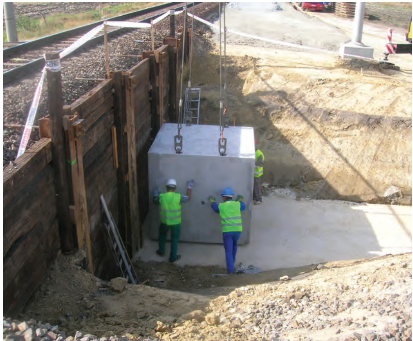
12. ábra. Keretelem beemelése az üzemelő vágány megtámasztása mellett (Fotó: Vörös József)
