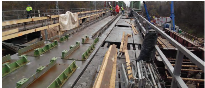
1. ábra. Az ártéri hídon az ortotróp pályalemezen megkezdődik az Edilon vályú szerelése (Fotó: Szeifert Tamás)
