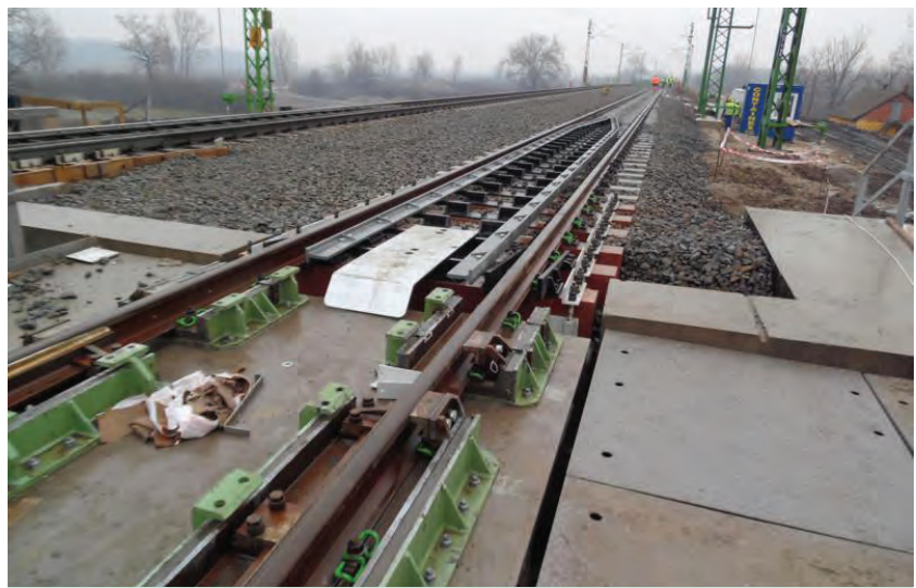
4. ábra. Síndilatációs készülék beépítése (Fotó: Szeifert Tamás)
