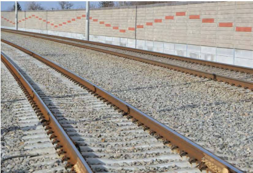
6. ábra. Az átépült új vasúti pálya zajvédelemmel (Fotó: Virág Mihály)
