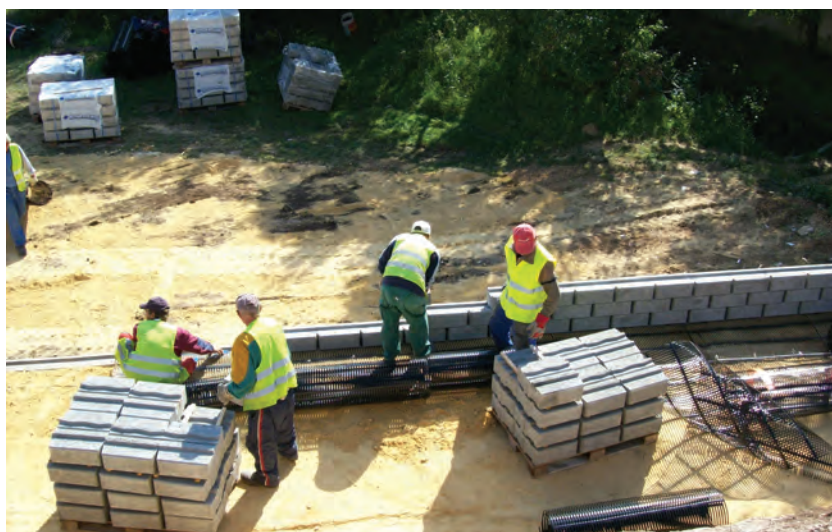
12. ábra. Támfal homlokfelületi betonelemeinek építése (Fotó: Radvánszky Réka)
