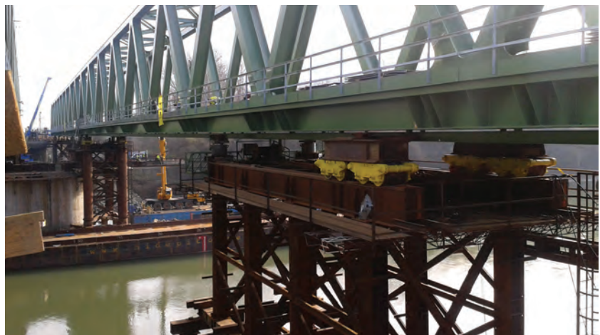
2. ábra. Mederhíd jobb vágány szerkezetének betolása a korábban már megépült pályán (Fotó: Szeifert Tamás)
