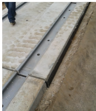
8. ábra. Úsztatott nagypaneles vágány építése a 61-es villamos vonalán
