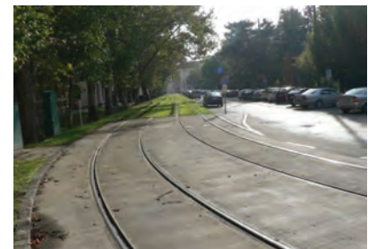
9. ábra. Az 1-es sz. villamosvonal rezgécsillapított szakasza és a Széchenyi téri fűvesített szakasz
