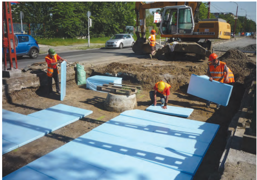
11. ábra. XPS védőréteg beépítés közben
