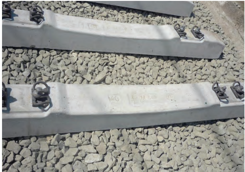
10. ábra. LM-S aljak W14 leeresztéshez, 1:40 síndőléssel
