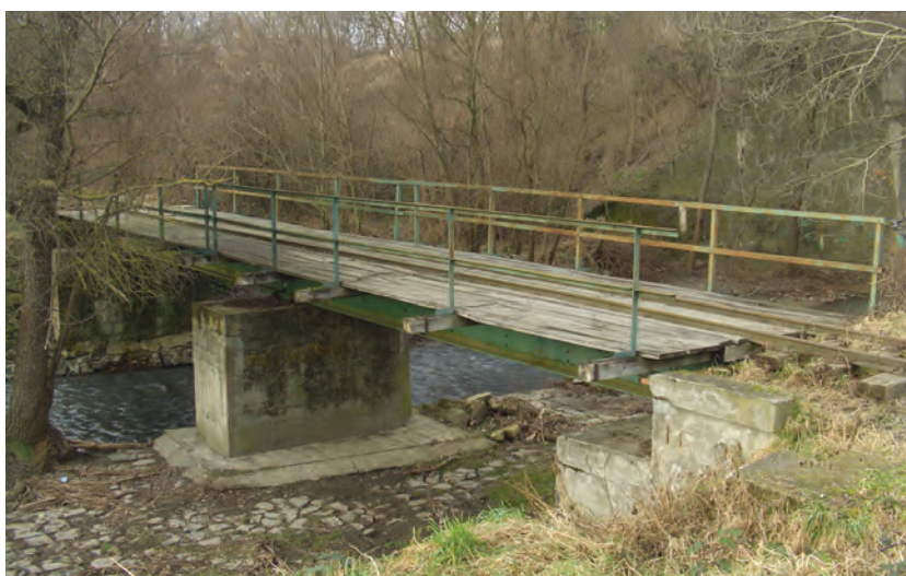
6. ábra. A Kismaros–Verőce szakasz 5+31 szelvényében található acélhíd (Fotó: Pokorny Bence)
