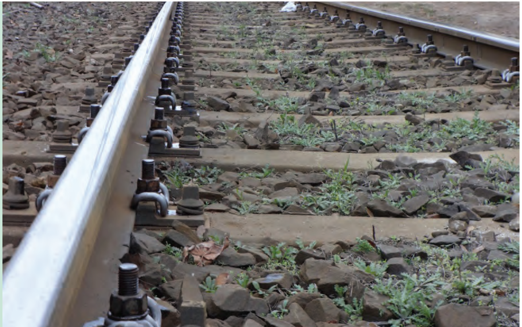
14. ábra. NiroTec bevonatos, Skl-19-es rugók (Béke tér)
