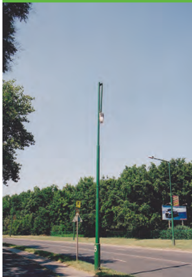
1–2. ábra. Festett térvilágító oszlop lámpakarok korrózió miatti tönkremenetele
