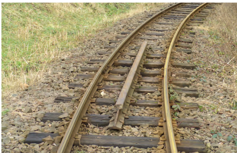
5. ábra. Kis sugarú ívben alkalmazott megoldás az ív könyökösödése ellen (Fotó: Pokorny Bence)
