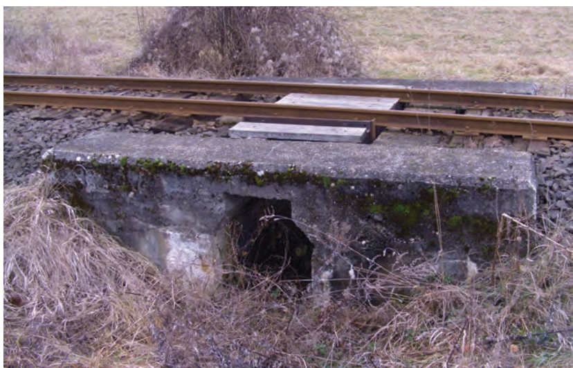
7. ábra. Nyílt átereszt a 77+76 szelvényben (Fotó: Pokorny Bence)
