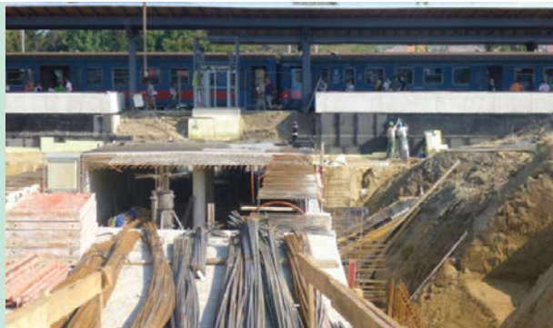
8. ábra. Gyalogos-aluljáró építése liftaknával forgalom alatt
