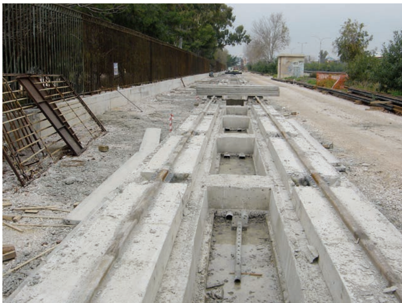
1. ábra. Külföldi példa pályagerenda kialakítására
