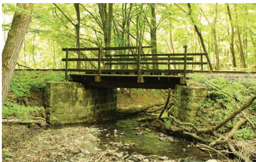
8. ábra. 4,0 m nyílású faszerkezetű híd a Nagybörzsöny–Kisirtás szakaszon
