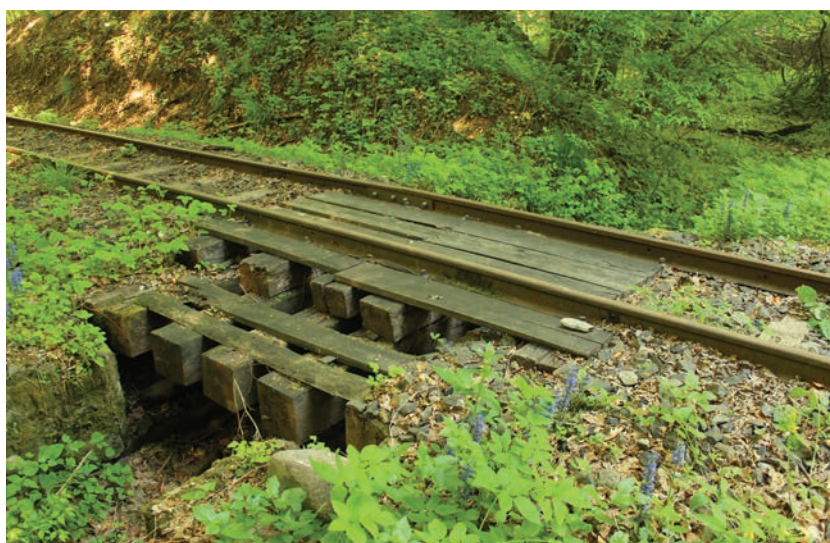
9. ábra. 1,0 m nyílású nyílt átereszt a Nagybörzsöny–Kisirtás szakaszon (Fotók: Pokorný Bence)
