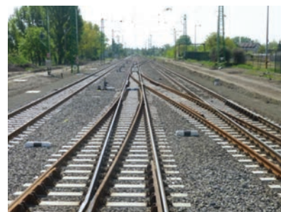
12. ábra. Kezdőpont felőli állomásfej az átépítés után
