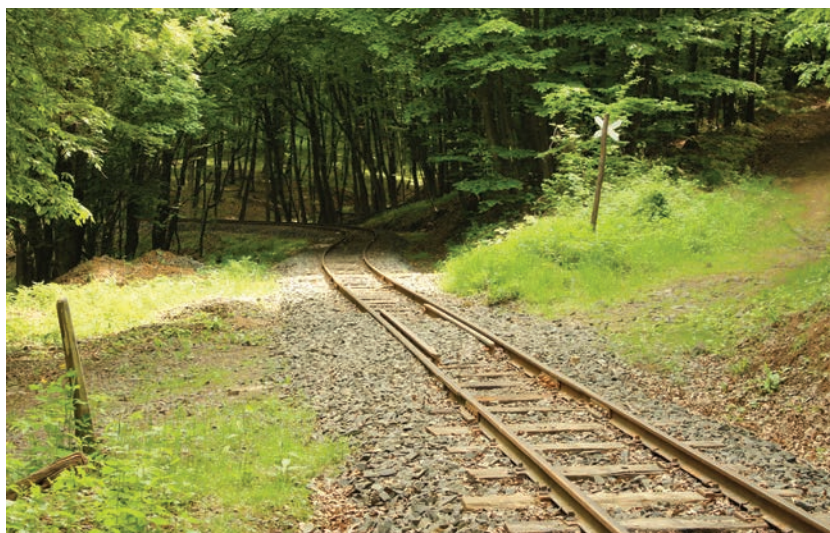
7. ábra. Útátjáró a Kisirtás–Nagytárs szakaszon
