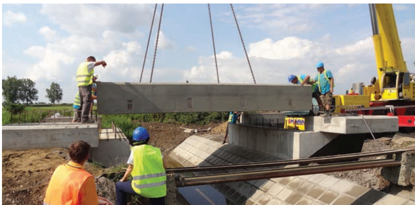
6. ábra. Épülő műtárgy Dombóvár és Kaposvár között, 2014
