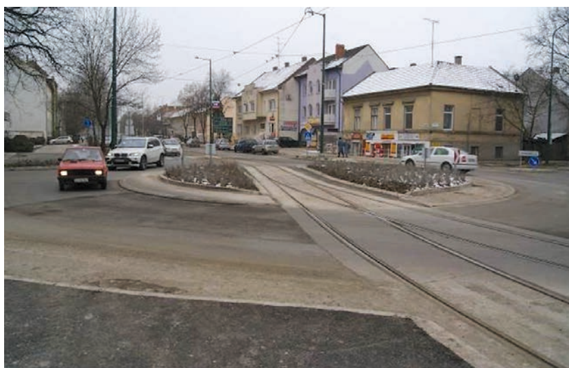
9. ábra. A 3-as villamos bazaltbeton burkolatú kitérője a körforgalmi csomópontban
