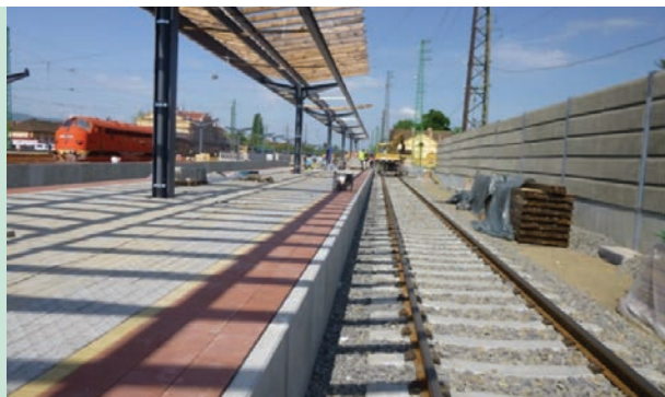
9. ábra. A jobb oldali gabion támfalra épített zajárnyékoló fal
