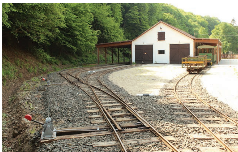
6. ábra. A nagybörzsönyi telephely 9 kg/fm rendszerű vágányai
