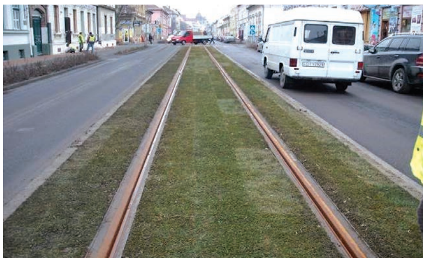
10. ábra. A 3-as villamos egyvágányú füvesített pályaszakasza
