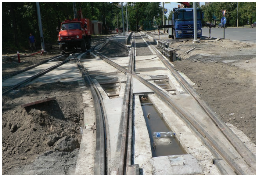
7. ábra. A 2-es villamos fűvesíthető kitérője humuszolás előtt
