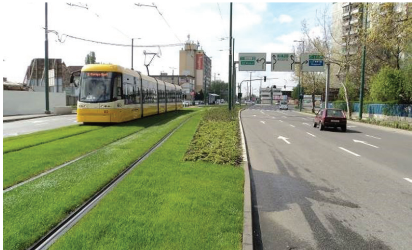
6. ábra. Szeged 2-es villamosvonal fűvesített kialakítása
