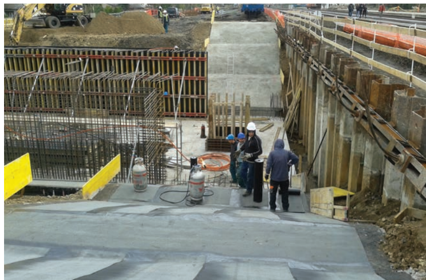
1. ábra. A Larssen-fal hátrahorgonyozása feszített horgonyokkal (Fotó: Feczko Róbert)
