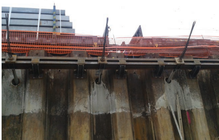
7. ábra. A megfeszített talajhorgonyok (Fotó: Vörös József)
