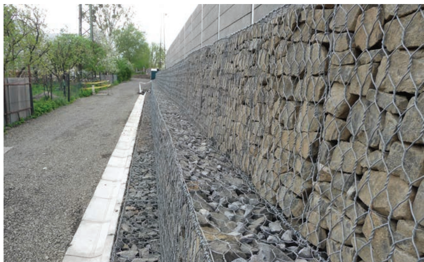
6. ábra. Az elkészült Gabion támfal a zajvédő fallal (Fotó: Szeifert Tamás)
