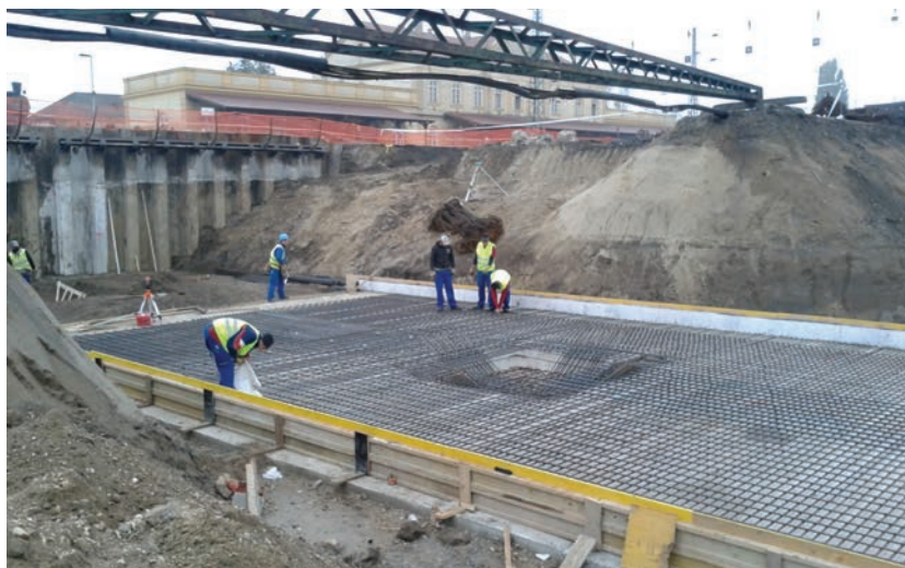
2. ábra. Alaplemez vasszerelése és kábelfelfüggesztés (Fotó: Feczko Róbert)
