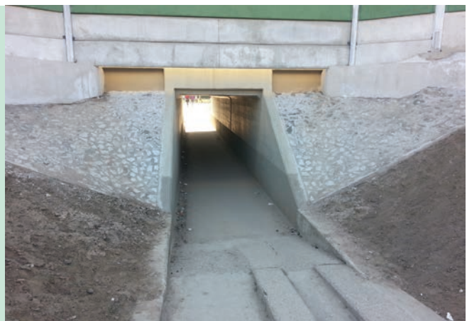
13. ábra. Gyalogos-aluljáró a felújítás után (Fotó: Feczkó Róbert)
