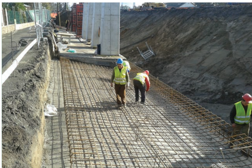
4. ábra. Gabion támfal alapozása (Fotó: Feczko Róbert)
