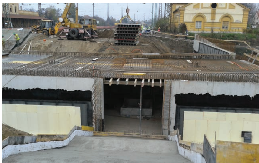
3. ábra. Keresztfolyosó és lépcsőkar építése (Fotó: Feczko Róbert)
