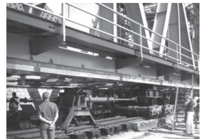
10. ábra. A csongrádi Tisza-mederhíd vízszintes mozgatásához alkalmazott hidraulikus tolóberendezés
