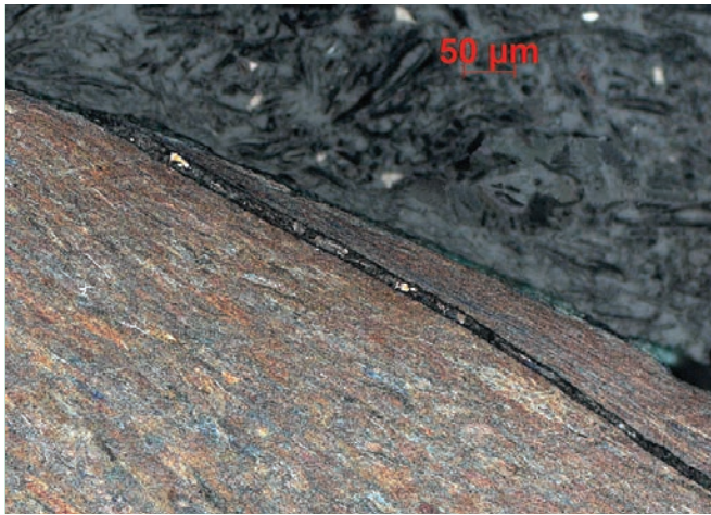
2. ábra. A hajszálrepedések terjedése a sínfejben
