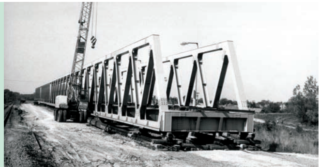
14. ábra. A tunyogmatolcsi Szamos-híd acélszerkezete a szerelőterén 1986. május 6-án
