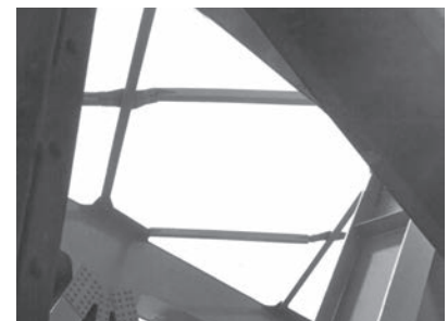
19. ábra. A csongrádi Tisza-híd felső szélrácsának elhajolt csomólemezei
