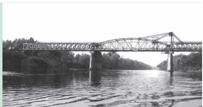
15. ábra. Ideiglenes pilon a régi tunyogmatolcsi Szamos-híd bontásához 1987. október 15-én
