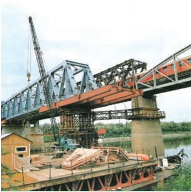
7. ábra. A csongrádi Tisza-mederhíd szerelése [2]
