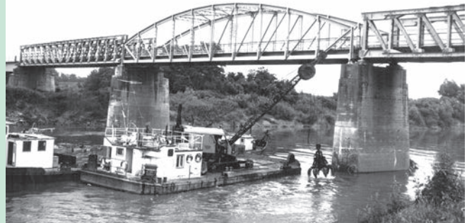
13. ábra. Az új tunyogmatolcsi Szamos-híd alapozása előtti mederkotrás 1984. július 19-én
