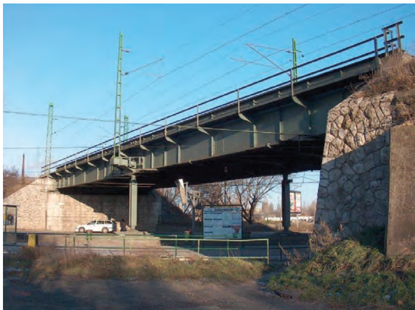
7. ábra. A vonal legnagyobb vasúti hídja a Soroksári úti felüljáró (Fotó: Pulisch József)
