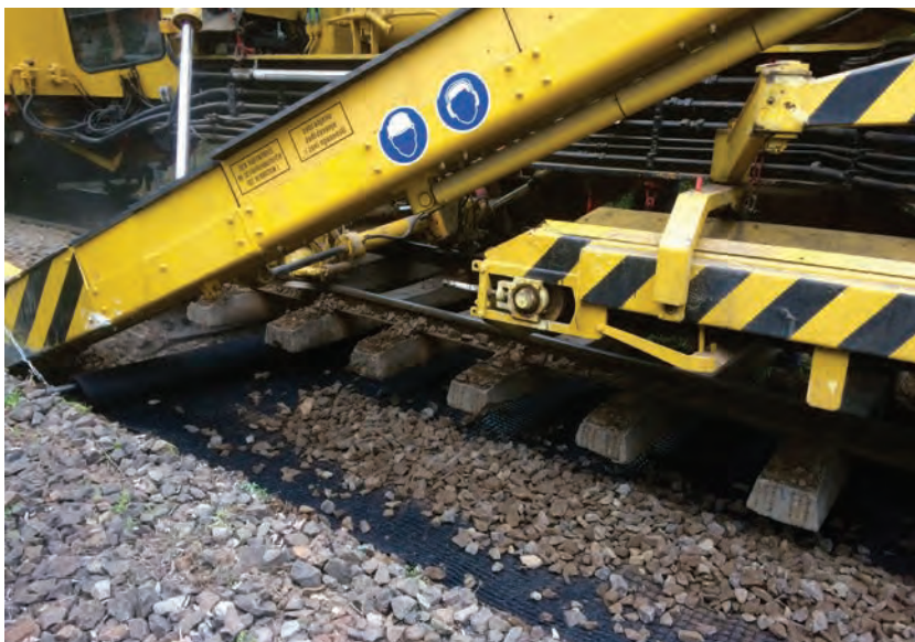
5. ábra. Georács-kompozit beépítése erősítés (ágyazatstabilizálás), elválasztás és szűrés funkciókkal – Ráckeve, 2015
