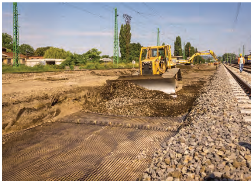
4. ábra. Georács beépítése a kiegészítő réteg alá, a teherbírás növelésére – Vác, 2014
