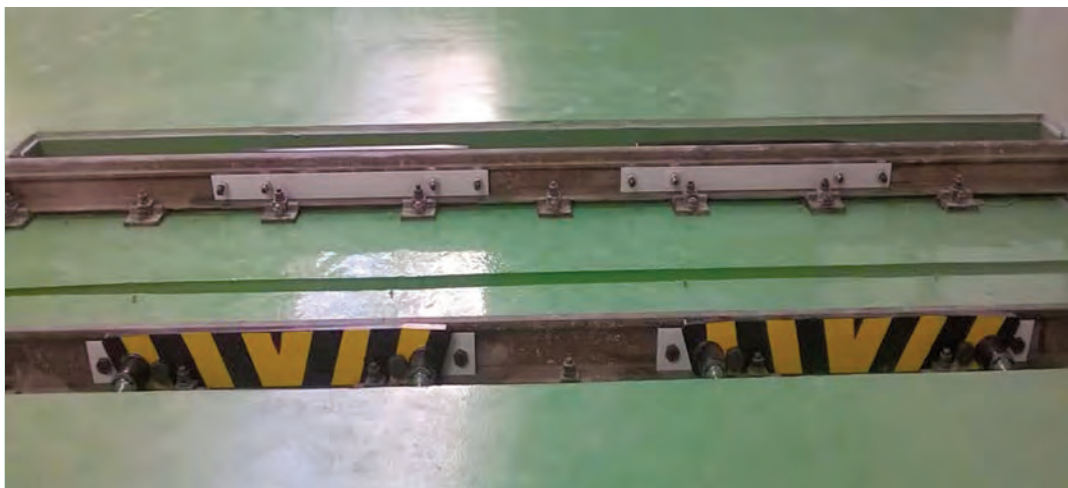
5. ábra. A mérőberendezés beépítés közben
