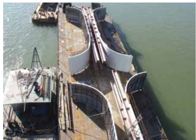
30. ábra. Az uszályokon összeszerelt fél acélzsaluzatok
