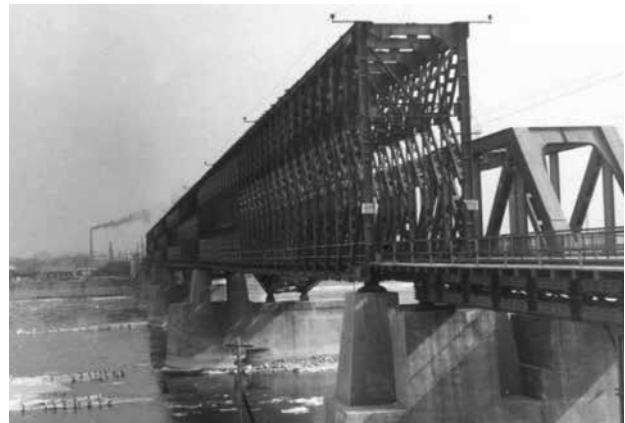
13. ábra. Az ideiglenes K szerkezet és a jobb vágány elkészült végleges szerkezete
