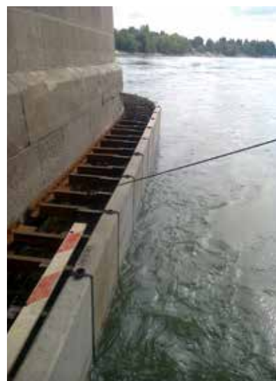
22. ábra. A beemelt és rögzített előregyártott vasbeton táblák
