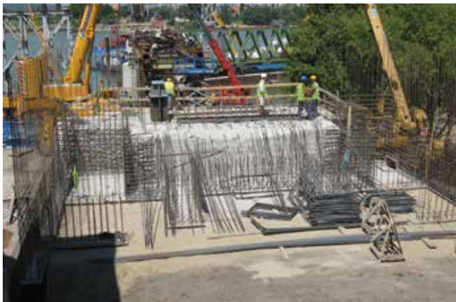
7. ábra. A kezdőpont felőli hídfő átalakítása
