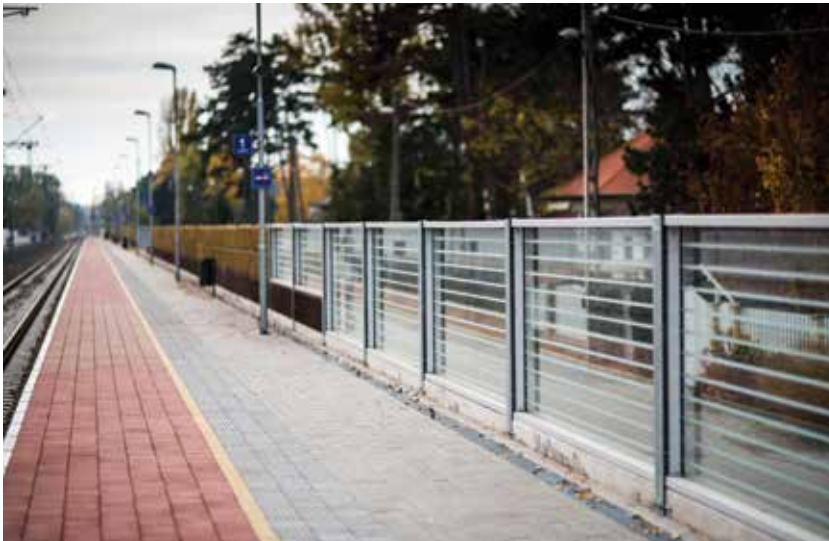
4. ábra. Peronokon alkalmazott taktilis jelek és kontrasztok: a szolgáltatási lánc a jármű eléréséig értelmezendő (Fotó: NIF Zrt.)
