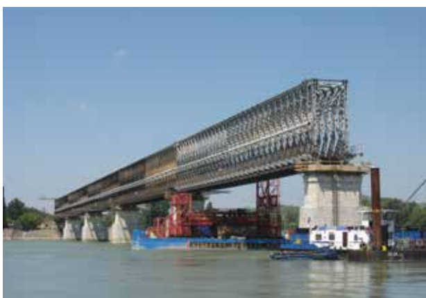
1. ábra. A budapesti Északi Duna-híd K szerkezetének bontása Pest felől nézve
