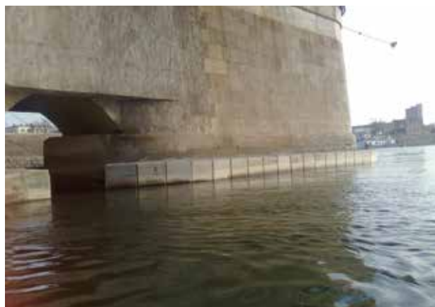
24. ábra. A pillértalp elkészült vasbeton köpenyezése
