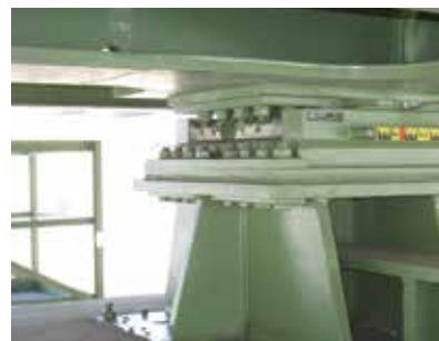
6. ábra. Gömbsüveg csúszófelületű, egy irányba mozgó ingasarú
