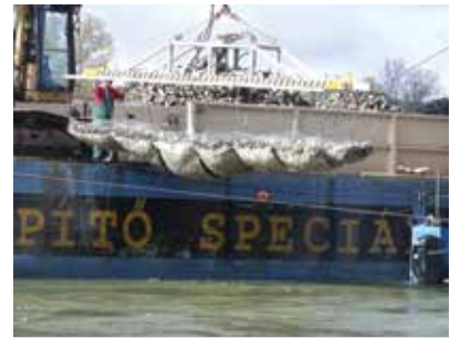
35. ábra. A RENO-matrac terítése a pillér körül
