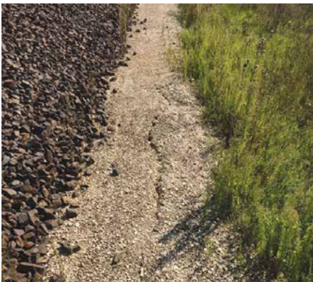
4. ábra. Jellemző repedésalak a padka felületén
