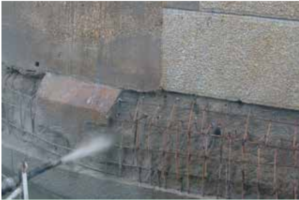
17. ábra. A hiányzó köburkolat pótlása löttbetonnal
