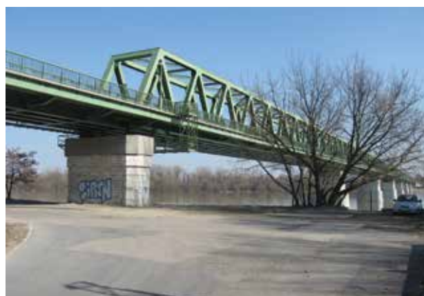
2. ábra. A budapesti Északi Duna-híd jelenlegi szerkezete Buda felől
