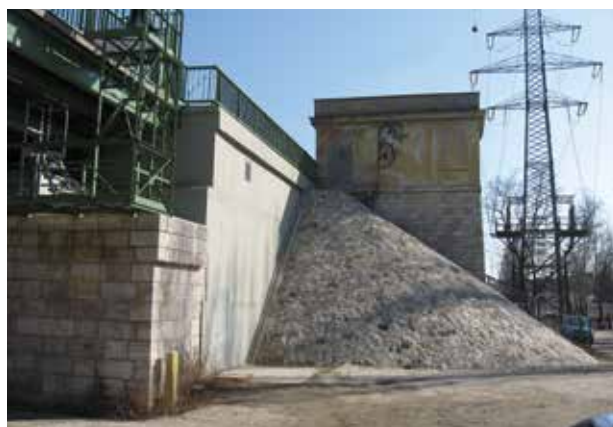
9. ábra. Az átalakított pesti hídfő az új szárnyfallal és kőkúppal
