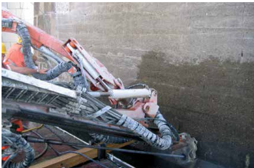
15. ábra. A mederpillérek injektálása
