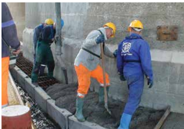
23. ábra. A vasbeton táblák mögötti hátúr kibetonozása
