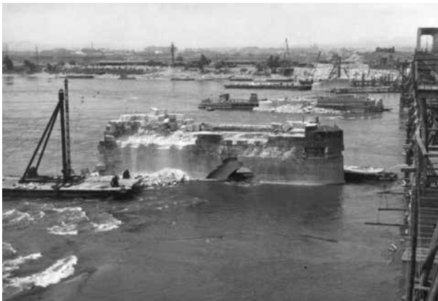
12. ábra. A híd alépitményei a háború utáni szükséghíddal, Pest felől nézve
