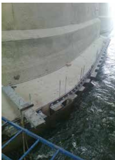
21. ábra. A betontáblákat fogadó acél tartószerkezetek
