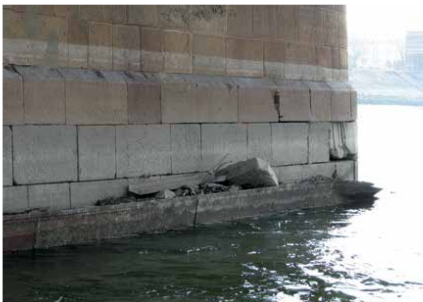
20. ábra. A pilléralapok korrodált, rongálódott acélkeszonzjai
