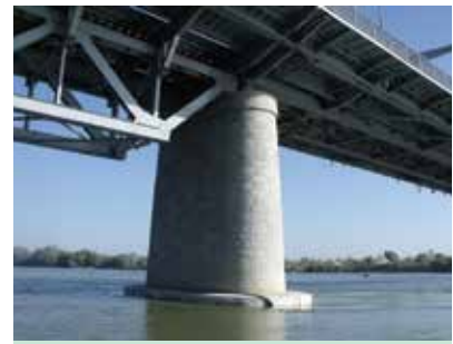
34. ábra. Az elkészült pillérköpenyezés
