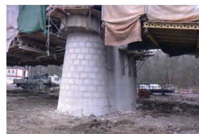
25. ábra. Az ártéri pillérek elkészült megerősítése, burkolása
