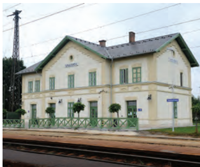
7. ábra. Tápiógyörgye vasútállomás, felvételi épület
