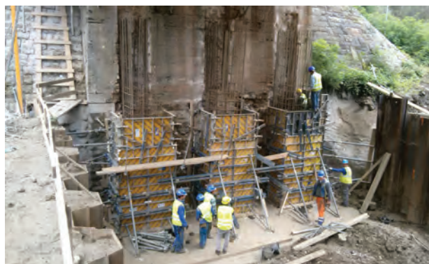
18. ábra. A bal parti hídfő erősítőkordáinak beépítése
