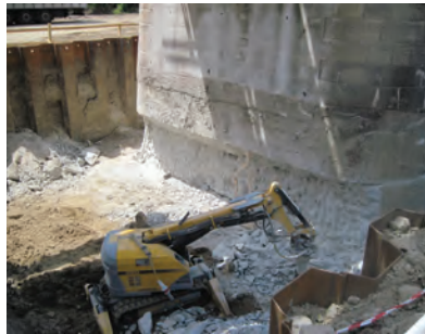
21. ábra. Az ártéri pillérek bontása a megerősítéshez
