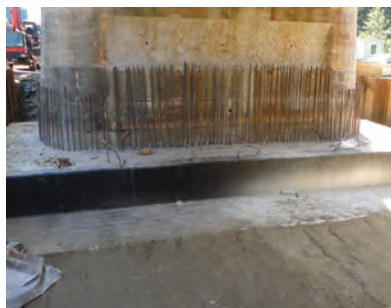
23. ábra. Az ártéri pillérek megerősítő vasbeton gallérja
