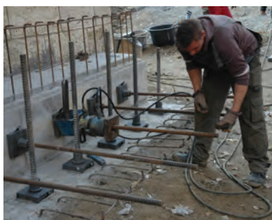
8. ábra. A keresztirányú Dywidag-rodok feszítése
