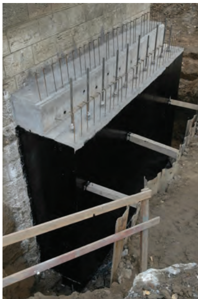
7. ábra. A kent szigeteléssel ellátott, együttdolgoztató vasbeton gerenda
