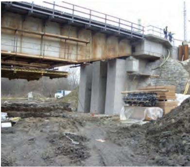
19. ábra. A bal parti hídfő elkészült megerősítése, burkolása
