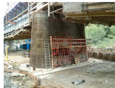
24. ábra. Az ártéri pillérek köpenyezése
