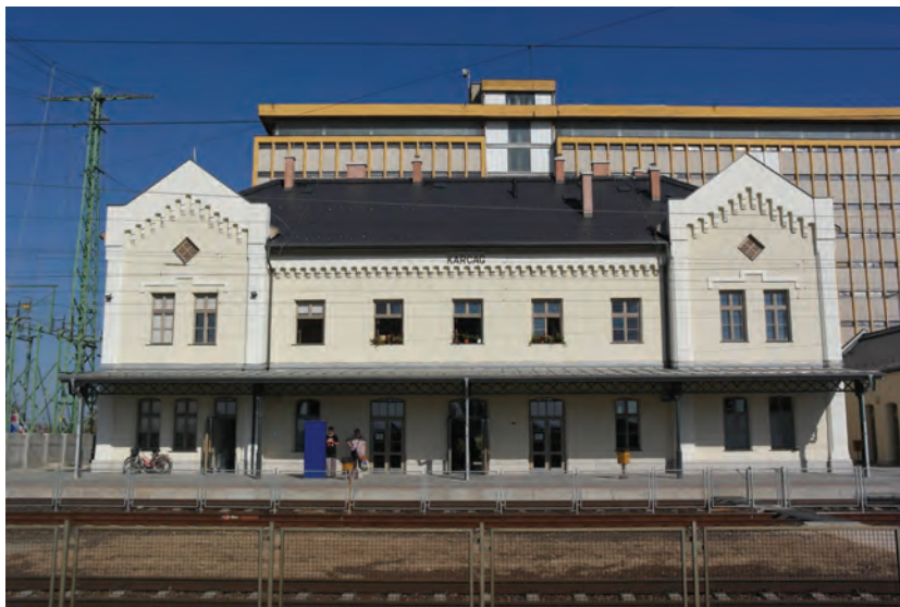
2. ábra. A Tiszavidéki Vaspálya Társaság által épített, idén felújított karcagi felvételi épület (Fotó: dr. Kovács Róbert)
