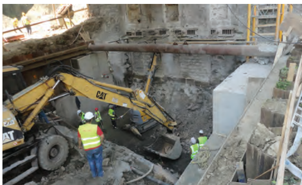
17. ábra. A bal parti hídfő megbontása a megerősítéshez
