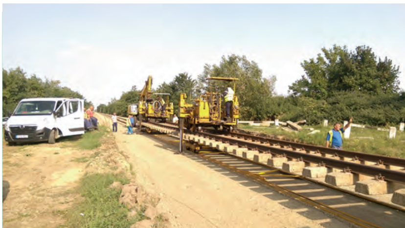
12. ábra. Vágányépítés a Mezőpeterd–Biharkeresztes szakaszon
