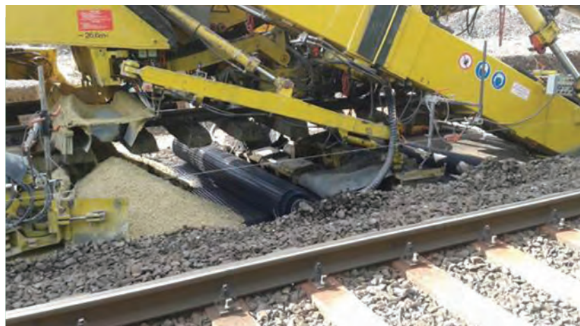
11. ábra. Alépítmény-javító géplánc munka közben
