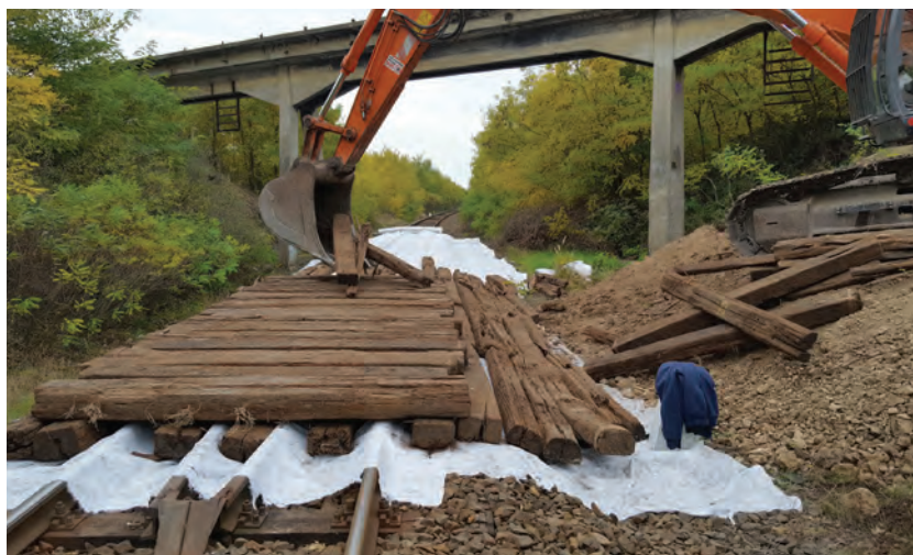
6. ábra. A nagyvasúti pálya letakarása a híd bontásához
