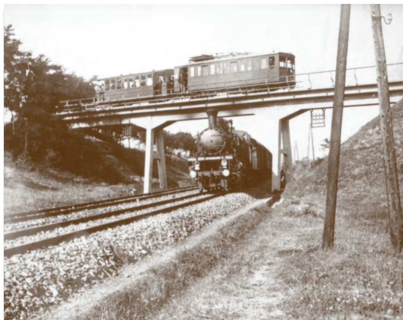
4. ábra. A még üzemelő híd oldalnézete
