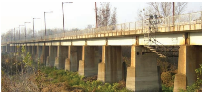
9. ábra. A kiskörei közös közúti-vasúti Tisza-híd öszvér ártéri szerkezetei
