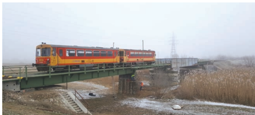
7. ábra. Az átépített szeghalmi Berettyó-híd, a provizóriumok felhasználásával kialakított ártéri szerkezetekkel
