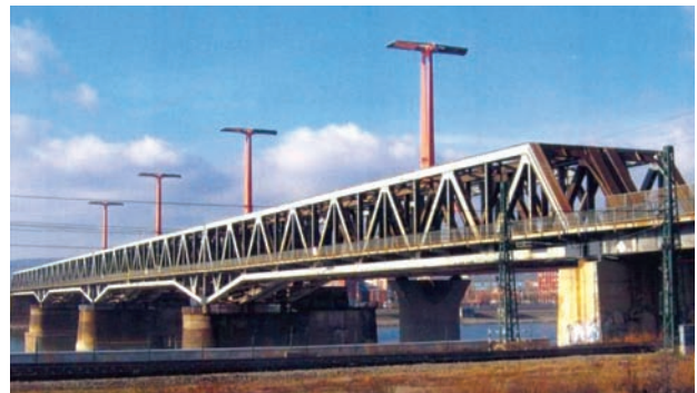
16. ábra. A budapesti Déli összekötő Duna-híd jelenlegi két rácsos felszerkezete
