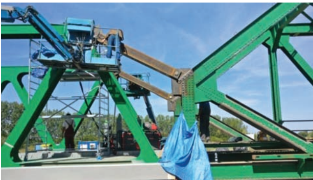
15. ábra. A Sárvíz-Nádor-csatorna híd betolása a régi szerkezethez kapcsolva
