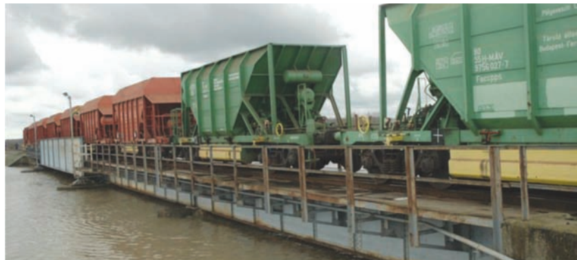
6. ábra. A szeghalmi Berettyó-híd átépítés előtt, árvíz idején, régi ártéri szerkezetekkel
