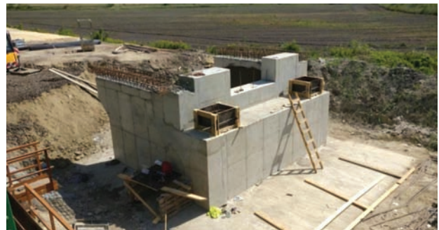
14. ábra. A Sárvíz-Nádor-csatorna híd alépítményének átépítése Rétszilasnál
