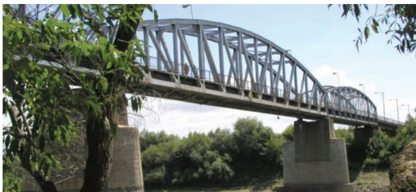
8. ábra. A kiskörei közös közúti-vasúti Tisza-híd rácsos mederszerkezetei
