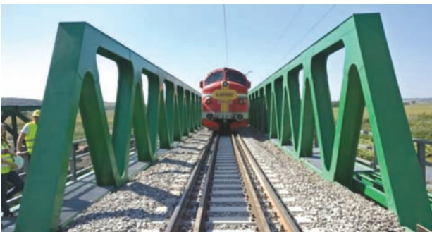
13. ábra. A 40. sz. vasútvonalon a Kapos-híd új felszerkezete Pinchehelynél
