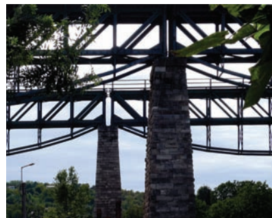
5. kép. Hatvani Ágnes „Biatorbágyi vasúti völgyhíd1”
