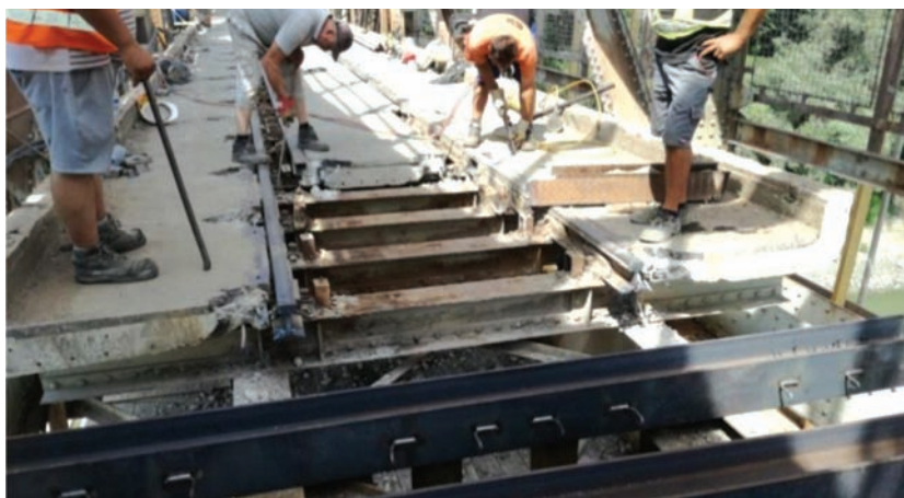
10. ábra. A kiskörei közös közúti-vasúti Tisza-híd mederszerkezetain elbontandó pályaszerkezet és a beépítendő másodlagos keresztartók
