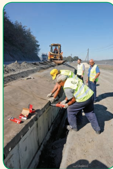
12. kép. Helyszíni bemutató a betonpaplan-fektetésről
