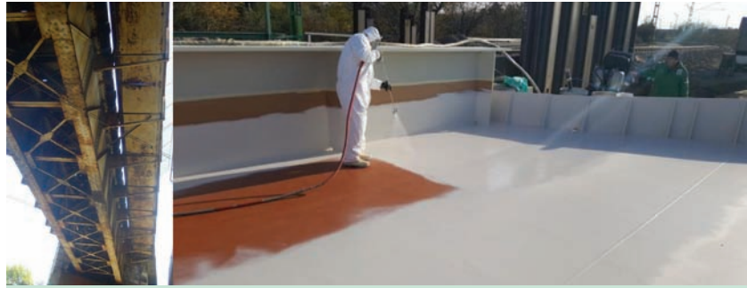
4. ábra. Az érdi keresztvezési műtárgy jobb vágányos régi és új felszerkezete, munkaközi állapot
