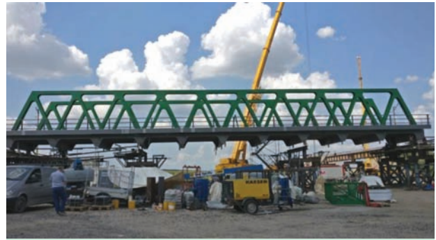
12. ábra. A Kapos folyó hídjának új felszerkezete Tolnanémedinél
