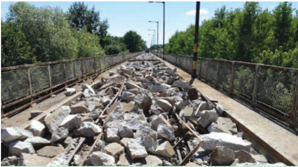
11. ábra. A kiskörei közös közúti-vasúti Tisza-híd ártéri szerkezeteinek feltört pályatáblái
