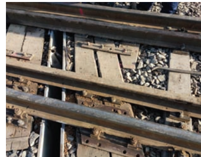
5. ábra. Az érdi keresztvezési műtárgyra ideiglenes megoldásként beépített ferde alátétlemezek
