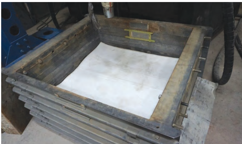
2. ábra. A 20 cm XPS réteg elhelyezése
