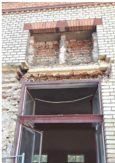
6. kép. Egy feltárt homlokzati nyílászáró (Forrás: MÁV Zrt. MTF)
