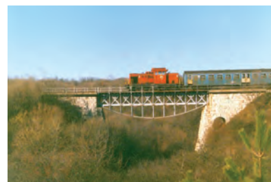
7. ábra. Répás-völgyi viadukt (Fotó: Molnár István)
