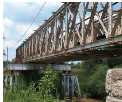
2. ábra. A szanyi Rába-híd provizórium egy szakasza (Fotó: Pulisch József)
