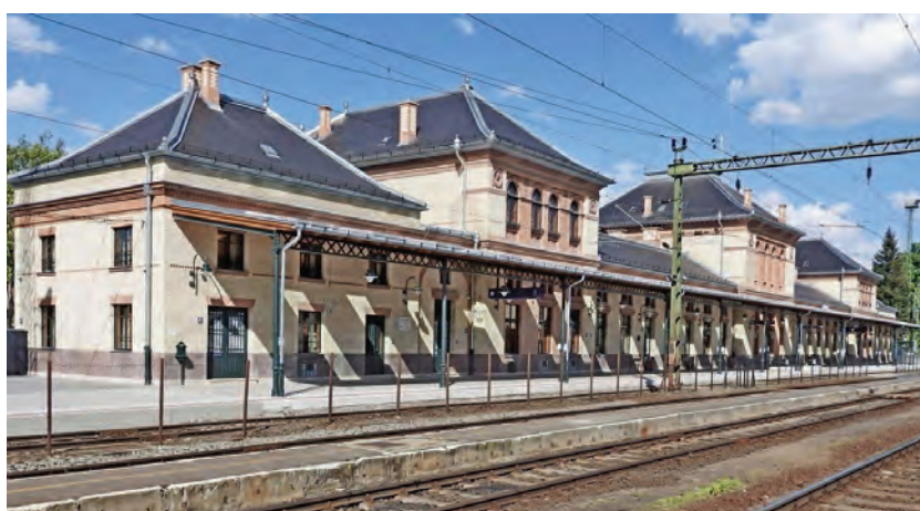
15. kép. Megvalósult állapot – peron felőli nézet (Forrás: MÁV Zrt. MTF)
