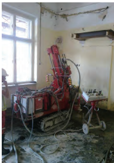
8. kép. Talajszilárdítási munkák (jet-grouting) (Forrás: MÁV Zrt. MTF)
