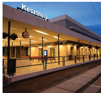
15. kép. A nyári váró kivilágítása
