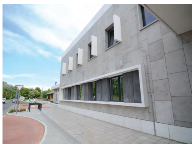
6. kép. Fehér dekorbeton ablakkeretezés a földszinten
