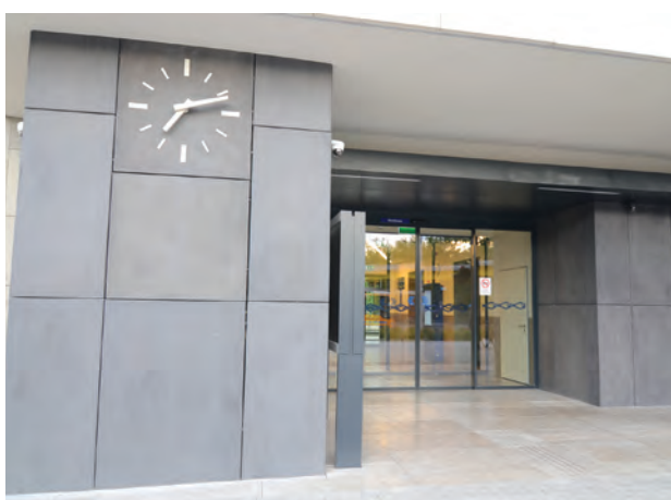
5. kép. Burkolatra épített kültéri óra esti LED háttérvilágítással
