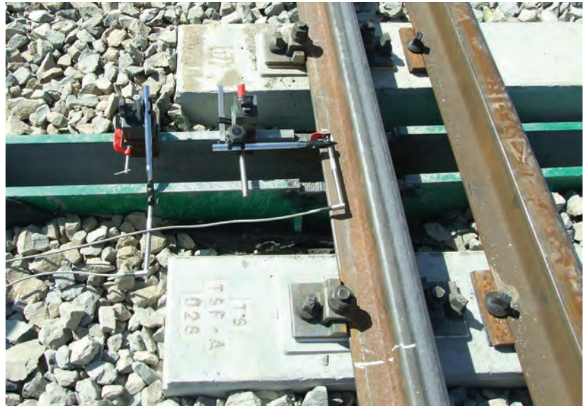
5. ábra. Műszerek elhelyezése a pincehelyi híd mozgó saru felőli végénél
