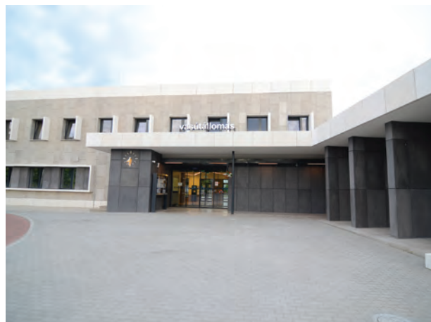
4. kép. Szürke texturált dekorbeton nagyelemes burkolat a bejáratnál
