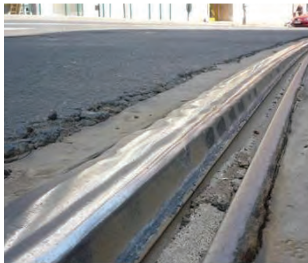
3. ábra. Vegyes típusú sínkopások 63 m sugarú ívben
