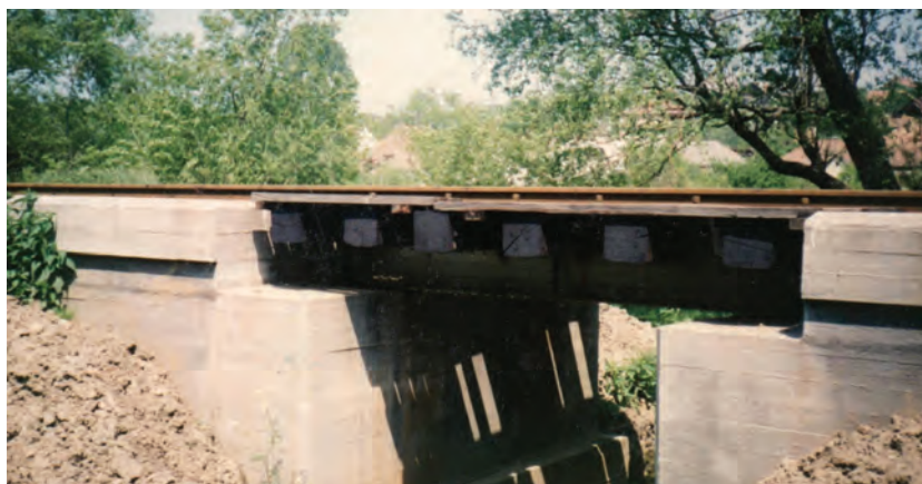
3. ábra. Vasbeton köpennyel erősített falazat, Vác–Drégelypalánk vasútvonal 215+74 hm-szelvény (Fotó: Legeza István)
