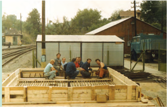
7. ábra. Vasbeton lemez vaszerelése készül, háttérben az építésvezetőség épülete (Fotó: Legeza István)
