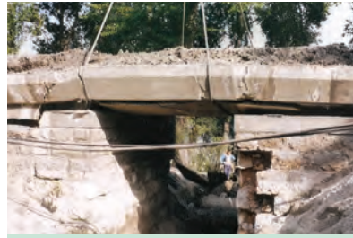
10. ábra. Teknőhíd bontása a Vác–Drégelypalánk vasútvonalon (Fotó: Gutai Imre)
