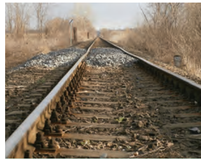
9. kép. Üregbeszakadás okozta süppedések a vasúti pályában (PFT Székesfehérvár)
