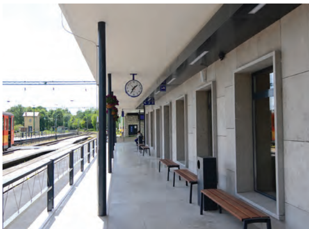
3. kép. Átszellőztetett csiszolt JURA mészkőburkolat kókerezett nyílásokkal
