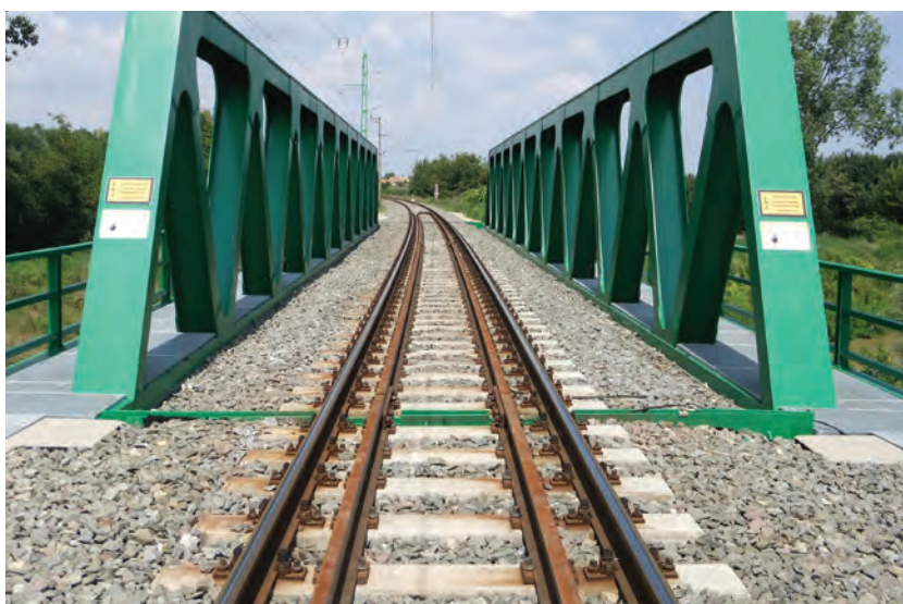
3. ábra. A pincehelyi híd és a vasúti felépítmény (a végpont felől)
