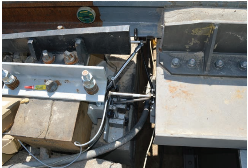
3. ábra. Útadók elhelyezése a végpont felőli hídvégénél
