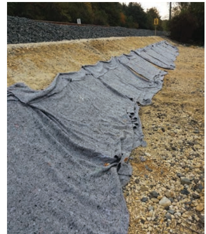
17. ábra. Rézsűvédelem kialakítása fűszövettel (Fotó: Radvánszky Réka)
