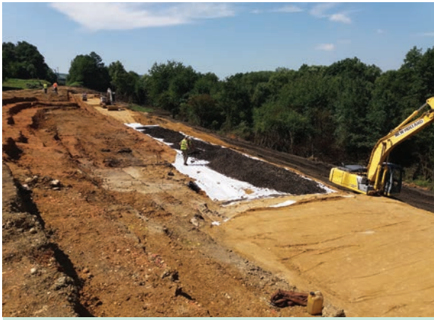
25. ábra. Drénező rétegek beépítése (Fotó: Radvánszky Réka)
