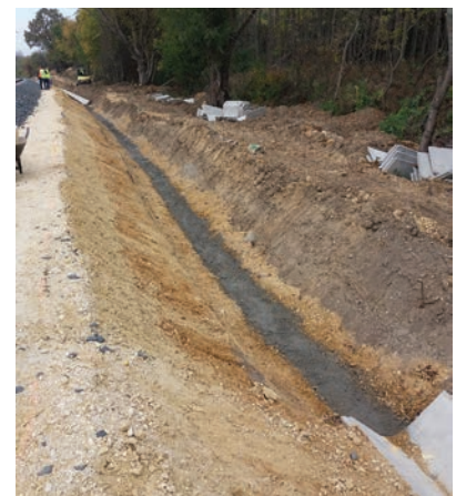
18. ábra. Burkolt árok építése (Tervdokumentáció)
