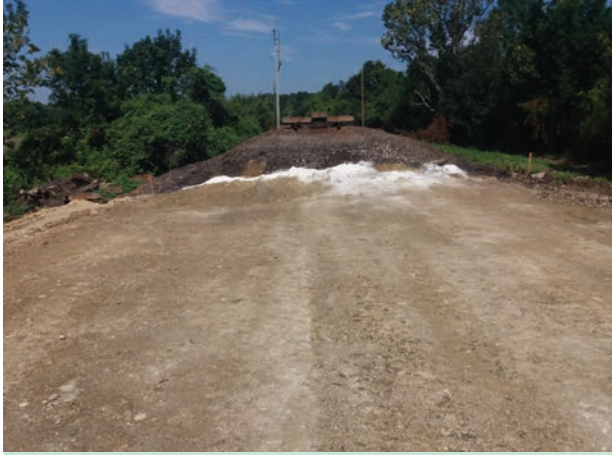
13. ábra. Elkészült meszes stabilizáció (Fotó: Radvánszky Réka)
