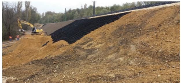
28. ábra. Geocellás rézsűvédelem (Fotó: Radvánszky Réka)
