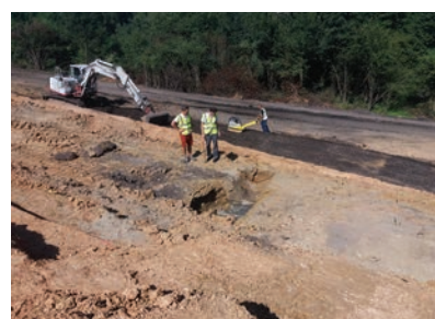
24. ábra. Vízkilépés a töltés bal oldalán (Fotó: Radvánszky Réka)
