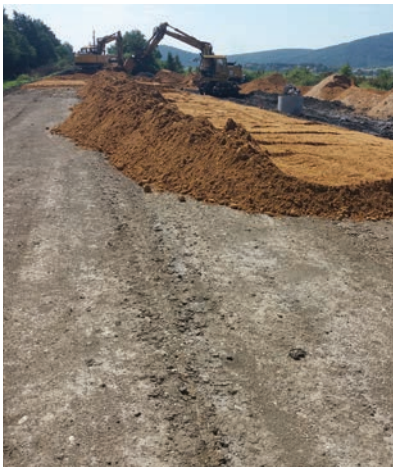
15. ábra. Töltésképző anyag beépítése (Fotó: Radvánszky Réka)
