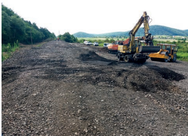
9. ábra. Zúzottkővel keveredett salakréteg letermelése (Fotó: Radvánszky Réka)
