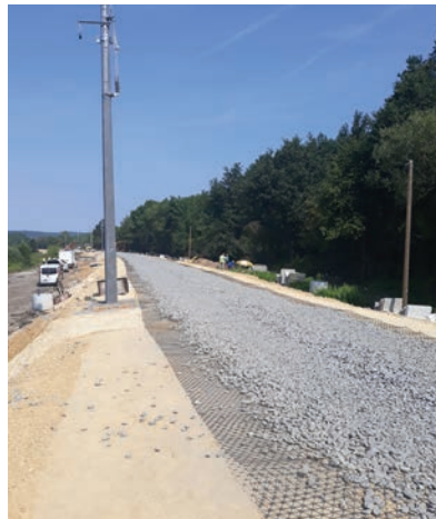
16. ábra. Ágyazaterősítő triaxiális georács beépítése (Fotó: Egyházi Dániel)
