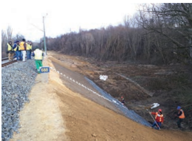
29. ábra. Műtárgy feletti Reno matricos rézsűvédelem (Fotó: Balics Gergely)
