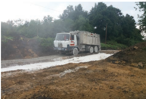
5. ábra. Kötőanyag terítése szórógéppel (Fotó: Radvánszky Réka)
