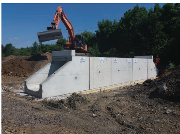
11. ábra. Kerethíd építése (Fotó: Radvánszky Réka)
