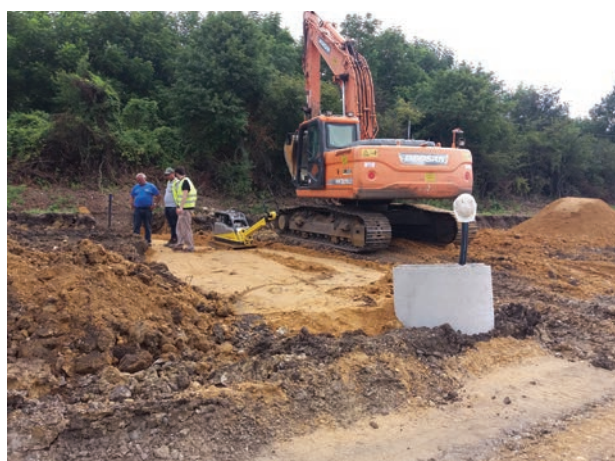
12. ábra. Süllyedésmérő cső beépítése (Fotó: Radvánszky Réka)
