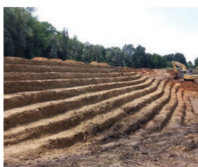
22. ábra. Bal oldali töltésrészi lépcsőzése (Fotó: Radvánszky Réka)
