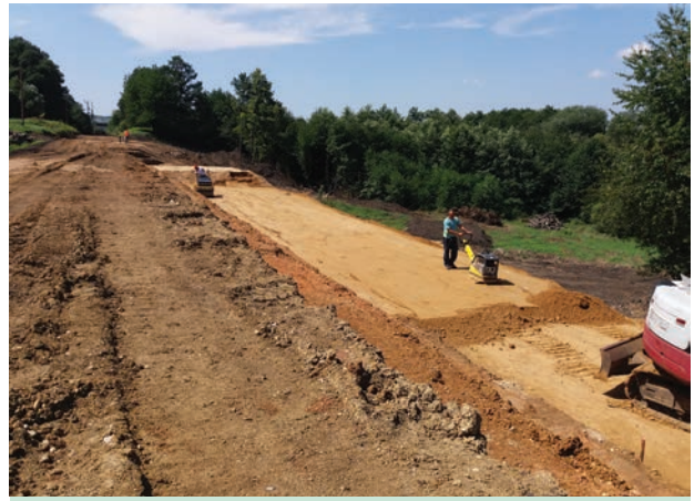
26. ábra. Töltésszelésítés építése (Fotó: Radvánszky Réka)
