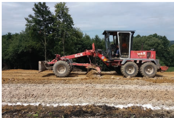
8. ábra. Stabilizált felület profilozása gréderrel (Fotó: Radvánszky Réka)
