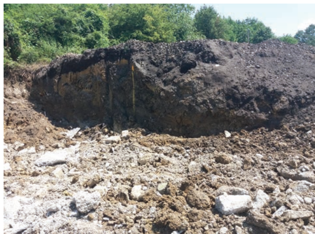
10. ábra. Elbontott kerethídhöz csatlakozó földmű (Fotó: Radvánszky Réka)
