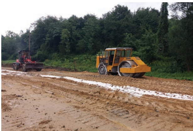
7. ábra. Tömörítés acélpalástos földmunkahengerrel (Fotó: Radvánszky Réka)
