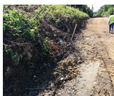
23. ábra. Vízzívargás a bevágásban (Fotó: Radvánszky Réka)
