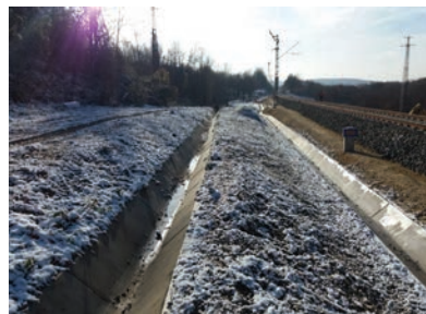
30. ábra. Felújított pályaszakaszcso lejtő felőli vízelvezető rendszere (Fotó: Radvánszky Réka)
