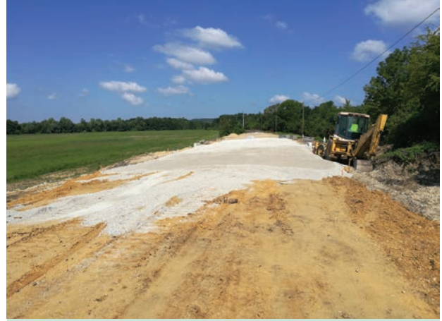
14. ábra. CKT-réteg beépítése a híd-földmű átmeneti szakaszán (Fotó: Balics Gergely)
