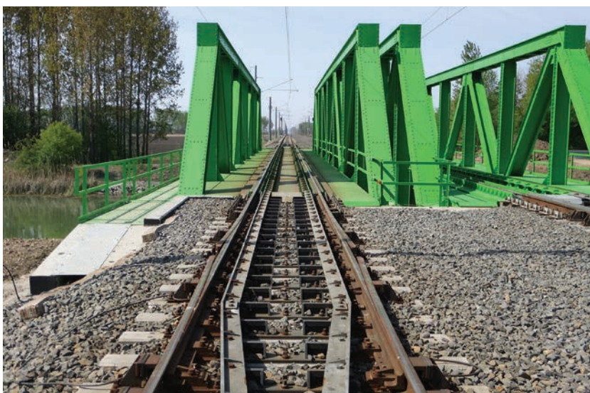
1. ábra. A híd képe
