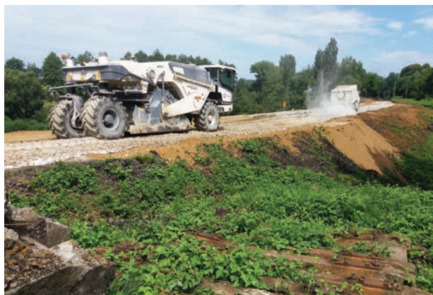
6. ábra. Homogenizálás talajmaró géppel (Fotó: Radvánszky Réka)
