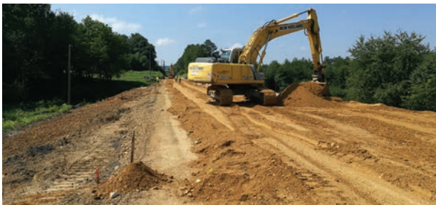
27. ábra. Zárórteg beépítése (Fotó: Balics Gergely)
