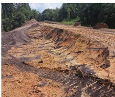
21. ábra. Salak kifejtése a töltés szakaszon (Fotó: Radvánszky Réka)
