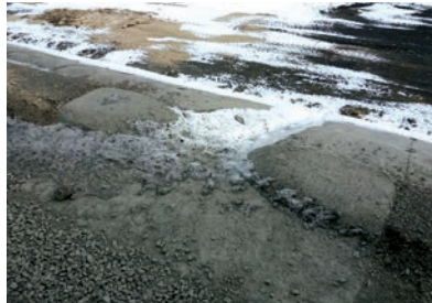
15. ábra. A surrantó környezetének kialakítása monolit betonnal (Fotó: Radvánszky Réka)
