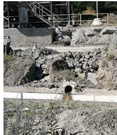
5. ábra. Nagymértékben erodált részű (Fotó: Balics Gergely)
