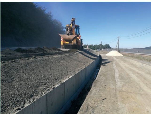
8. ábra. Leterhelő árok készítése (Fotó: Balics Gergely)
