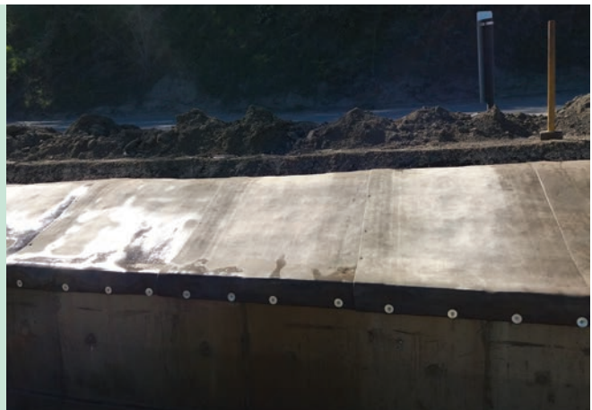
10. ábra. Betonpaplan rögzítése az árokelemekhez (Fotó: Radvánszky Réka)
