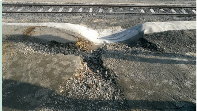
14. ábra. A kivitelezés közbeni kimosódás a surrantó kör- nyezetében (Fotó: Balics Gergely)
