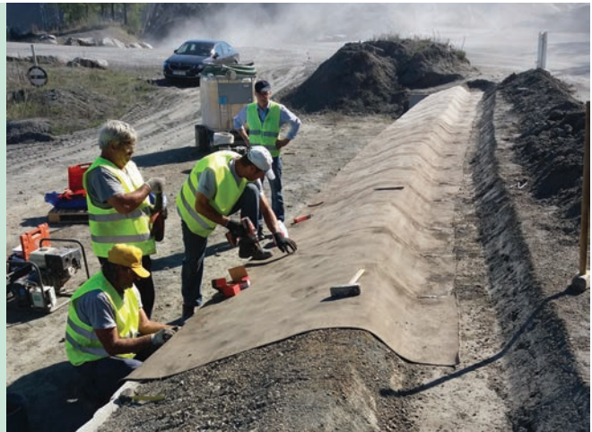
9. ábra. Betonpaplan terítése és rögzítése (Fotó: Radvánszky Réka)
