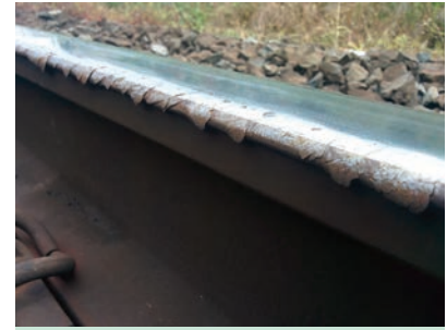
14. ábra. Nyelvszegélyképződés R260 anyagminőségű sínen 35 millió eleytonna áthaladása után, R = 302 m sugarú ívben
