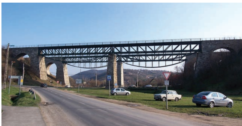
7. kép. A viadukt napjainkban
