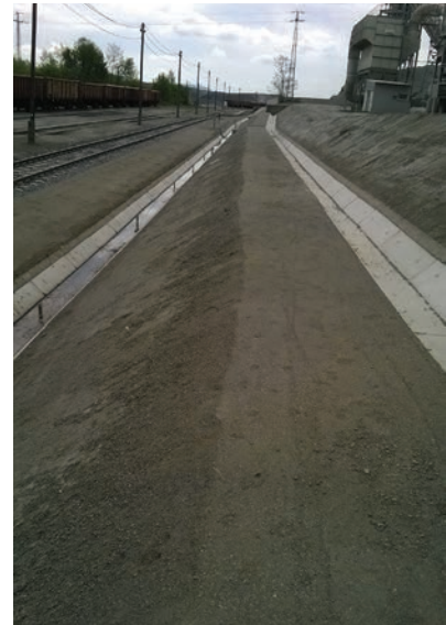
4. ábra. Osztópadkás kialakítás (Fotó: Balics Gergely)
