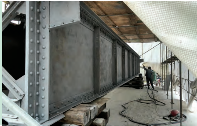
10. ábra. A Tolcsva-híd korrózióvédelmi munkái (Fotó: Balogh Péter)
