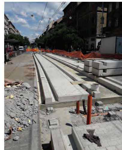
17. ábra. Épülő Sika SBST 35 felépítmény a Nagykörúton, 2019
