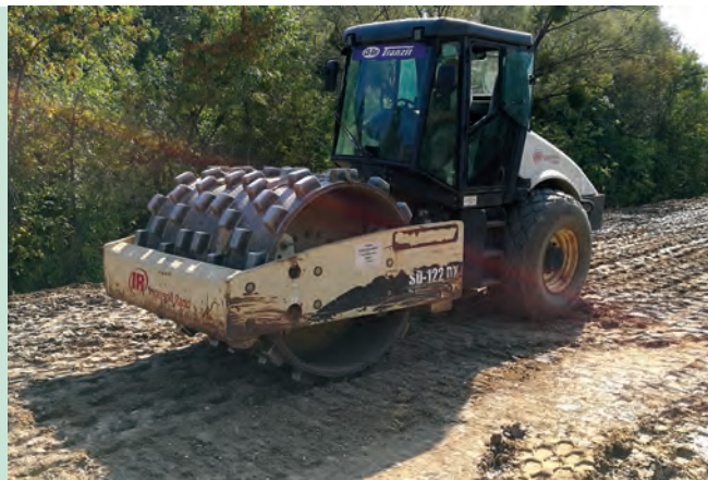
11. ábra. A sovány agyagból épülő töltésmagasítás tömörítése juhlábhengerrel (Fotó: Balogh Péter)
