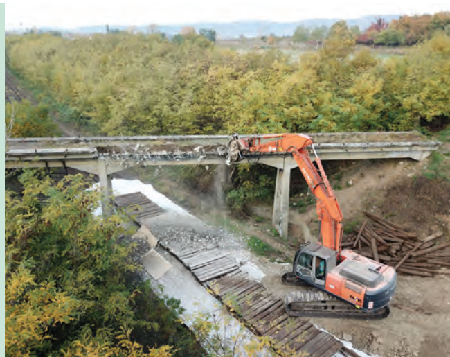
14. ábra. Kisvasúti felüljáró bontása a 374+65 szelvényben [8] (Fotó: Szűcs József)
