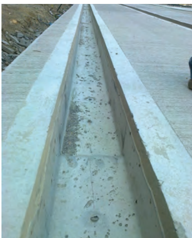
7. ábra. A budai fonódó projekt sínkörülöntéses felépítményének beton sínvályúja, Frangepán utca
