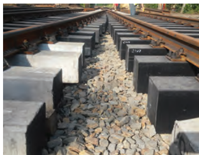
6. kép. STRAILway műanyag alj Hódmezővásárhelyen
