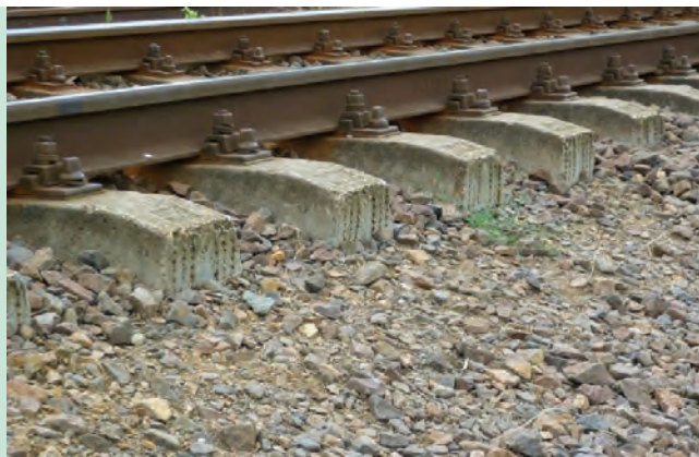
5. ábra. Jelentős ágyazathiány a Sárospatak–Sátoraljaújhely állomásközben (Fotó: Balogh Péter)
