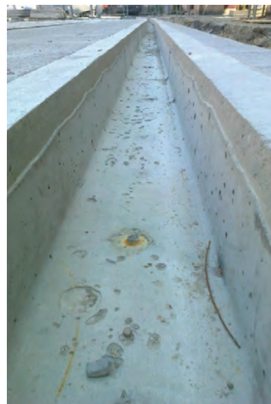
14. ábra. Acélzsaluzattal készült sín-csatornában maradt csavar
