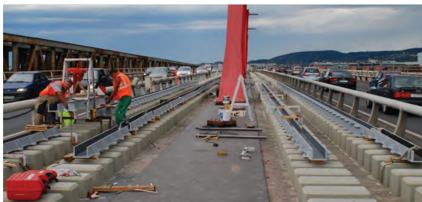
9. ábra. Acél sínvályú építése a Rákóczi hídon (Forrás: www.innorail.hu)
