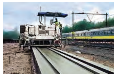
11. ábra. Vasúti pályalemez betonfiniseres kialakítása egy külföldi példán
