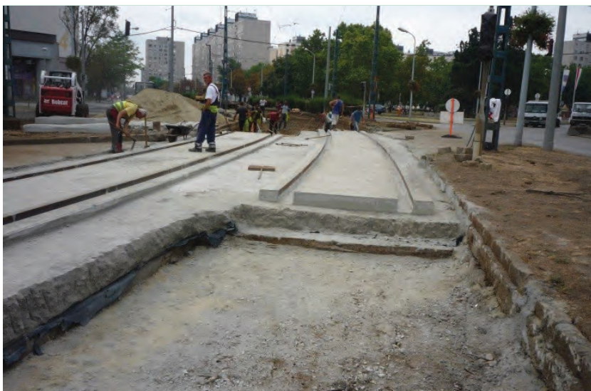
4. ábra. Épülő sínkörülöntéses útátjáró a Nyírpalota úton
