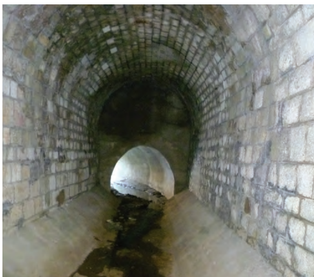
2. ábra. Eltérő nyílású, folytatólagos műtárgyak a külön ütem- ben épült vágányok alatt (Fotó: Balogh Péter)
