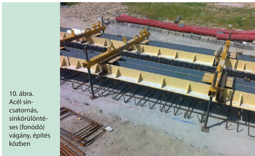
9. ábra. Acél sínvályú építése a Rákóczi hídon (Forrás: www.innorail.hu)
