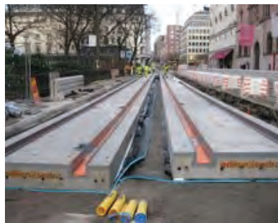
16. ábra. Rotterdam, úsztatott Edilon pályalemez
