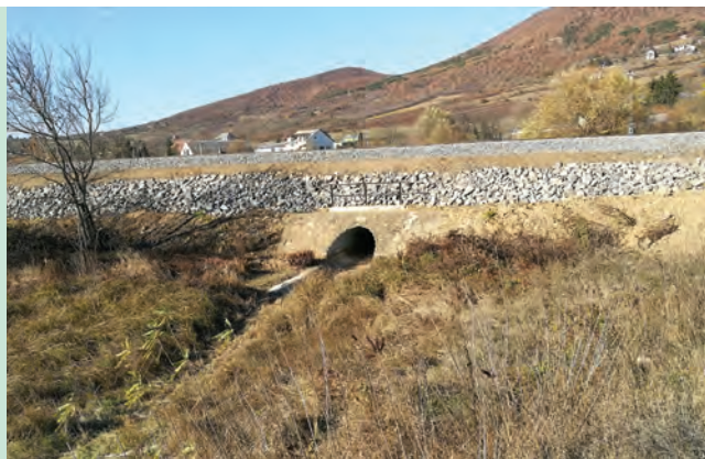
12. ábra. Kimosás elleni kőszórás az árvízveszélyes vonalszakaszon (Fotó: Balogh Péter)
