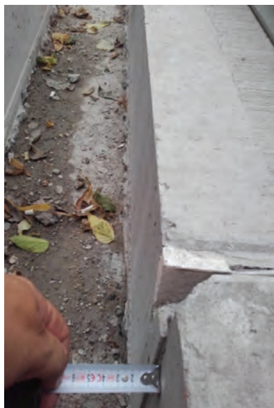
13. ábra. Irányhiba a monolit sín-csatornában – Nagykörút, 2018
