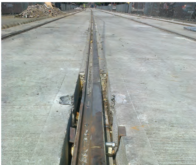
6. ábra. Az első nagykörüti sínkörülöntéses szakasz építés közben
