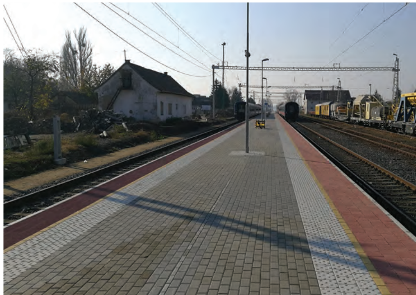
17. ábra. Új, sk +55 cm magasságú szélesperon Sáropatak állomáson (Fotó: Balogh Péter)
