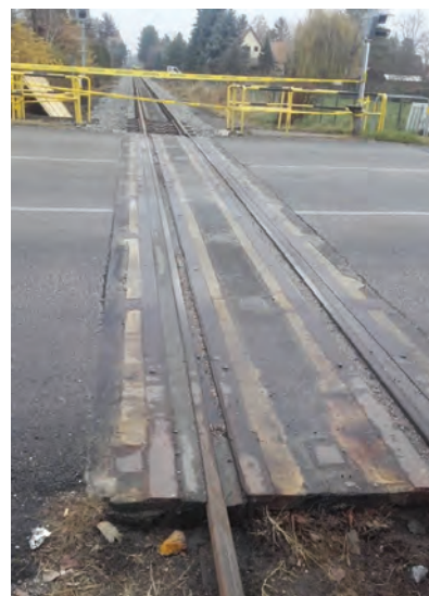
5. ábra. Újraragasztott acél élvédő elem Balatonfenyvesen, a 7-es főút és a Balatonfenyvesi GV útátjárójában
