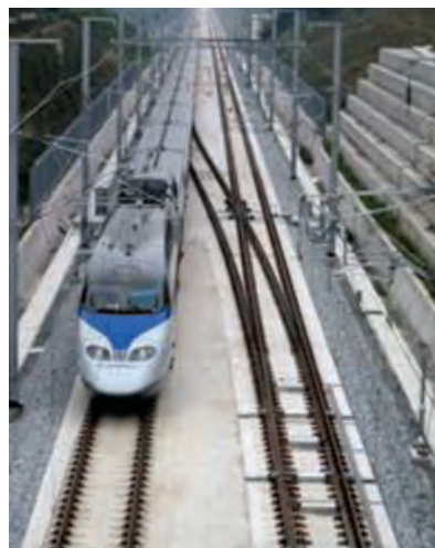
6. ábra. Klotoid átmeneti íves nagy sebességű kitérő KGO-kialakítással vasbeton lemezen, Dél-Koreában [2]
