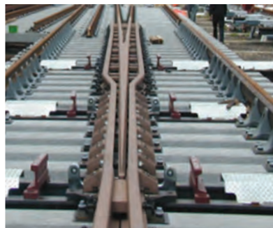
11. ábra. Mozgatható kovácsolt keresztelési csúcs hosszú könyöksínekkel [2]
