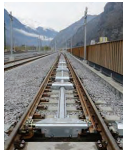
7. ábra. Klotoid átmeneti íves nagy sebességű kitérő KGO-kialakítással zúzottkő ágyazatban, Ausztriában [2]
