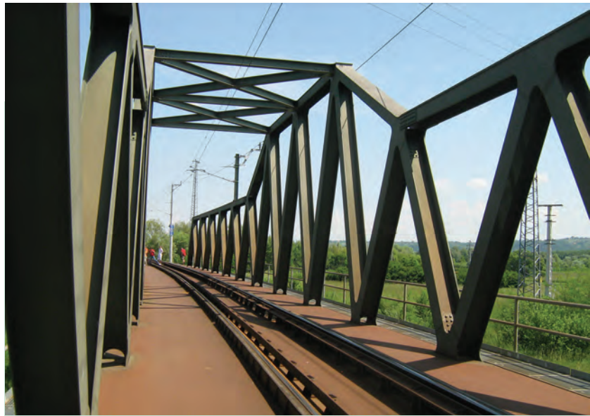
2. ábra. A Zala-híd edilonos sínleerősítéssel (Fotó: Szőke Ferenc)
