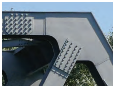
5. ábra. Drónfelvétel a végkereszt-tartó-bekötésről (Fotó: Hajnal Máté)
