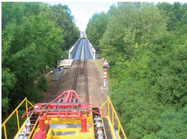
2. ábra. A hagyományos hídvizsgálat velejárója a vágányzár és a költséges felsővezeték-szerelő vasúti jármű. (Fotó: Jarabek Jenő)
