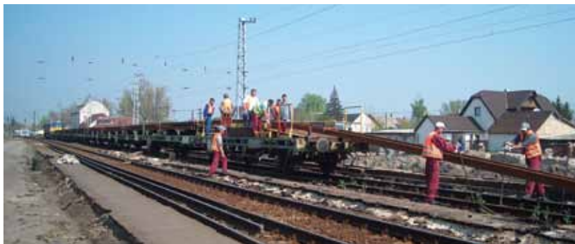
8. ábra. Hosszúsínlehúzás a szállítókocsról
