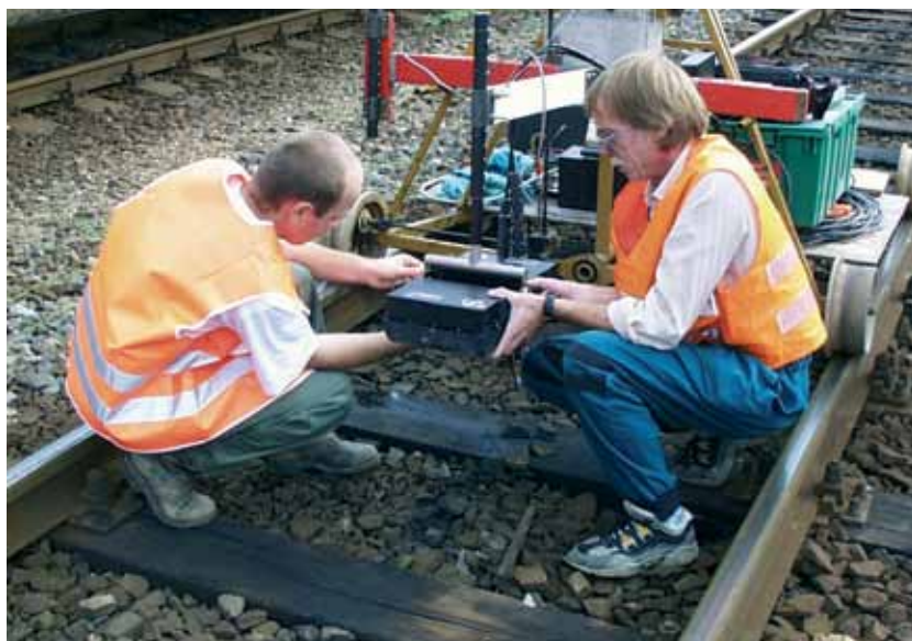
4. ábra. A radar felszerelése a pillekocsra
