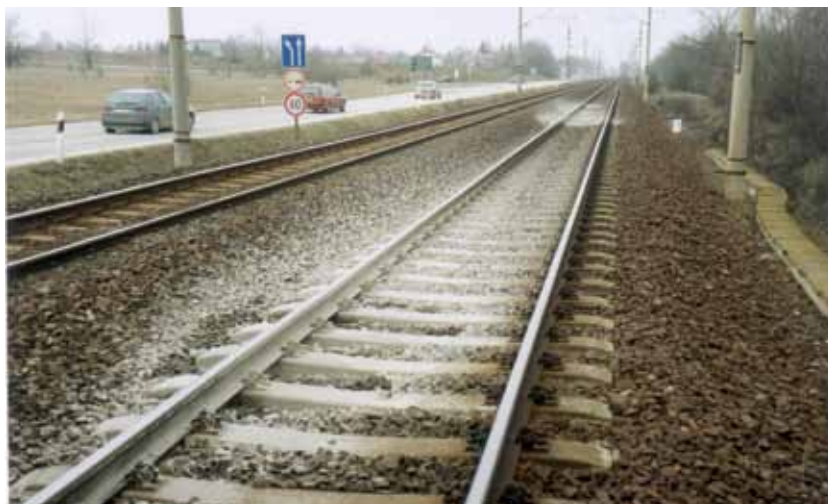
6. ábra. Felszínről is látható ágyazathiba
