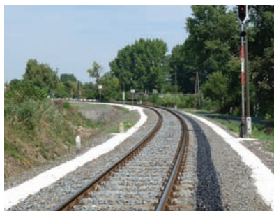
9. ábra. A tapolcai vasbeton aljas, külső oldalon ragasztott, kis sugarú hézag nélküli vágányszakas
