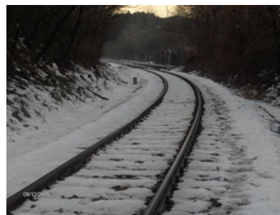
10. ábra. A piliscsabai, mindkét oldalon ragasztott vágányszakas téli állapota
