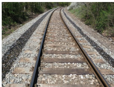
8. ábra. A piliscsabai faaljas, mindkét oldalon ragasztott vágányszakas
