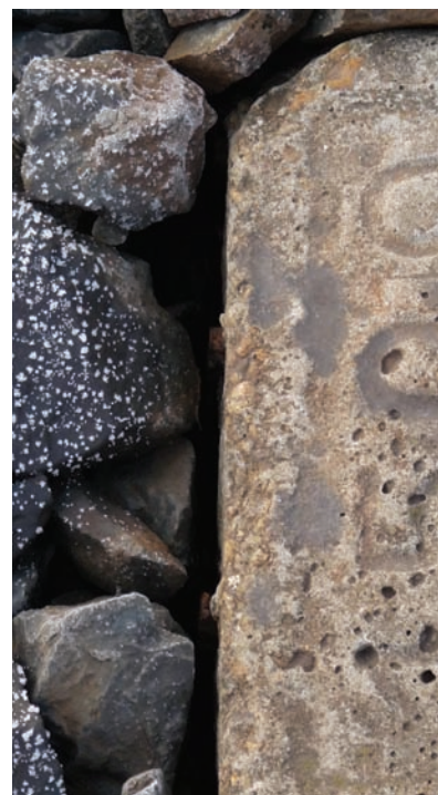
12. ábra. Vasbeton alj keresztirányú elmozdulása a belső oldali ragasztás hiányában
