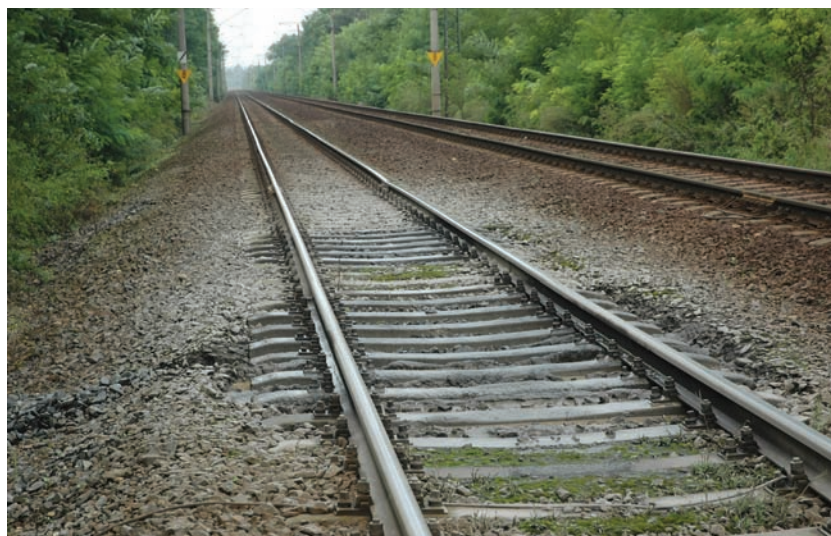
1. kép. Sáros ágyazatot, sebességkorlátozás a 304+95 szelvényben (Fotó: Balogi András)
