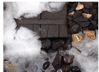
11. ábra. Belső oldali ragasztás eredménye: az alj nem mozdult el az ív középpontja felé
