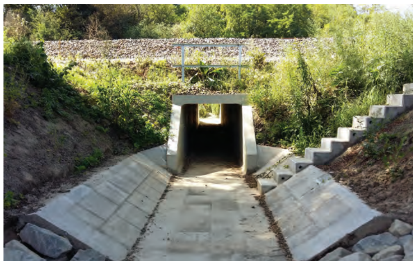
4. kép. Új építésű 1,50/1,50 m nyílású keret (232/3 szelvény)
