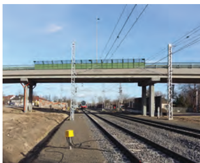
21. kép. Budapest, Cinkotai úti közúti felüljáró
