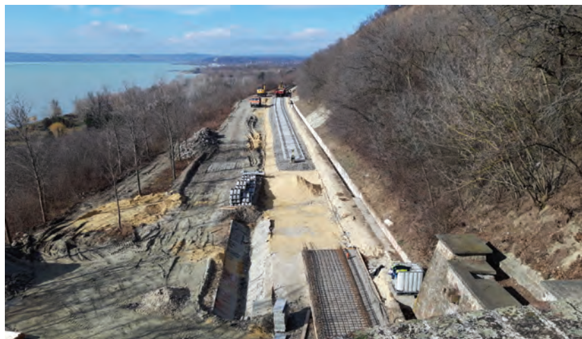
12. ábra. Csatlakozóvágány építése az alagút végénél (Fotó: Fonyó Sándor)
