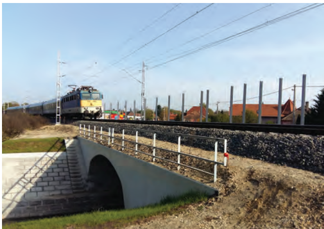
13. kép. Elkészült ConSpan híd (277/8 szelvény)
