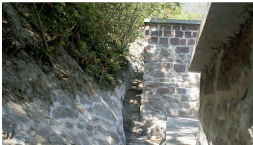
17. ábra. Kapuzat mögötti részüburkolat felújítása (Fotó: Ács-Lengyel Réka)
