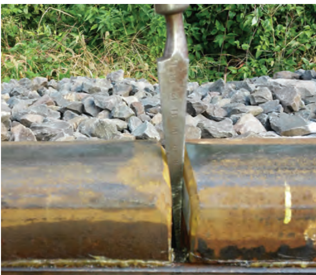
6. ábra. Fektetési hézag az 50-es vasútvonal 493+00 hm szelvényében
