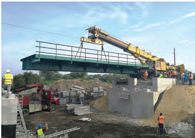
14. kép. Új felszerkezet beemelése, Galga-patak- híd
