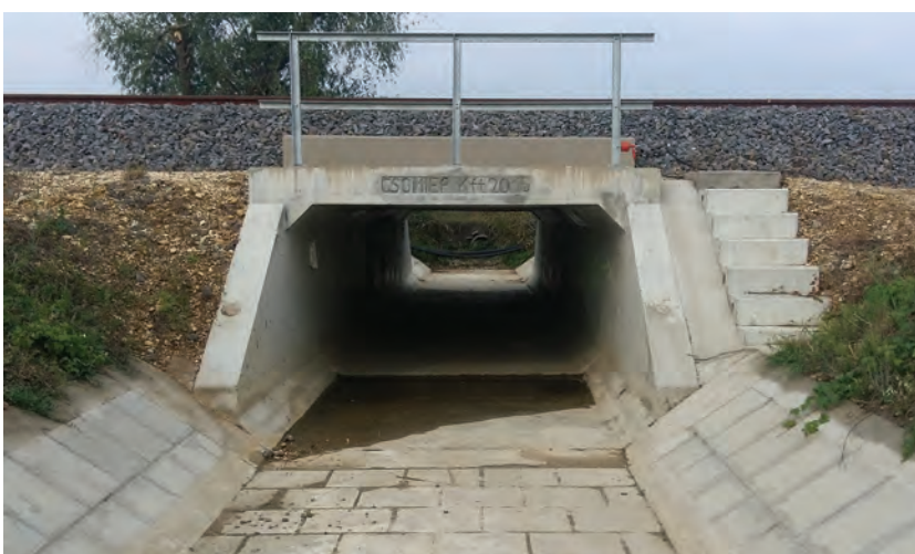
8. kép. Hídnílásba beépített 2,50/1,50 kerethíd
