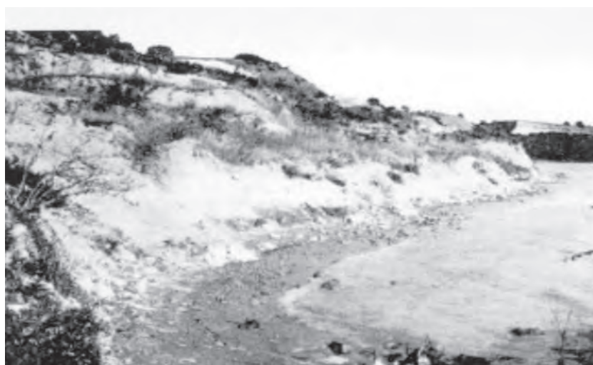
7. ábra. Suvadások Akarattya alatt. A lesuvadt pannóniai rétegeket a tó hullámai ismét megtámadják (Cholnoky Jenő felvétele, 1934)
