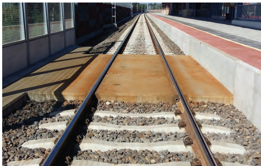
9. kép. 4,0 m nyílású híd új vasbeton pályalemez, Máriabesnyő
