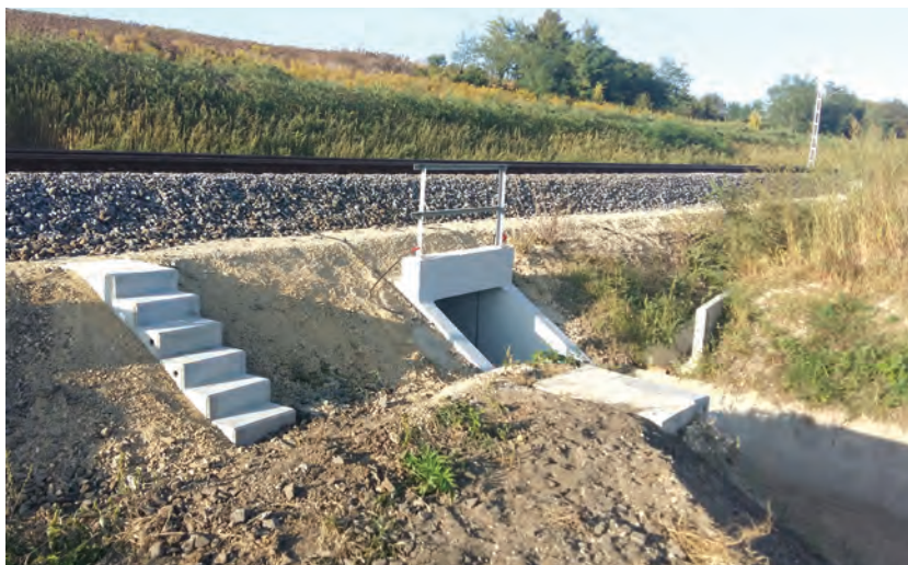
3. kép. Felújított és toldott 1,50/1,50 m nyílású átereszt (472+89)
