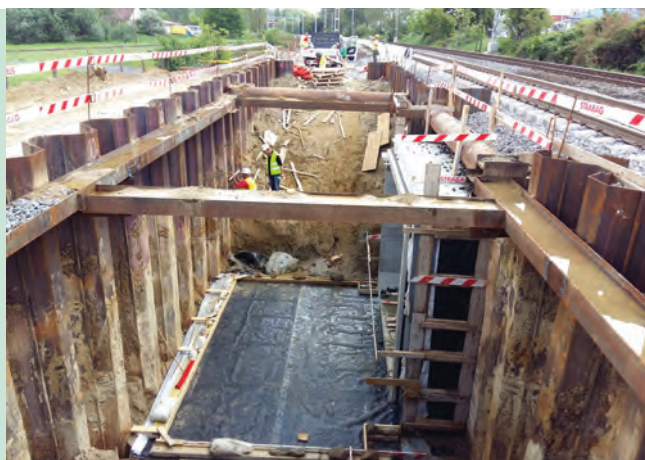
18. kép. A bal vágányba már beépített keretelemek Akadémiaútelep-nél
