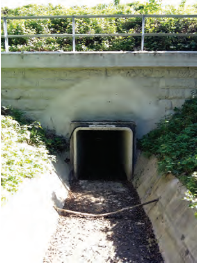
6. kép. Vasbeton kerettel bélelt boltozat
