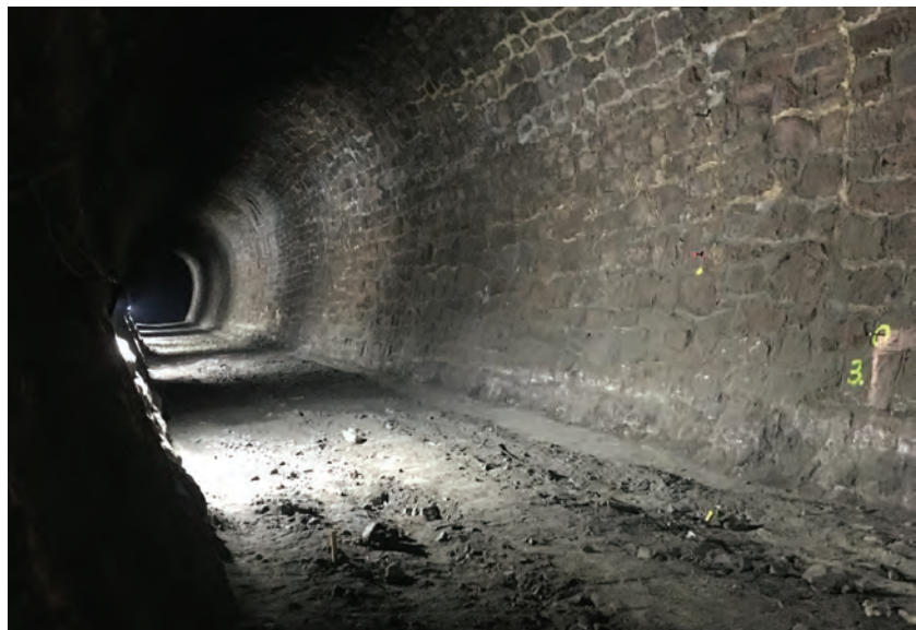
9. ábra. Az alagút a vágány elbontását követően (Fotó: Ács-Lengyel Réka)
