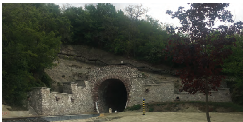
18. ábra. A megtisztított részü, felújított végponti kapuzat és támfalak (Fotó: Ács-Lengyel Réka)
