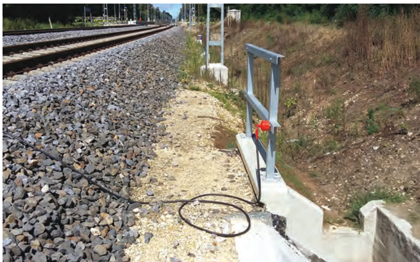
2. kép. Felújított 1,50/1,50 m nyílású átereszt (319+67)
