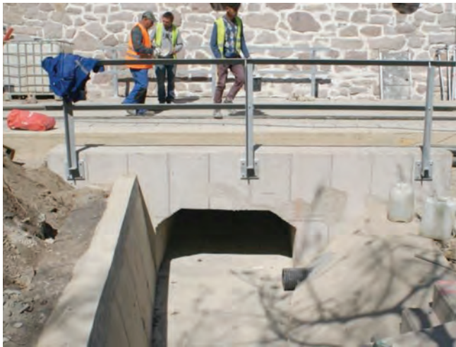
14. ábra. 1,50/1,00 m nyílású vasbeton kerethíd bal oldalról (Fotó: Ács-Lenyel Réka)
