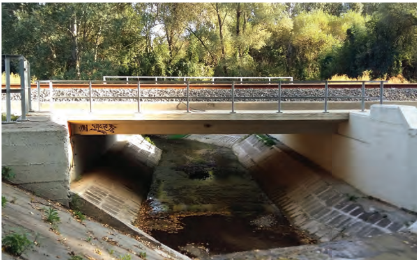
7. kép. 9,0 m nyílású Egres-patak-híd
