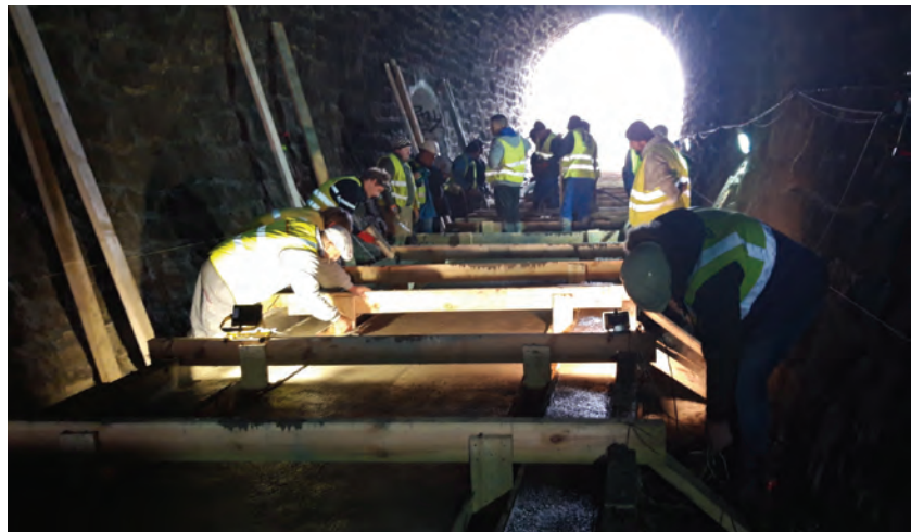
10. ábra. A vasbeton lemez betonozása (Fotó: Fonyó Sándor)
