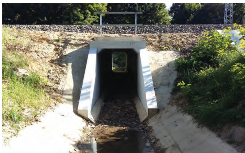
5. kép. Új építésű 1,50/2,00 m nyílású keret, a bagi Farkasvölgyi-árok
