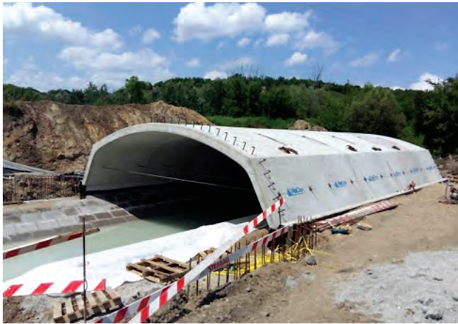
12. kép. Elhelyezett ConSpan elemek (218/9 szelvény)
