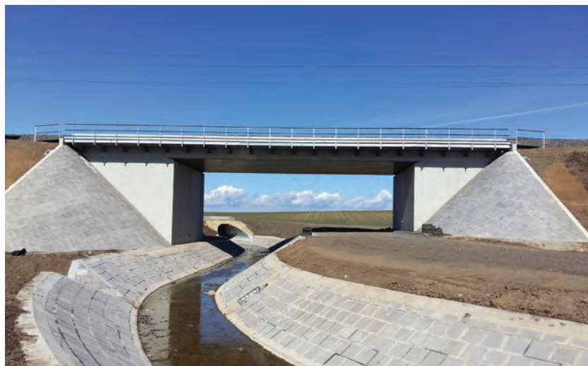
11. kép. 17,10 m nyílású tartóbetétes lemez híd az Emse-patak és földút felett
