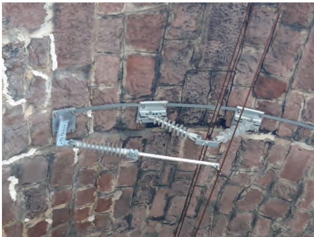
15. ábra. A villamos felsővezeték felerősítése (Fotó: Fonyó Sándor)
