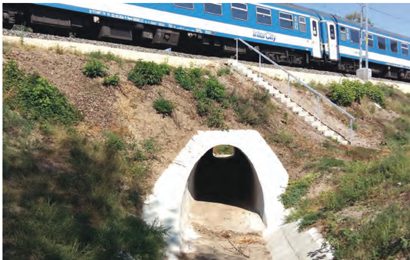
1. kép. 2,0 méter nyílású felújított beton csőáteresz
