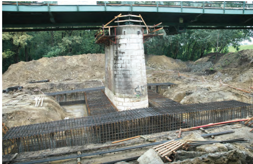
4. ábra. VIII. támasznál, nyolc réspillért összefogó gerenda vasalása készül (2018. július 9.)
