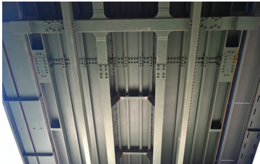
9. ábra. Hegesztett szerkezetek kialakítása az ortotróp pályalemez alatt (2020. november 19.)
