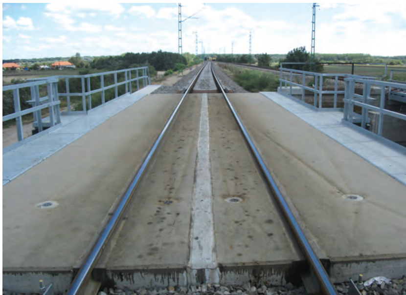
5. ábra. Besenyszögi úti híd
