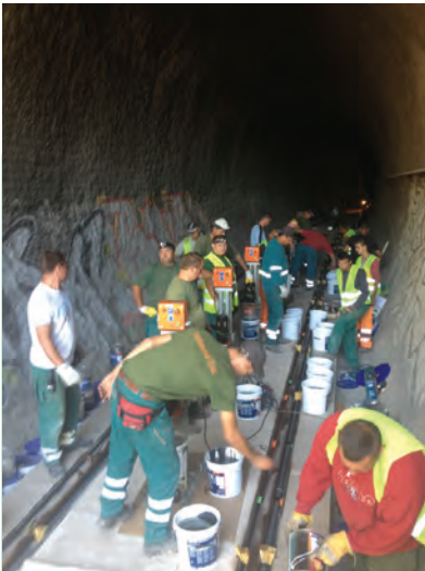
21. ábra. Készülődés a kiöntéshez a piliscsabai alagútban
