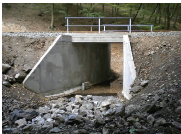
13. ábra. Bezina-patak feletti új vasbeton híd (Fotó: Legeza István)
