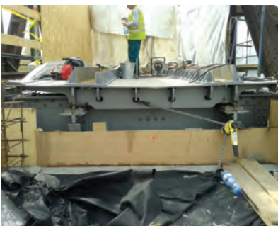
14. ábra. Szolnoki Zagyva-híd új pályalemezének szerelése
