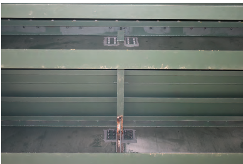
7. ábra. Hossztartó megerősítése keresztbordáknál (2020. november 19.)
