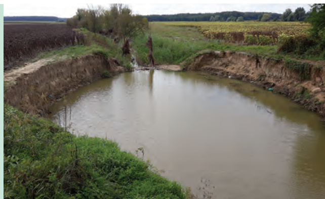
20. ábra. Alvízi meder károsodása a 488+17 hm hídnál (Fotó: Boros Hajnalka)
