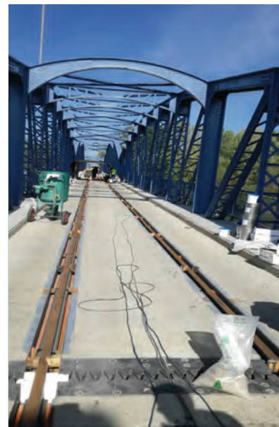
6. ábra. Vágánybeállítás a kiskörei Tisza-hídon
