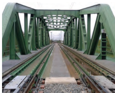
15. ábra. A kész híd az Edilon sínleerősítéssel
