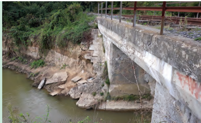
19. ábra. Töltéslezárás károsodása a 37-es vonal 488+17 hm hídnál (Fotó: Boros Hajnalka)
