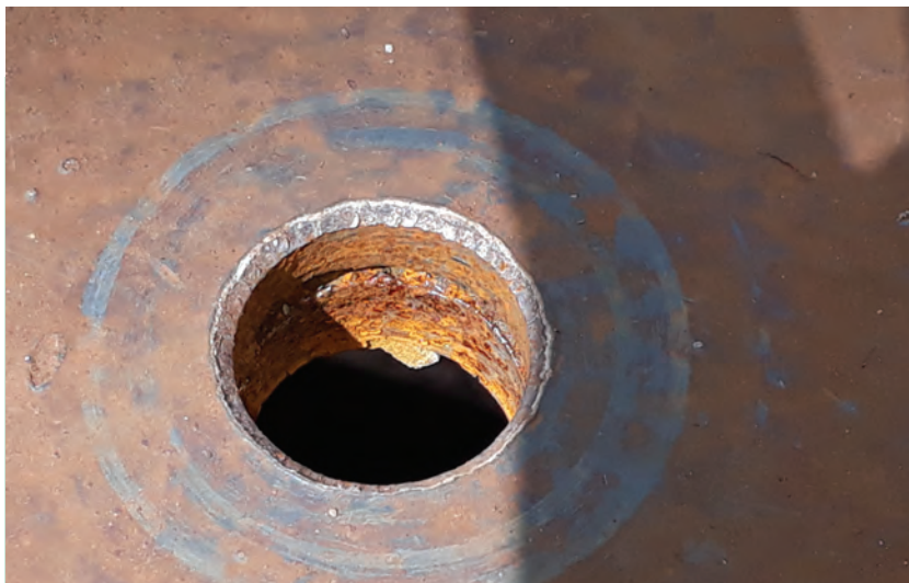
8. ábra. Rétegesség ortotróp pályalemezen Edilon furatnál (2018. június 28.)
