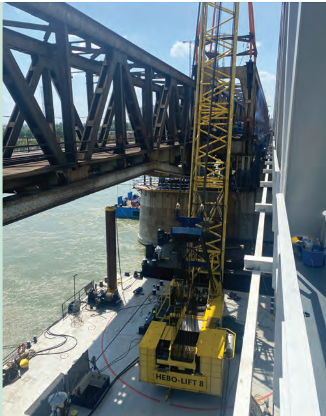
14. ábra. Pillérek feletti kiékelés bontása hidak közé beállított úszódaruvál
