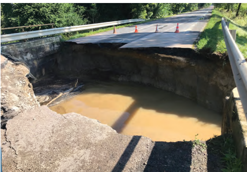
1. ábra. Segesd 68-as út 54+260 km közúti híd károsodása (Fotó: Váradi Nelli)
