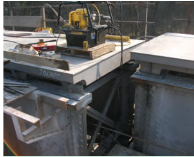
12. ábra. Az ártéri híd új pályalemezének szerelése
