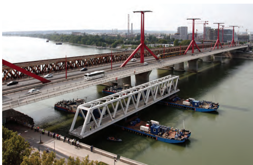
9. ábra. Beúsztatás a beépítési helyre
