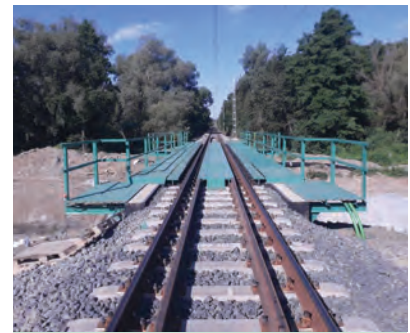
15. ábra. Az új műtárgy a forgalomba helyezés után (Fotó: Simon Ilona)
