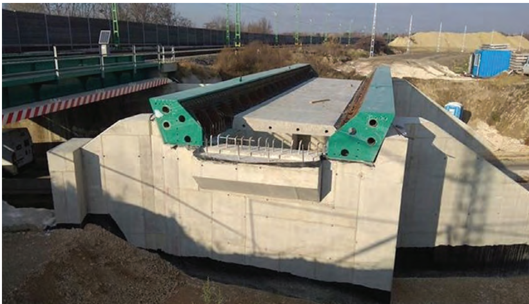
2. ábra. Érdi Velencei út feletti vasúti híd (ahid.hu)
