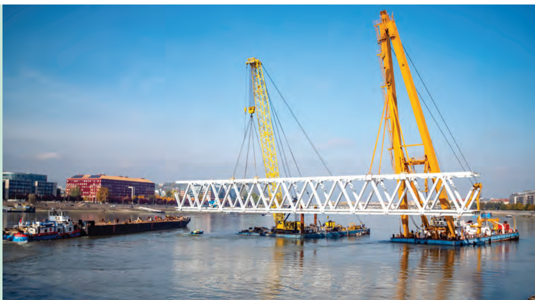
7. ábra. Nyolc ponton törtéző páros emelés (Fotó: Nagy Mihály)
