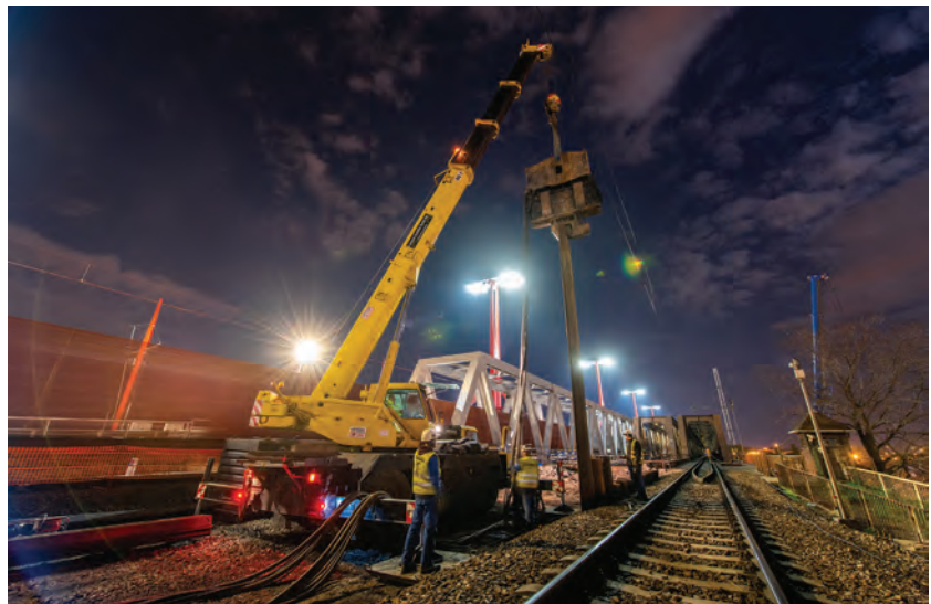
3. ábra. Hídfőépítés a kétirányú vasúti forgalom mellett (Fotó: Nagy Mihály)
