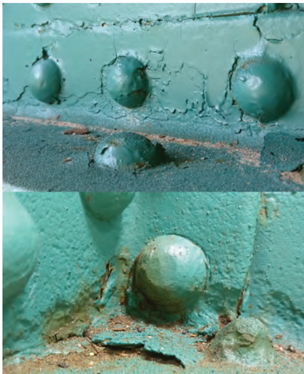
1. ábra. Nem a szabvány szerinti korrózióvédelem két év elteltével
