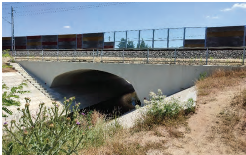
3. ábra. Elkészült CON/SPAN hídszerkezet a 277+98 hm szelvényben
