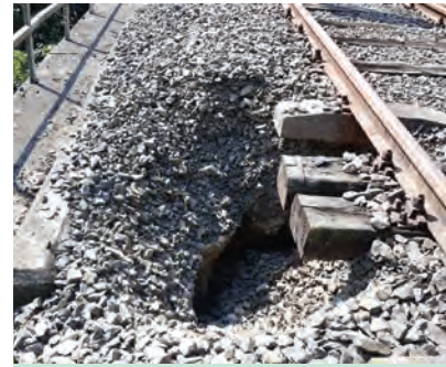
18. ábra. Árvíz utáni ágyazatráter (Fotó: Boros Hajnalka)
