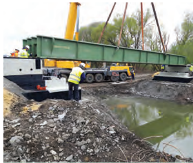
14. ábra. Az acélszerkezet beemelése (Fotó: Simon Ilona)
