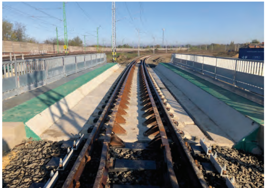
6. ábra. Elkészült Rheda 2000 vágány a hídon
