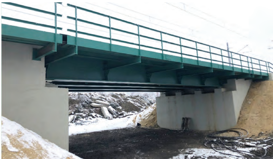
7. ábra. Elkészült Galga-híd oldalnézete
