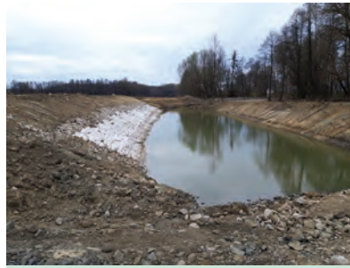
17. ábra. Az elkészült alvízi mederszakasz biztosítása a DDVIZIG-szakaszon (Fotó: Simon Ilona)
