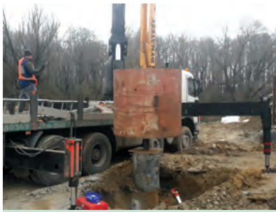
13. ábra. Dinamikus próbaterhelés ütés előtti pillanata (Fotó: Ferenczi Zoltán)
