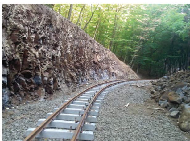
9. ábra. Vágányfektetés a szélesített bevágásban (Fotó: Kettler Ádám)
