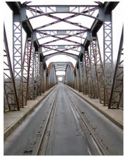
5. ábra. Átépítés előtti kisköréi Tisza-híd
