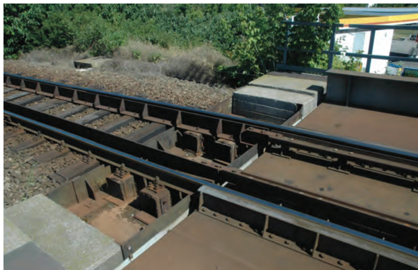
8. ábra. Magánaljak a hídcsatlakozásnál (Fotó: Lakatos István)
