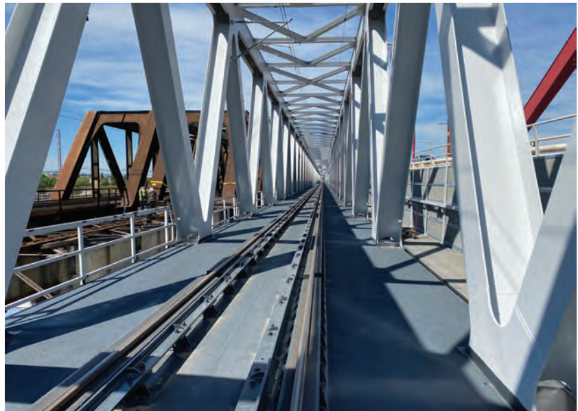
5. ábra. Elkészült korrózióvédelmi bevonatrendszer
