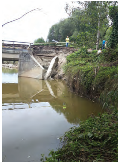
10. ábra. Felvízi meder károsodása (Fotó: Bérdi Mária)
