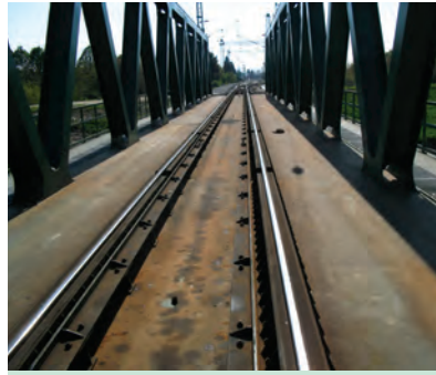
17. ábra. A Lapincs-híd pályaszerkezete
