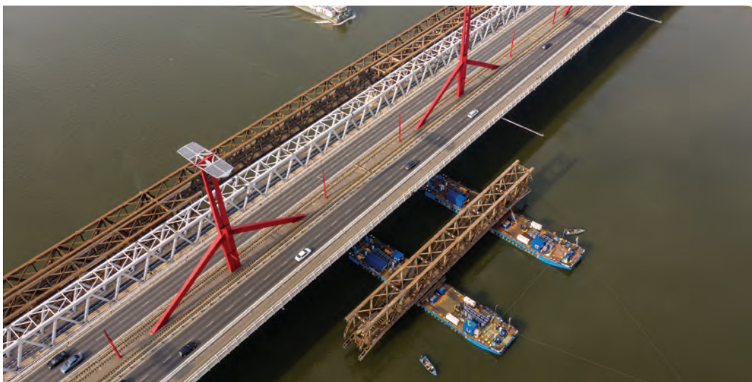
13. ábra. Bontott elem kiúsztatása, vízi forgalom mellett (Fotó: Mesterházi Dávid)
