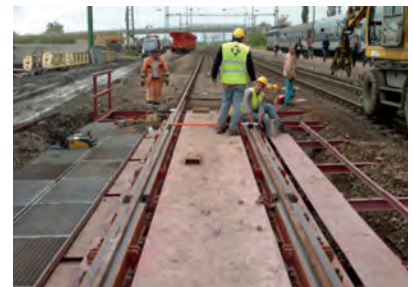
20. ábra. Mezőberény állomáson rugalmas kiöntésű provizórium
