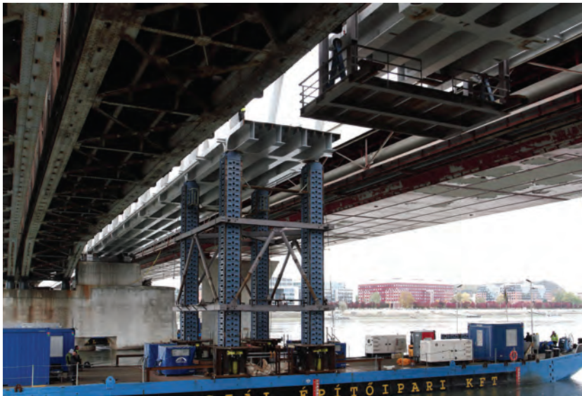
10. ábra. Az úsztatási egység felemelése
