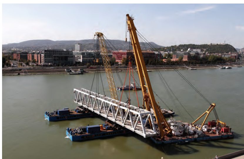
8. ábra. Úszódarús átemelés
