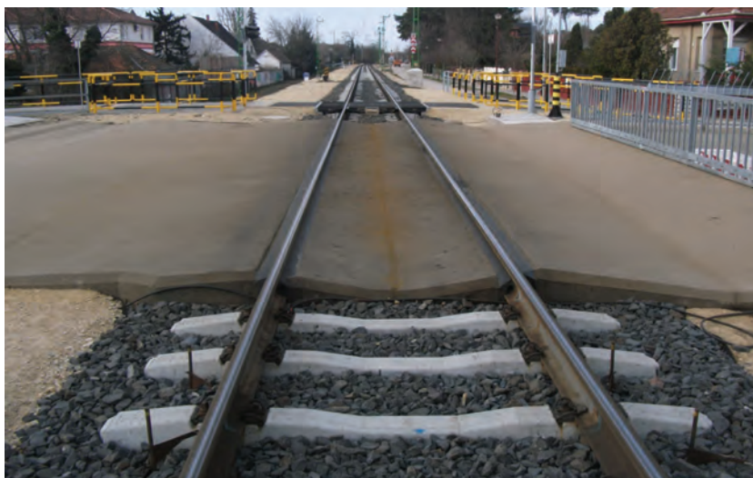
4. ábra. A siófoki Vitorlás utcai vasbeton felszerkezet
