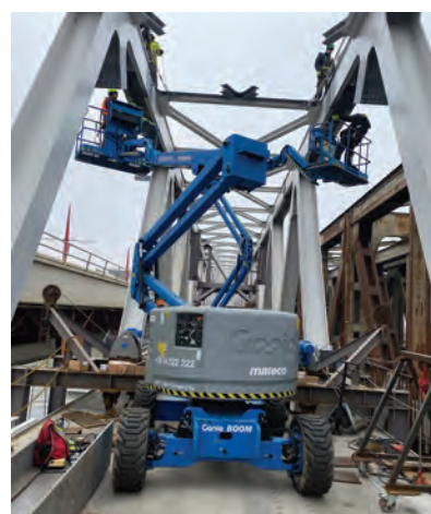
9. ábra. Úsztatási egységek illesztése
