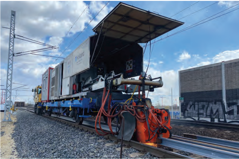
4. ábra. 60E2 R400HT sínek elektrotermikus hegesztése
