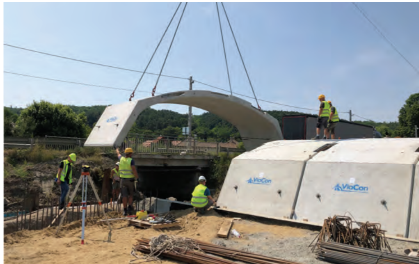
2. ábra. CON/SPAN hídelem beemelése autódaruval
