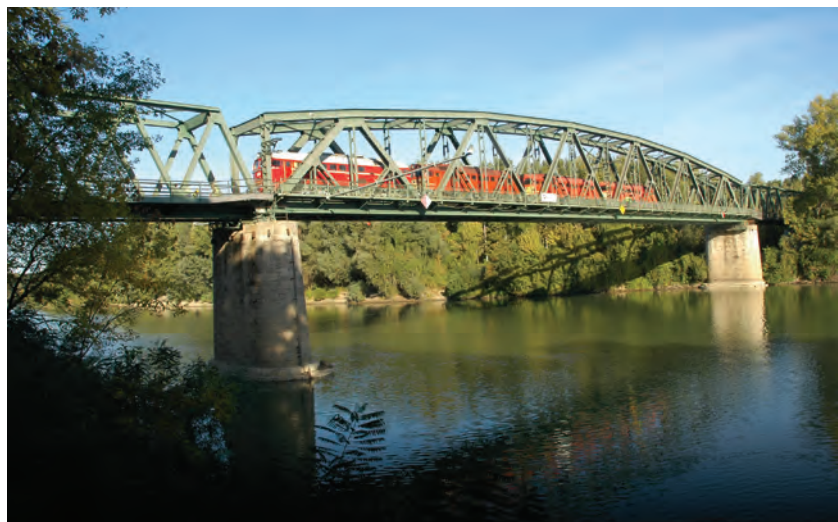
5. ábra. Próbaterhelő szerelvény a mederszerkezeten (2018. október 4.)
