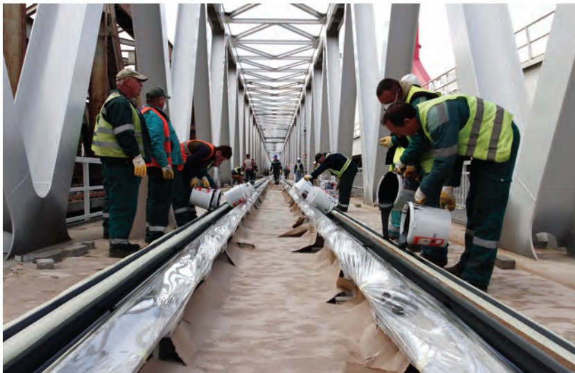
11. ábra. A sínvályú kiöntése
