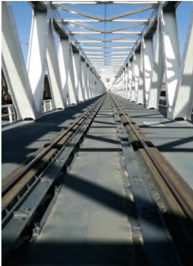
16. ábra. A Déli összekötő vasúti híd B1 hídjja
