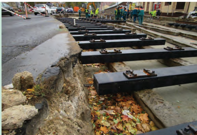
10. ábra. Vágányfektetéshez előkészített aljak Budapest, Fiumei út
