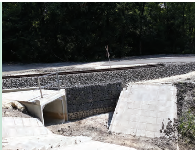
7. ábra. Az elkészült gabionfal a 16+02 kerethídnál (Fotó: Bérdi Mária)
