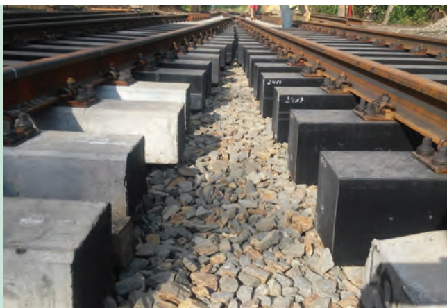
9. ábra. Beépített aljak Hódmezővásárhelyen
