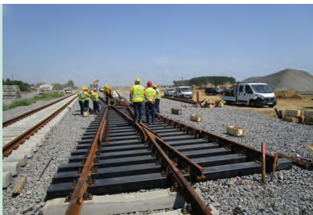
11. ábra. Kitérőaljak a fényeslitkei vágánykeresztesztésben (1435 mm és 1520 mm)
