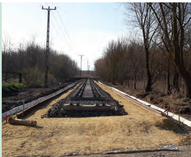
9. ábra. Épül a vasúti pálya (Fotó: Bérdi Mária) [1]
