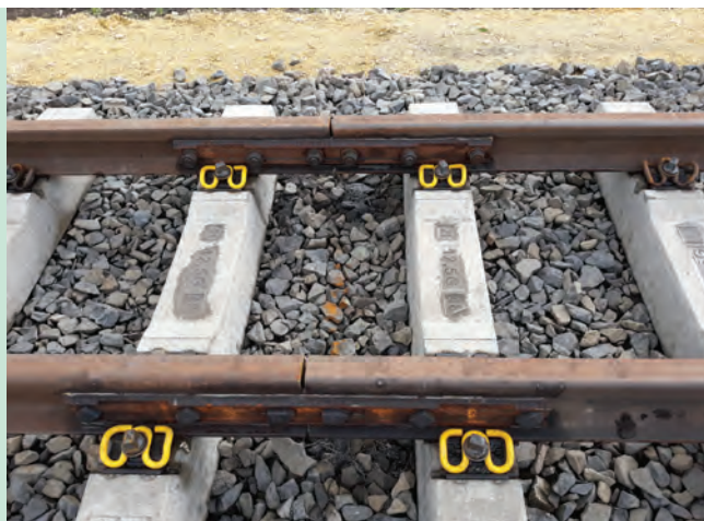
8. ábra. SKL-leerősítés az illesztésekben (Fotó: Bérdi Mária)
