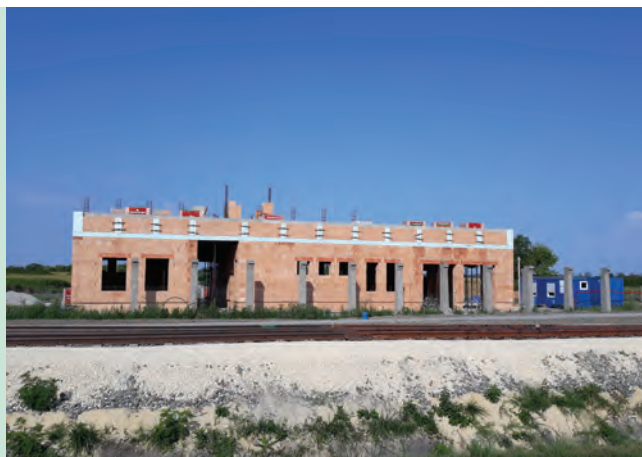
13. ábra. Az épülő állomásépület Csisztafürdőn (Fotó: Bérdi Mária)
