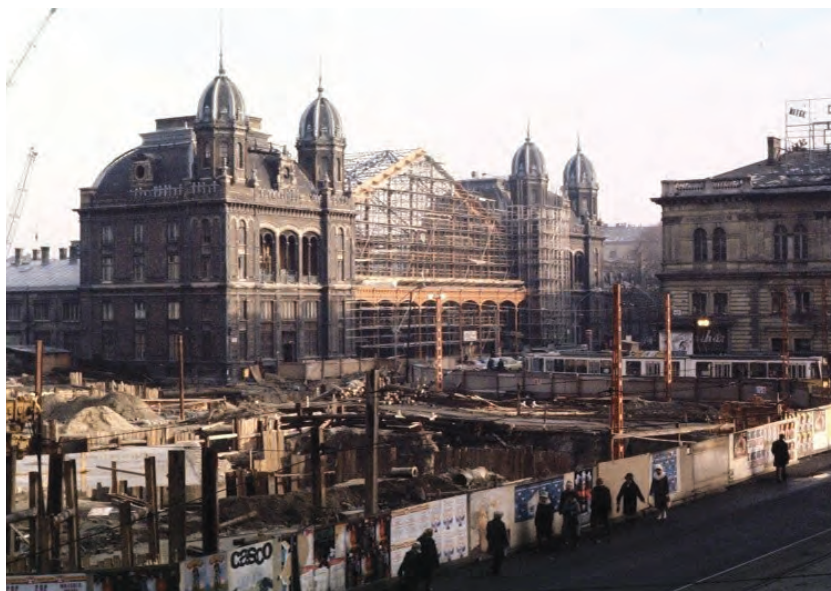
9. ábra. Metróállomás és gyalogos-aluljáró építése
