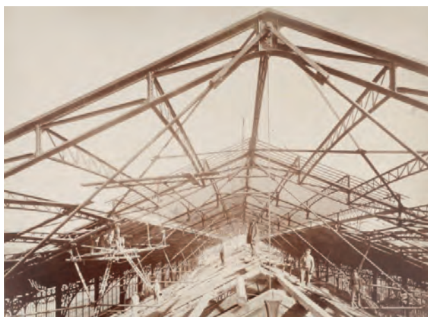
3. ábra. Az új pályaudvar vasszerkezetének építése
