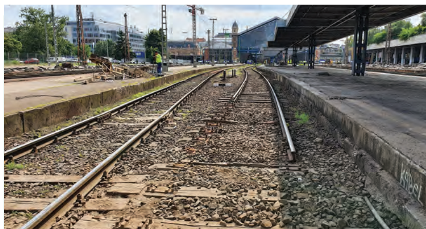
5. ábra. Hagyományos 48 rendszerű talpfás vágány bontása
