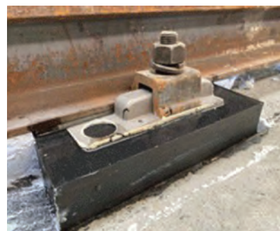
5. ábra. Diszkrét sínalátámasztás Icosit KC aláöntéssel, leforgonyzócsavarok nélkül
