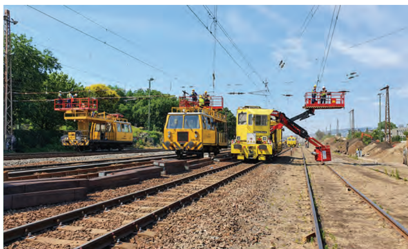
10. ábra. Felsővezeteki keresztmező cseréje
