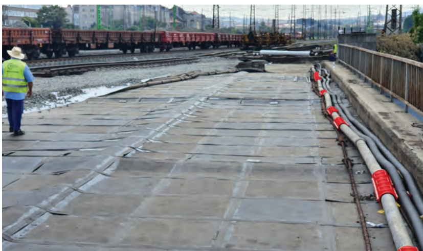
7. ábra. Vasúti felüljáró vasbeton szerkezetének szigetelése
