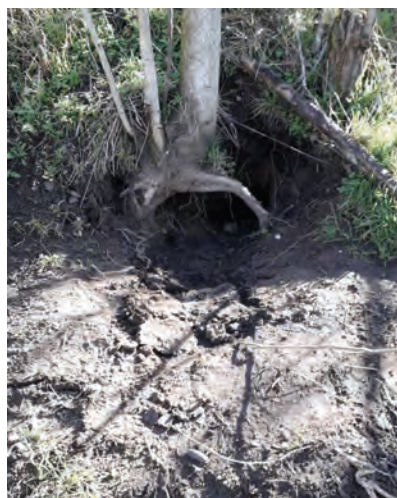
4. ábra. Borzlyuk a rézsűlábánál, egy fa gyökéréknél
