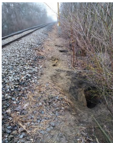
5. ábra. Lyukak a padkában is meg- jelentek
