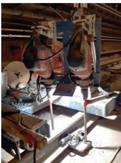
12. ábra. Furatok készítése
