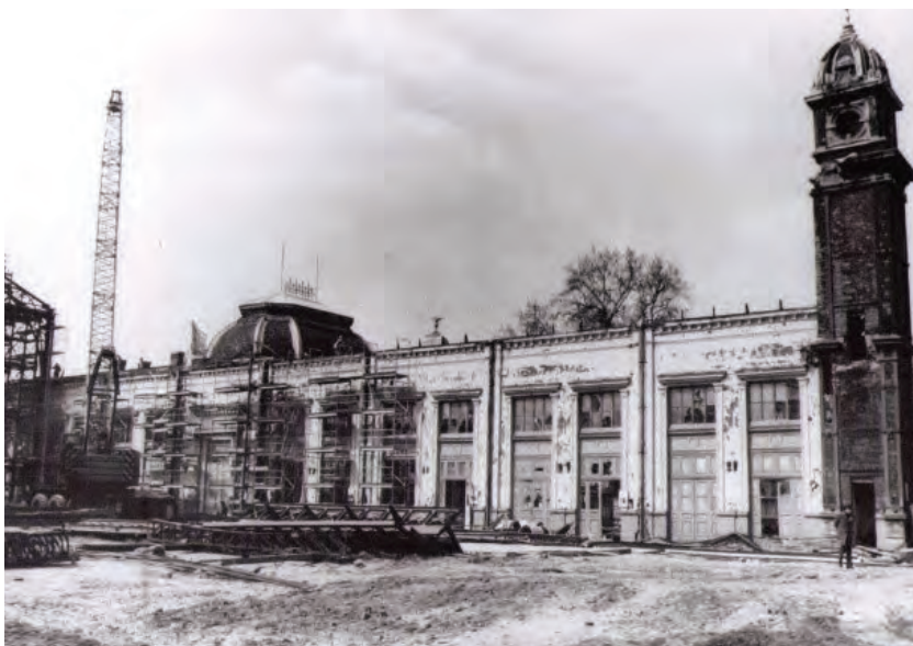
7. ábra. Az elbontott csarnokszerkezet
