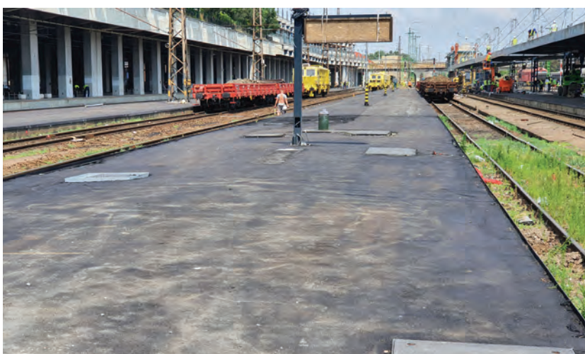
8. ábra. Peron újraaszfaltozása
