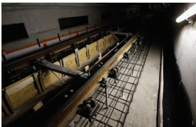
9. ábra. Vágány építése top down technológiával, betonozás előtti állapot
