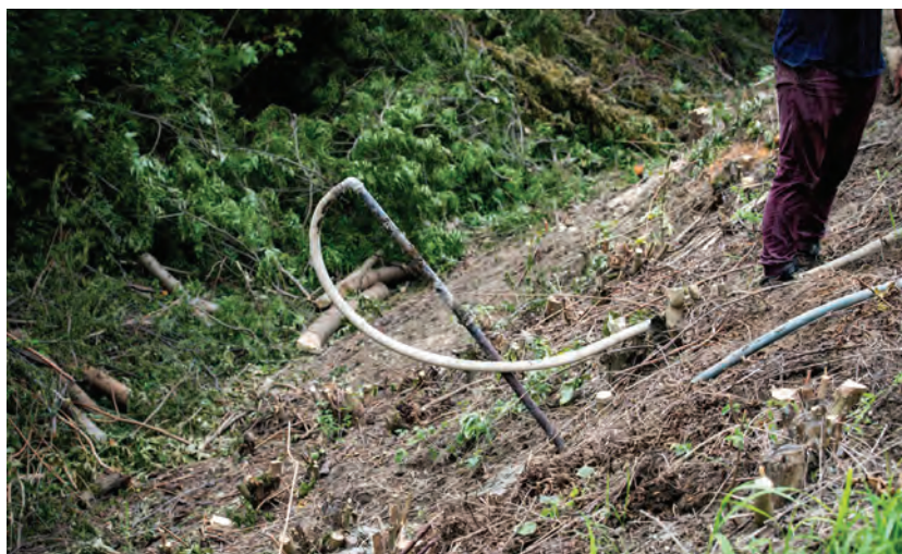
12. ábra. Injektálócső (Fotó: Bihácsy Gábor)
