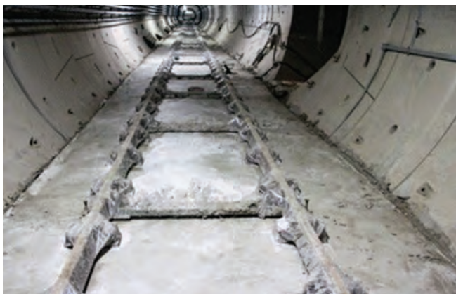
10. ábra. Vágány építése top down technológiával, betonozás utáni állapot
