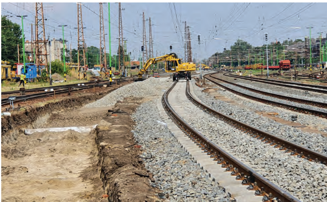
6. ábra. Hézag nélküli 54 rendszerű vasbetonaljas vágány építése
