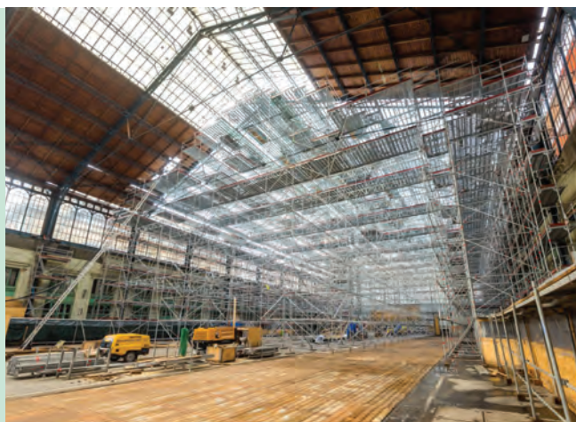
12. ábra. Építési állvány a csarnokban
