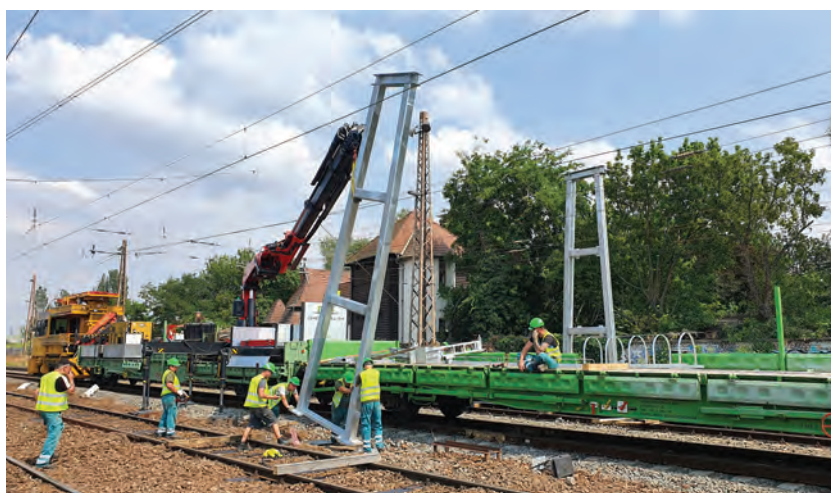
11. ábra. Jelzőhíd építése a bejáratnál
