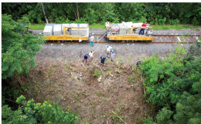
11. ábra. Az injektálás végrehajtása (Fotó: Bihácsy Gábor)
