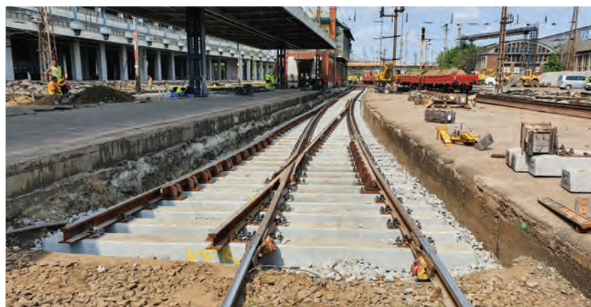
4. ábra. Betonaljas kitérő beépítése
