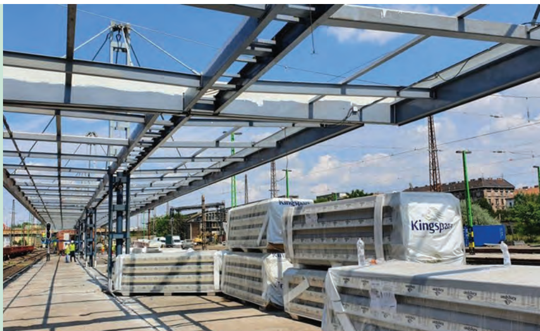
9. ábra. Acélszerke- tű perontető felújítása a X-XI. vágányok között
