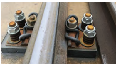
4. ábra. Diszkrét sínalátámasztás Icosit KC aláöntéssel egy lengyelországi vasúti hídon
