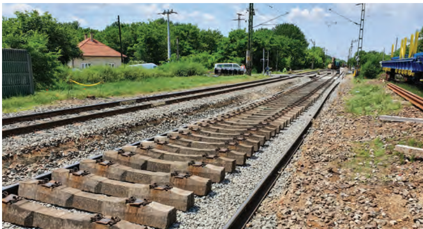
3. ábra. Földmunkás ágyazatcserével átépülő vágányszakaszi Üllőn
