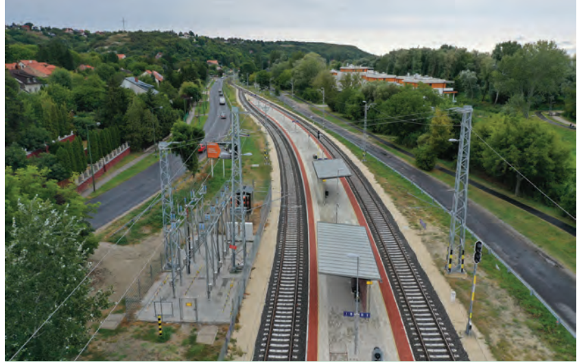
15. ábra. Balatonfüzfő állomás a műszaki átadás után. (Fotó: Bárdics Róbert)
