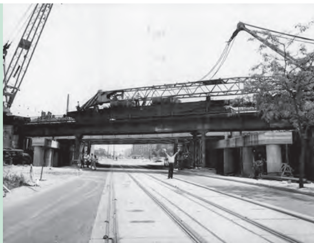
14. ábra. Az Üllői úti vasúti híd re- konstrukciója
