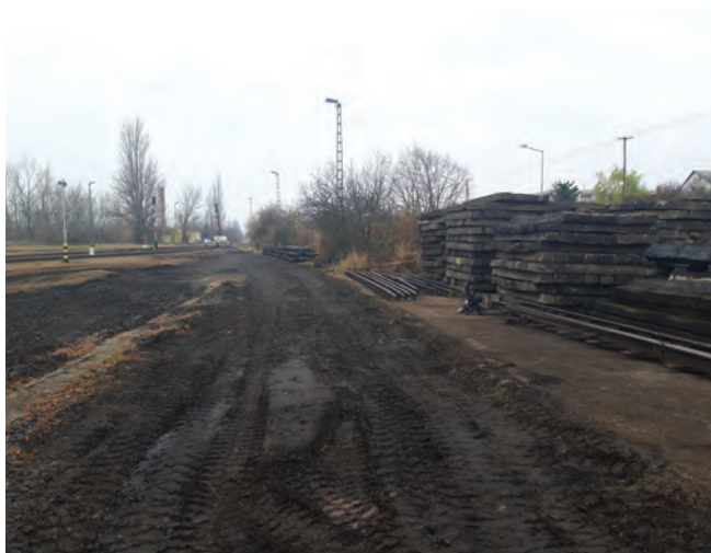
3. ábra. Alsóörs állo- más végponti oldala a VI.-VII. vágány el- bontása után. (Fotó: Czuczay László)
