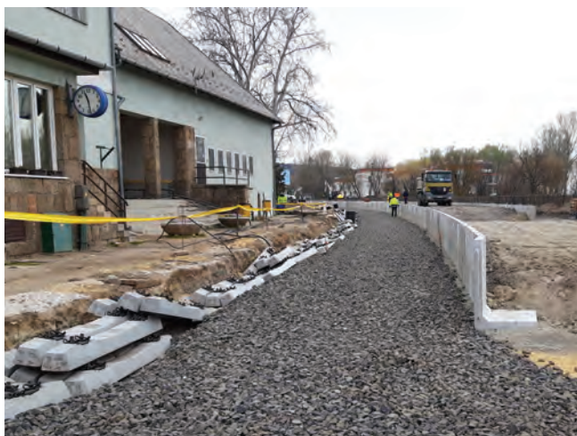
4. ábra. Balatonfüzfő állomáson épül az Sk+55- ös utasperon. (Fotó: Czuczay László)
