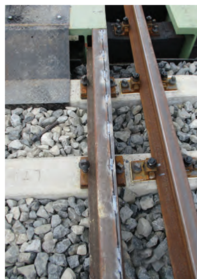
11. ábra. Terelősin-kihegesztés. (Fotó: Giczi Katalin)
