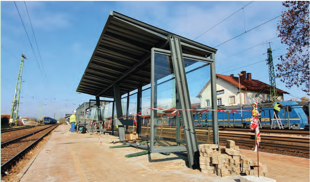
10. ábra. Utaseállók építése Monoron
