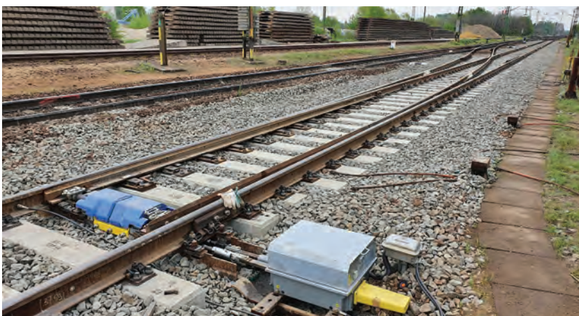
7. ábra. Újonnan beépült B60 XI. rendszerű kitérő Üllőn
