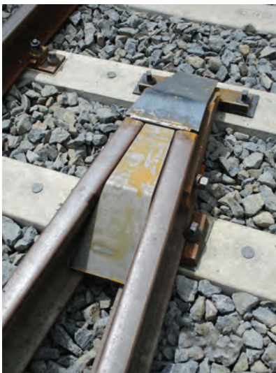
12. ábra. Terelő sín-véglezáró belső ütésgátlóval. (Fotó: Giczi Katalin)
