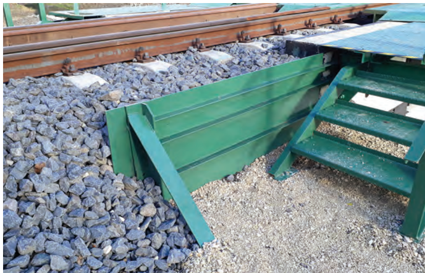
13. ábra. Padkalépcső és ágyazatmegtámasztó lemez felszerelve. (Fotó: Giczi Katalin)
