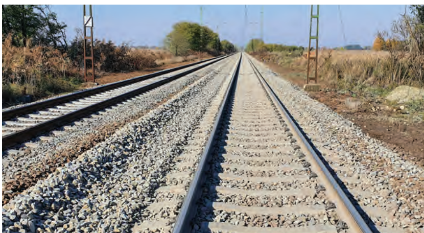
4. ábra. Az átépült nyílt vonal Üllő–Monor állomásközbén
