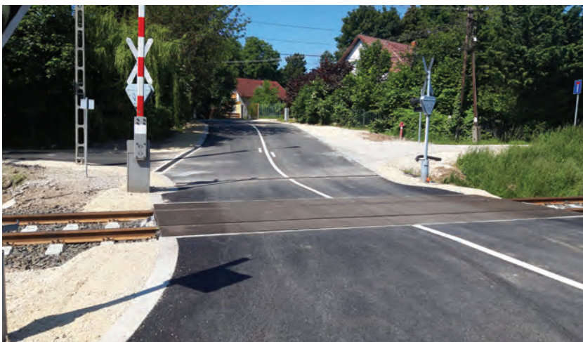
18. ábra. Balatonfüzfő-Balatonalmádi állomásköz 487+10 útátjáró. (Fotó: Czuczay László)
