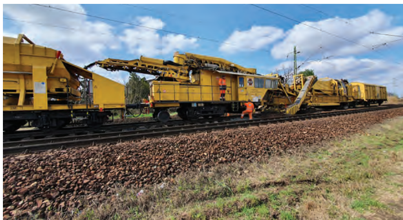
2. ábra. Ágyazatrostálás Vecsés–Üllő állomásközben
