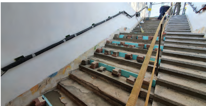
8. ábra. Peronra vezető lépcső felújítása Üllőn
