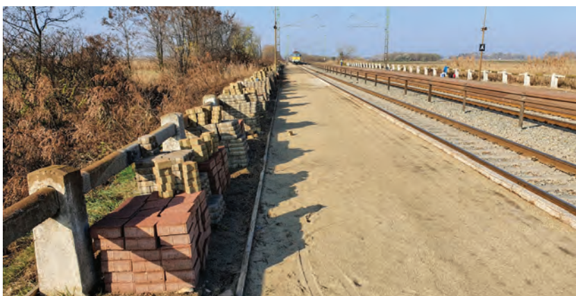
5. ábra. Peronburkolat felújítása Hosszúberek–Péterin
