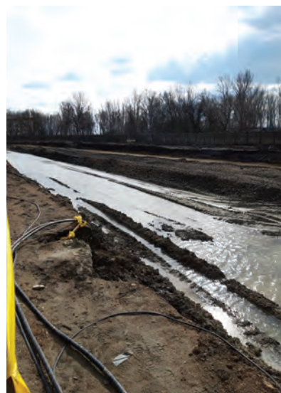
6. ábra. Balatonfüzfő állomás I. vágányának munkagödre talajvízzel telve. (Fotó: Czuczay László)
