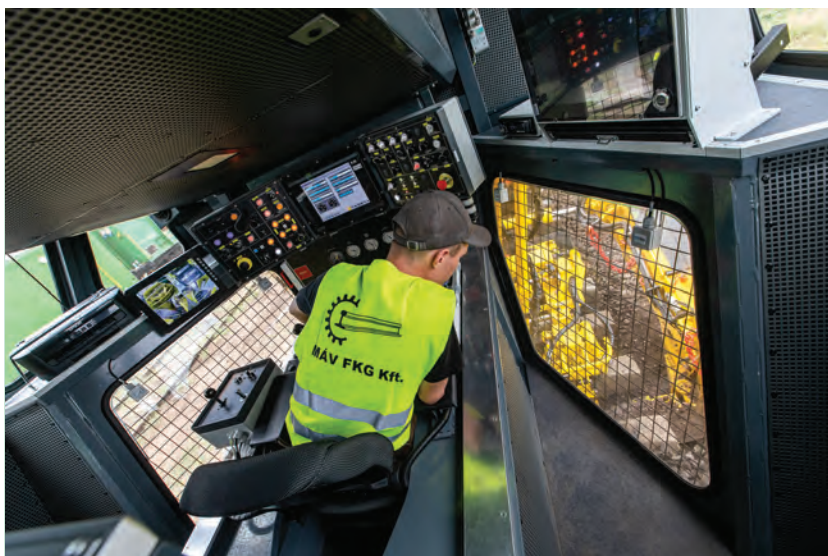
3. ábra. Az ágyazatrostáló gép munkakabinja
