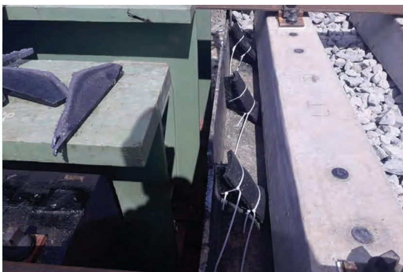
10. ábra. Ágyazatmegtámasztó borda átalakítása. (Fotó: MÁV FKG Kft., Ferenczi Zoltán)
