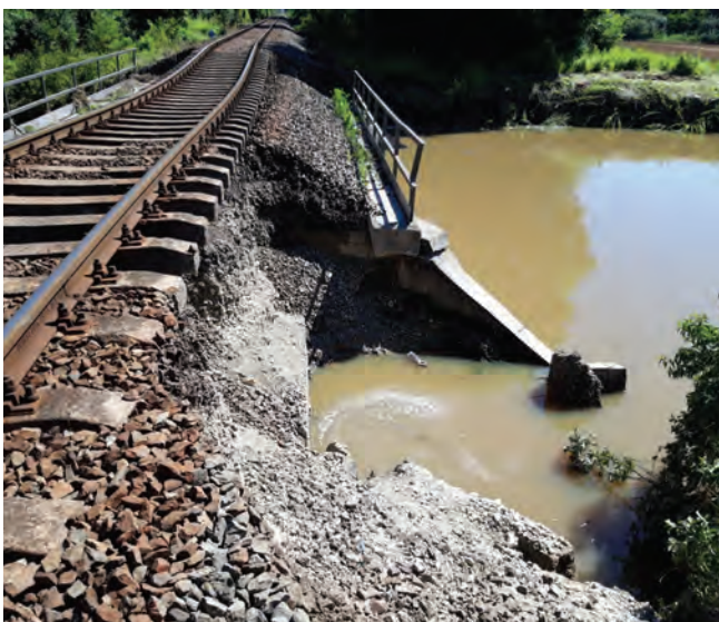
1. ábra. Sérült műtárgy és pályarész a 41. vv. Beleg-Somogyszob 650+35 szelvényében. (Fotó: PFT. Főnökség Dombóvár)
