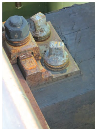
9. ábra. Alábélelt leerősítés a jobb sínszámban. (Fotó: Giczi Katalin)
