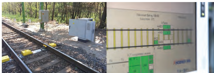
2. ábra. Phoenix MDS HBD/HWD – hőnfutás- és szorulófék-jelző rendszer (Rákoscrt bal vágány)
