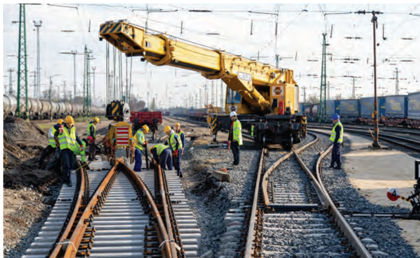
12. ábra. Előszerelt kitérő beépítési helyre emelése Kirow vasúti daruval
