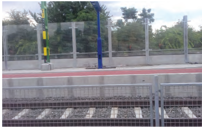
10. ábra. Érdliget megállóhelyen átlátszó zajárnyékoló fal
