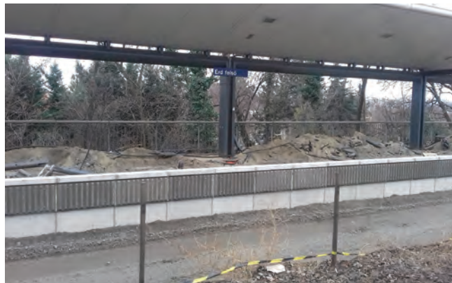
11. ábra. Érd felső megállóhely peronszegély LDP zajelnyelővel
