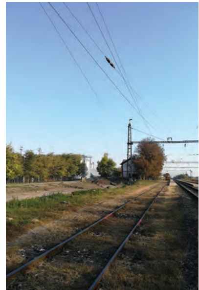
3. ábra. Iváncsa állomás átépítés előtt
