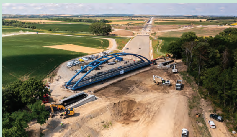
1. ábra. A készre szerelt és tolásra váró ívhíd
