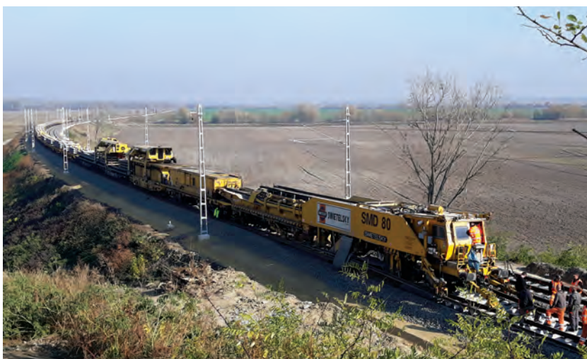
16. ábra. A felépítményt az SMD-80-as gép alakította ki
