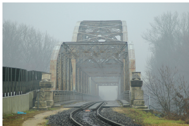
5. ábra. A már önállóan csak vasúti forgalmat szolgáló híd. (Fotó: Lakatos István)
