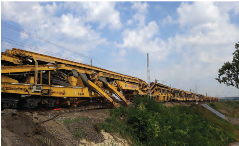
15. ábra. Az új alépítményt a PM 1000-es gép építette
