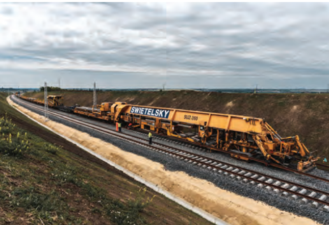
10. ábra. SUZ-350 gép- lánc munka közben
