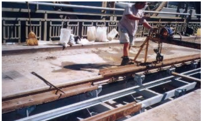
3. ábra. Terelősín építése vízszintes gerinccel fekvő sínekkel (Fotó: Kiss Józsefné)
