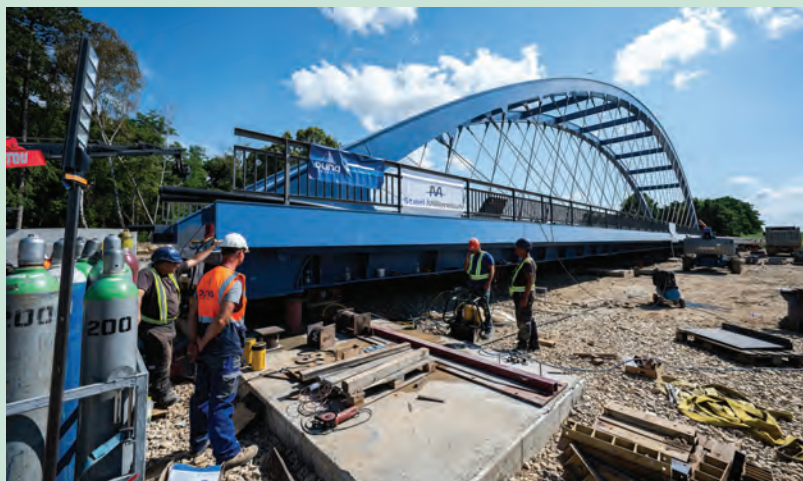
2. ábra. Megkezdődött a híd vasúti tengelybe tolása
