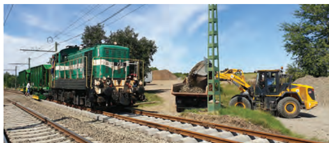
9. ábra. Anyagszállítás HÉV-vel. (Fotó: Papp Helga)
