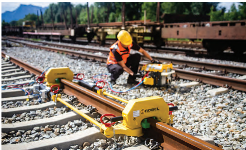
2. ábra. Sínfeszítő akkumulátorral hajtott hidraulikus szivattyúval
