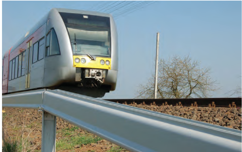
4. ábra. Egyedi GRP-kábelcsatorna
