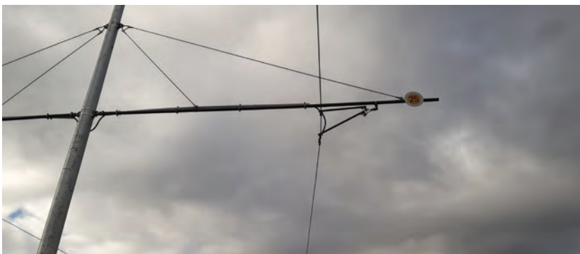
4. ábra. Lassújel-jelző tábla kihelyezése a keresztsodronyra. (Fotó: Garai Mihály)
