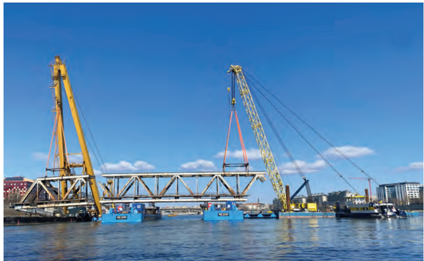
4. ábra. A régi felszerkezet megmentése, hogy Zichy hídként újjáéledhessen
