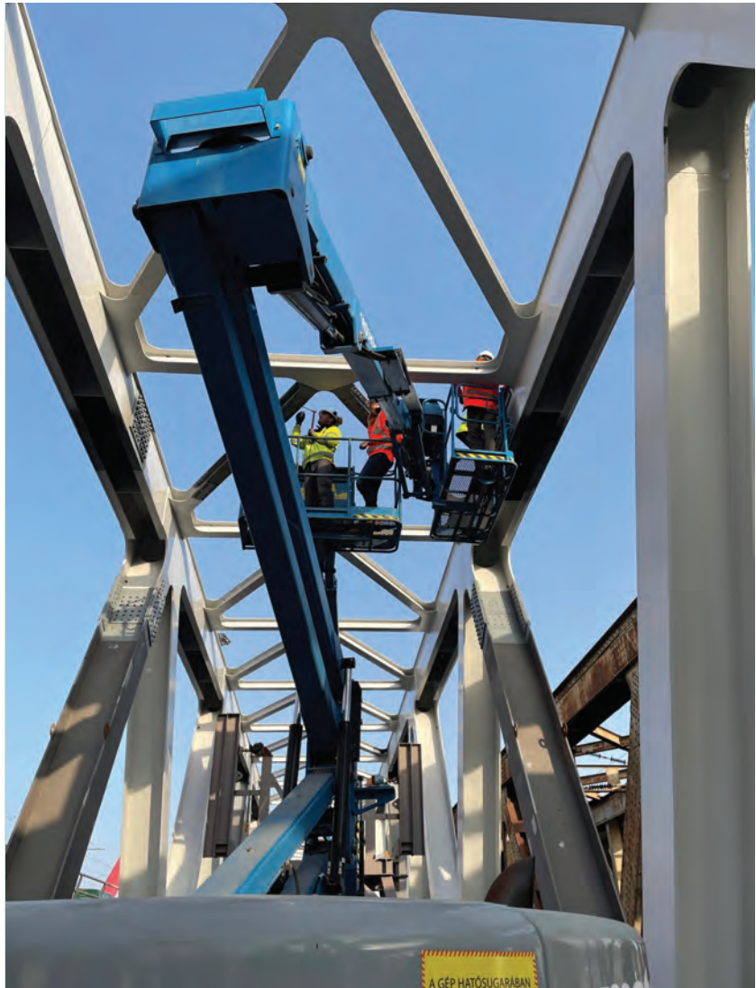
2. ábra. Úsztatási egységek helyszíni csavarozása. (Fotó: Gazdag Gergő)
