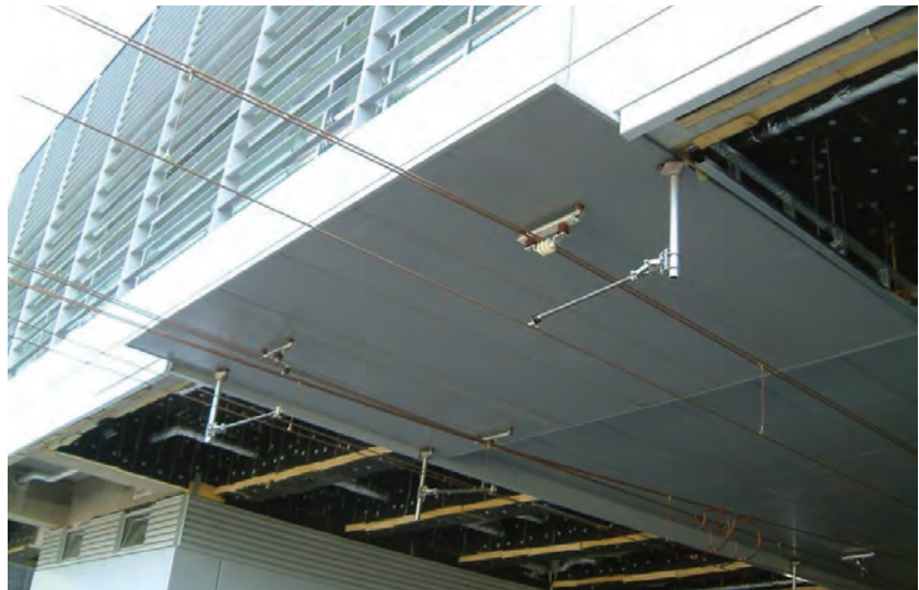
5. ábra. GRP-lemezek magasfeszültségű közegben
