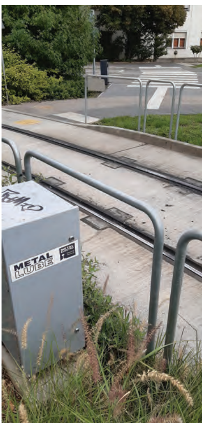
6. ábra. MetallUBE elektronikus vezérlésű sínkenő berendezés. (Fotó: Garai Mihály)
