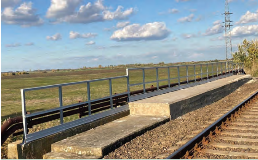
2. ábra. GRP biztonsági korlát. MÁV Újszász Tápió-híd. (Fotó: Avius Kft.)
