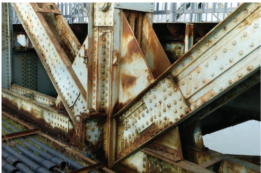
2. ábra. A meglévő hídszerkezet részlete
