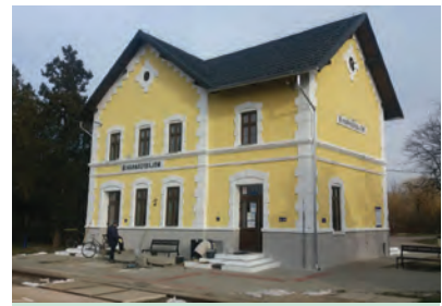
5. ábra. Biharnagybajom állomásépület. (Fotó: Lehotkay Tamás)
