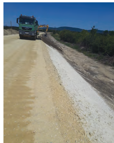
15. ábra. Töltésrészsű védelmének kialakítása humuszterítéssel
