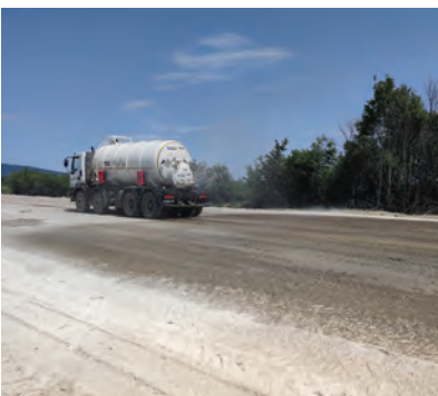
11. ábra. Stabilizált felület utókezelése vízzel
