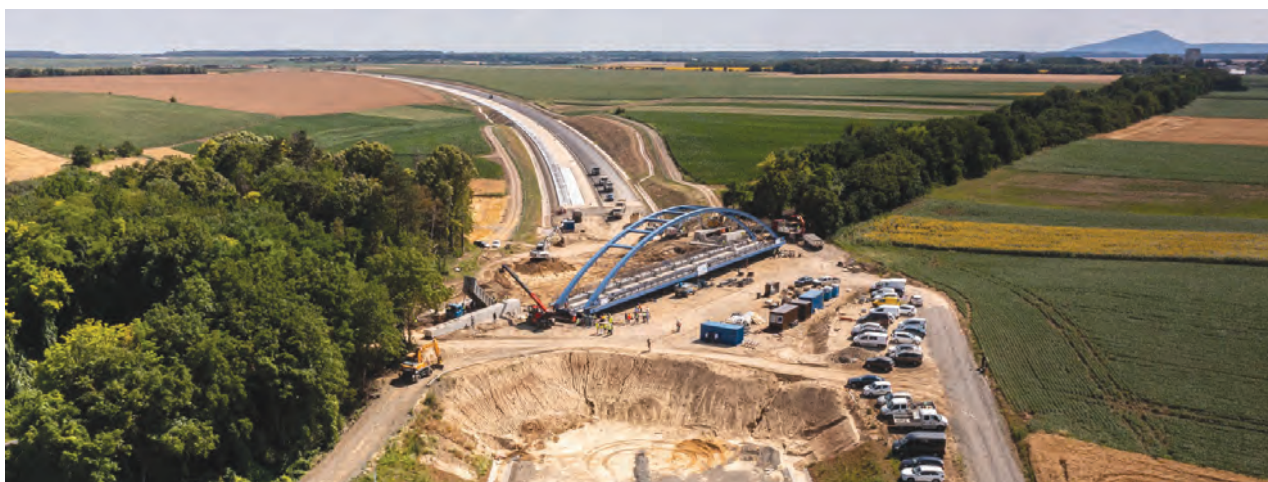
1. ábra. Betolás előtt a szerelőtéren. (Fotó: NIF)
