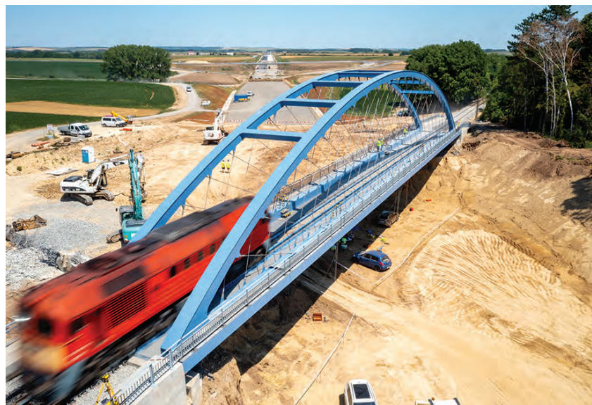
5. ábra. A híd dinamikus próbaterhelése
