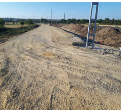
23. ábra. Felsővezeték-oszlopok beépítése padkaszélesítéssel
