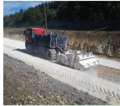
8. ábra. Kötőanyag homogenizálása marógéppel
