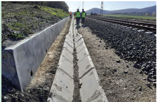
21. ábra. Felújított bélésfal új vízkivezető nyílásokkal, Mócsán-folyóka
