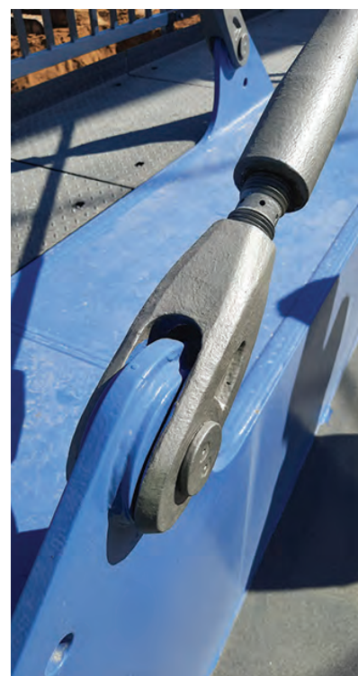
5. ábra. Villásfejes kábelbekötés
