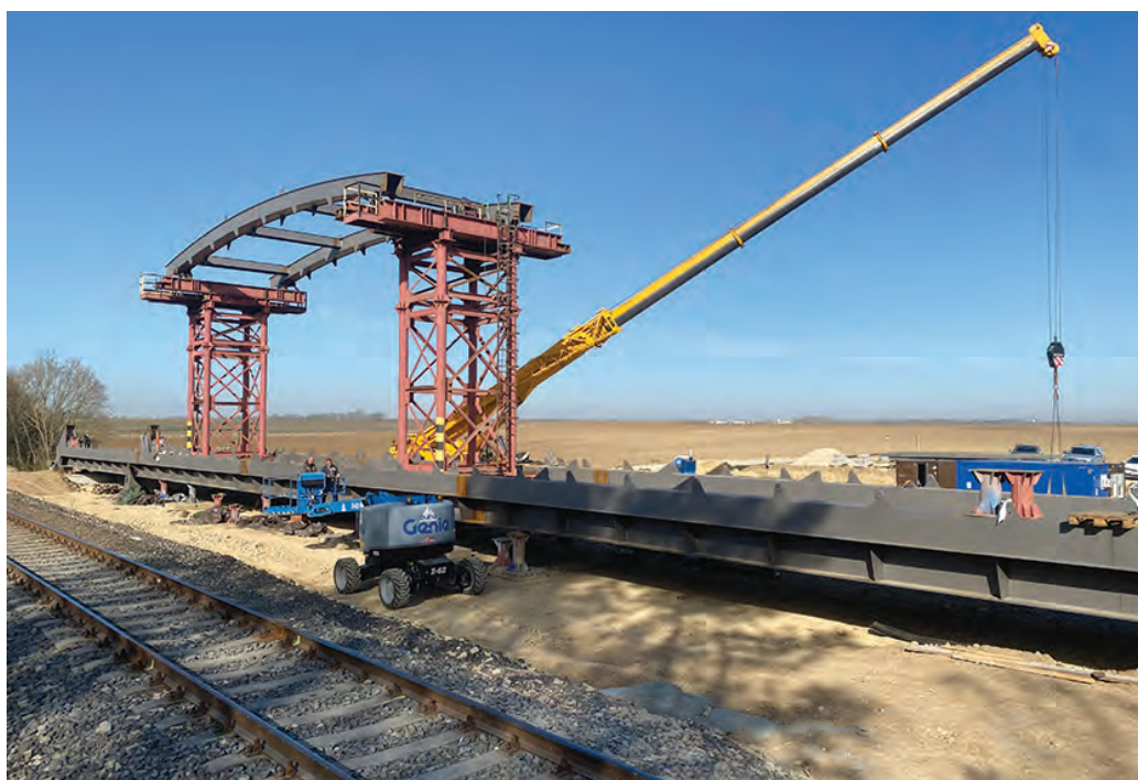
1. ábra. Az ív szerelése középről kezdve
