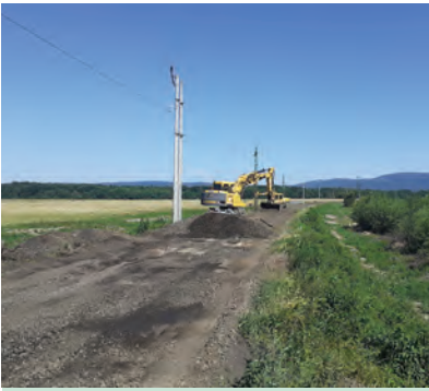
6. ábra. A pálya és tartozékainak bontása
