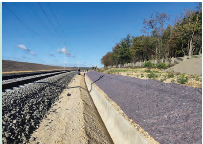
24. ábra. Rézsűvédelem fűmagos geotextília beépítésével
