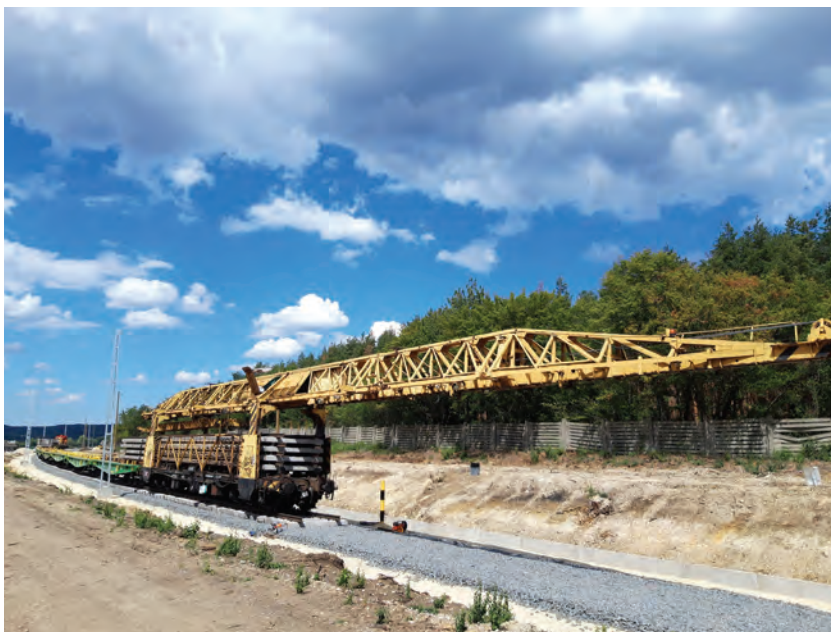
25. ábra. Vágánymezők fektetése Platov daruval
