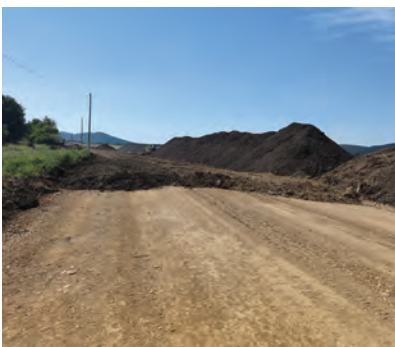
16. ábra. Töltéstalajok visszaépítése a második 50 cm-es réteg stabilizálásához
