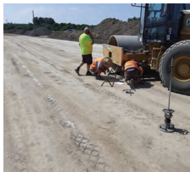
12. ábra. Teherbírási- és tömörségmérés a talajstabilizációs rétegen
