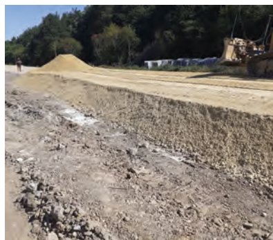
17. ábra. SZK1 jelű kiegészítő réteg beépítése a földmű zárórétegeire
