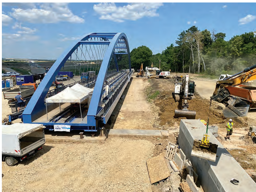
2. ábra. A vasúti pálya elbontása
