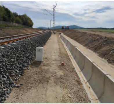
19. ábra. Vízzáró anyagból épült háttöltés támfalás árkok mögött
