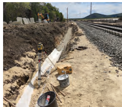
18. ábra. Burkolt szegélyárok építése bevágásban
