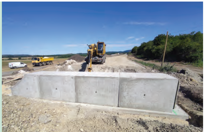
22. ábra. Új, 1,5x1,50 m nyílású vasbeton kerethíd az 555+28-as szelvényben
