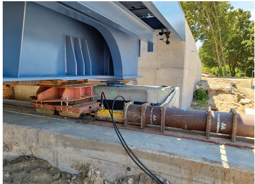
2. ábra. Tolópálya és berendezései
