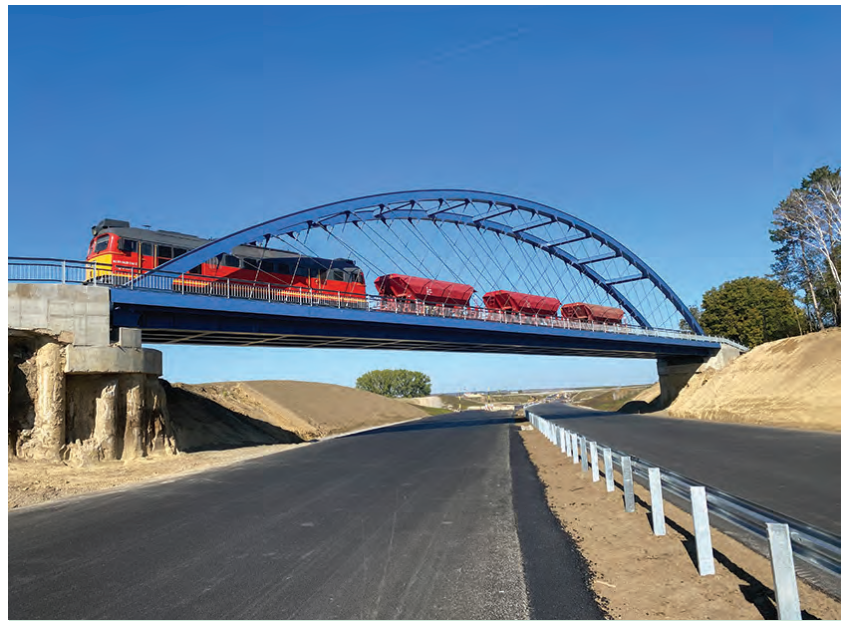
4. ábra. A híd statikus próbaterhelése
