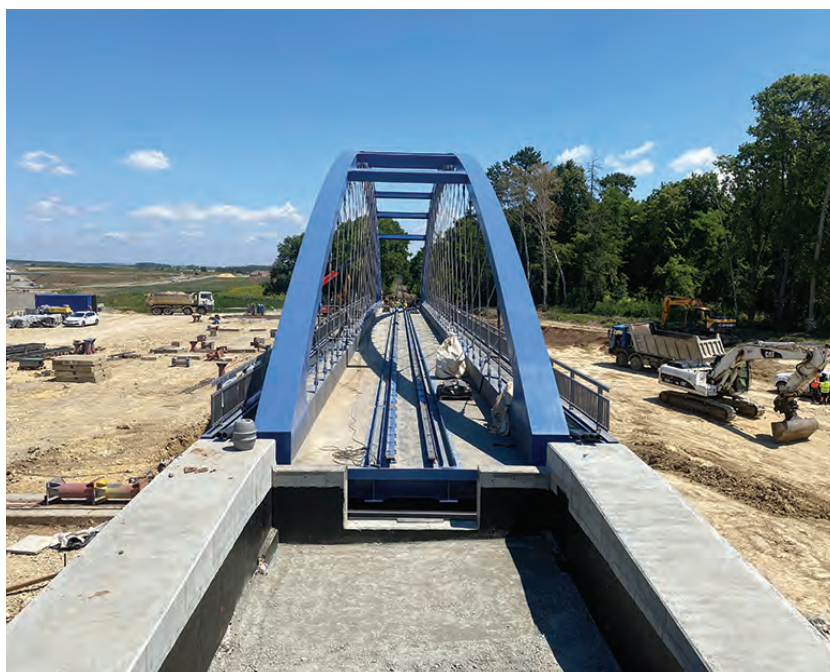
3. ábra. A végleges helyére tolt hídszerkezet
