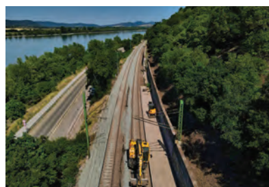
10. ábra. Gépi vágánytakarítás 2022-ben. (Fotó: MÁV FKG Kft.)
