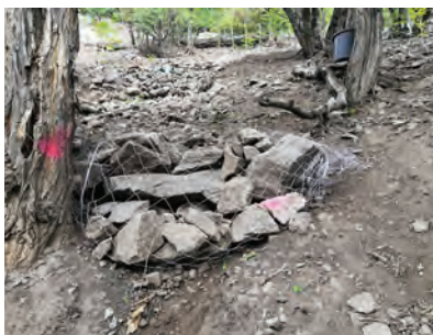
6. ábra. Gabion kosár helyi anyagból II. (Fotó: Csúcs Alpin Kft.)
