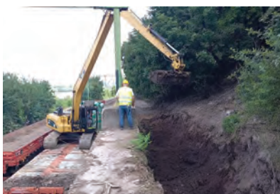
9. ábra. Hordalék kitermelése két vágány lezárásával. (Fotó: Dézsi Zoltán Csaba)
