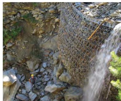
12. ábra. Alapközethez rögzített gyűrűs védőháló. (Fotó: Geobrugg AG)
