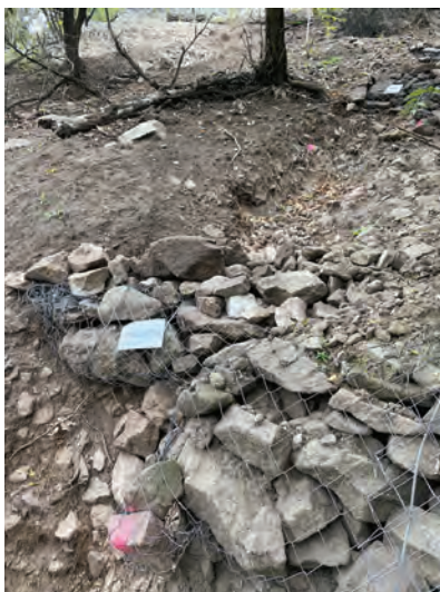
5. ábra. Gabion kosár helyi anyagból I. (Fotó: Csúcs Alpin Kft.)
