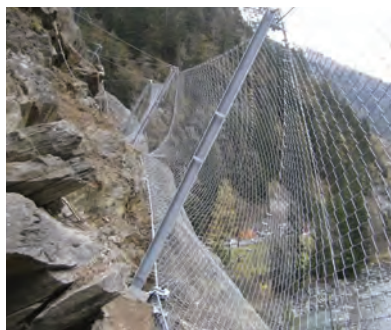
11. ábra. Befűrt oszlopokhoz rögzített védőháló. (Fotó: Geobrugg AG)
