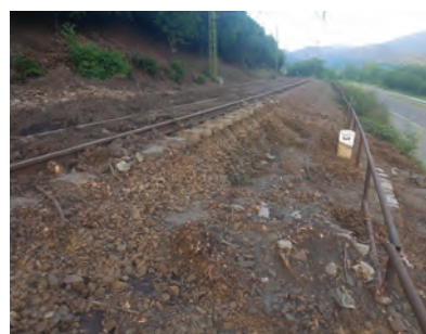
3. ábra. Hordalékátfolyás a védő műtárgy nélküli szakaszon. (Fotó: Dézsi Zoltán)
