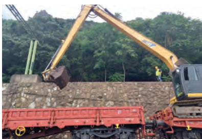
8. ábra. Hordalék kitermelése a védműtárgy mögül. (Fotó: Dézsi Zoltán Csaba)
