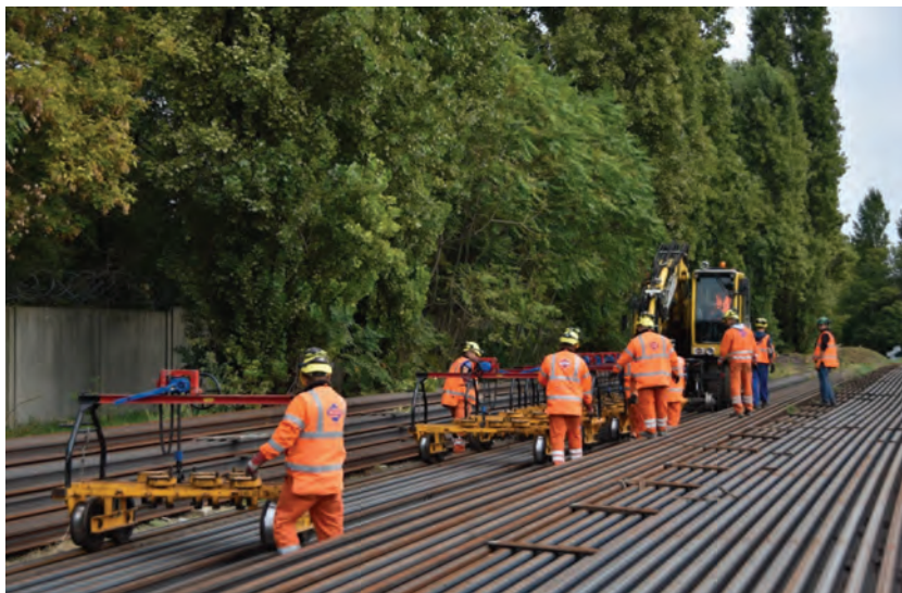
1. ábra. A 108 méteres sínek előkészítése a szállításra
