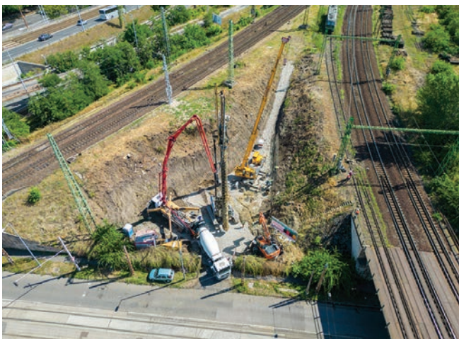
6. ábra. Próbacölöp készítése. (Forrás: V-Híd Zrt.)
