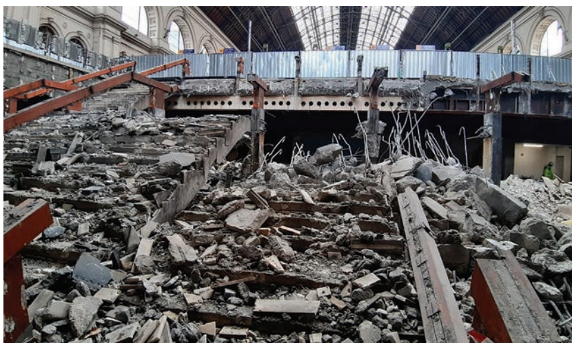
8. ábra. A régi vasbeton lépcső bontása
