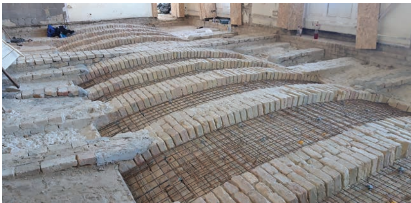
13. ábra. Előkészített földémszakasz betonozás előtt
