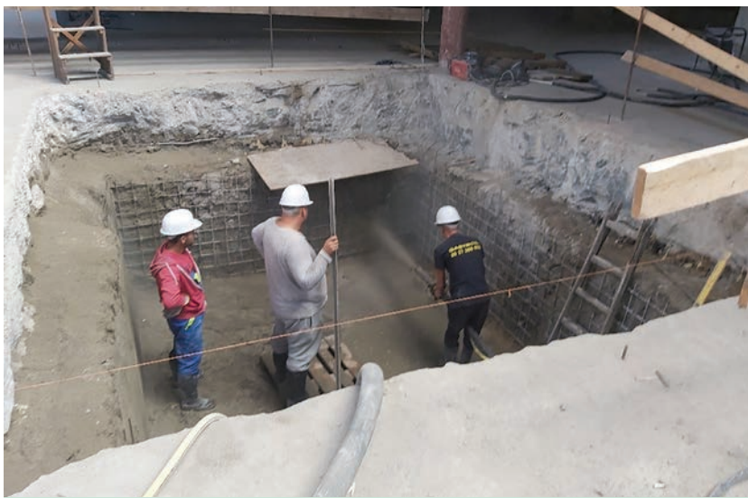
3. ábra. Liftaknasüllyeszték kialakítása, kivitelezés közben
