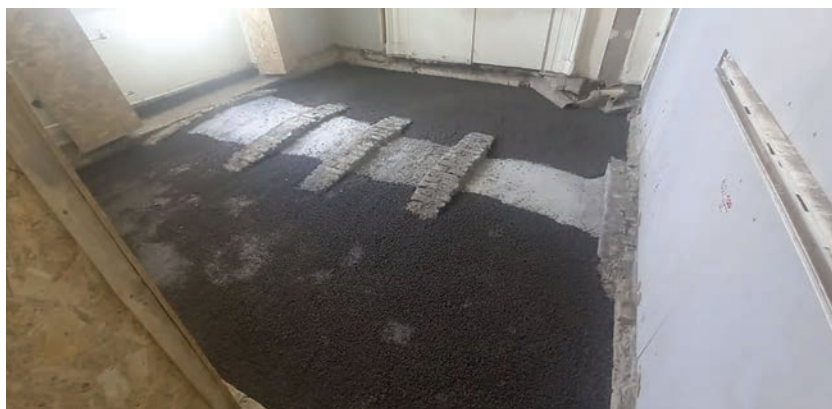
14. ábra. Elkészült földémmegerősítés a könnyített feltöltés készítését követően
