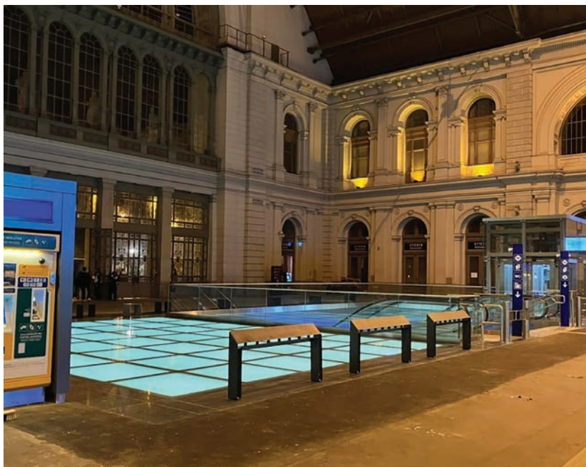
6. ábra. Megépült üvegfödém a lehatároló peronbútorokkal a hajnali nyitás előtt
