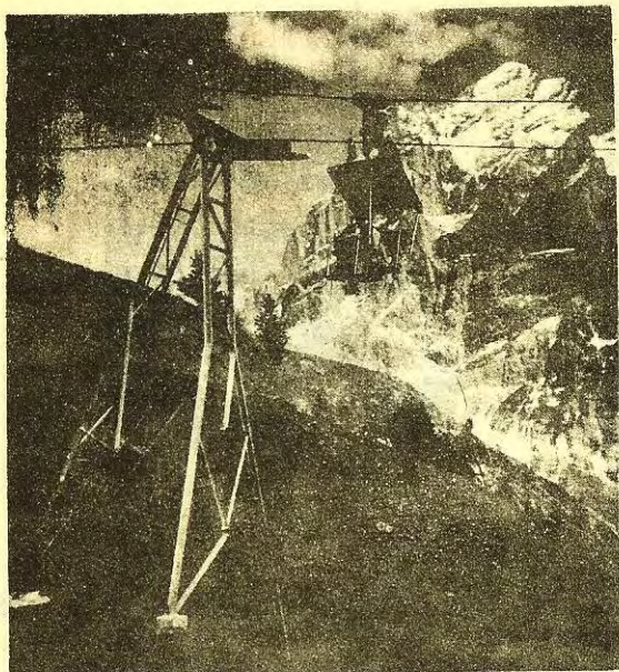
Modern kétszemélyes fűgőszékes osztrák kötélpálya. Teljesítménye 800-1000 személy/ó.
