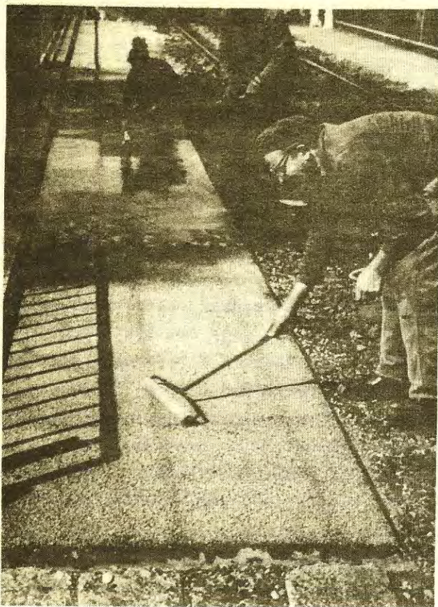
7.ábra. Zuzalék kézi behengerlése az epoxihabarcscba
