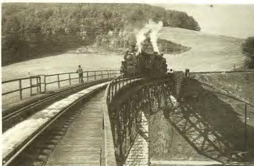
4. ábra A husztóti nagy-völgyhid 1965.évi próbaterhelése
