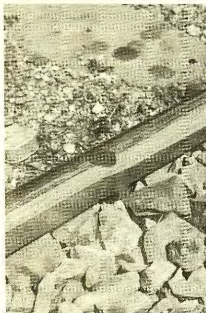
8.b.ábra Legyűrődéses sinkorona, hegesztett sín- kötés háromszor köszörülve
