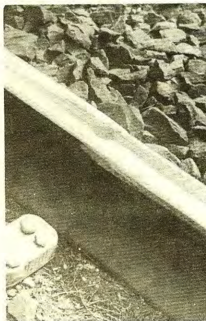
8.d.ábra Legyűrődéses sinkorona, hegesztett sín- kötés, négyszer köszörülve
