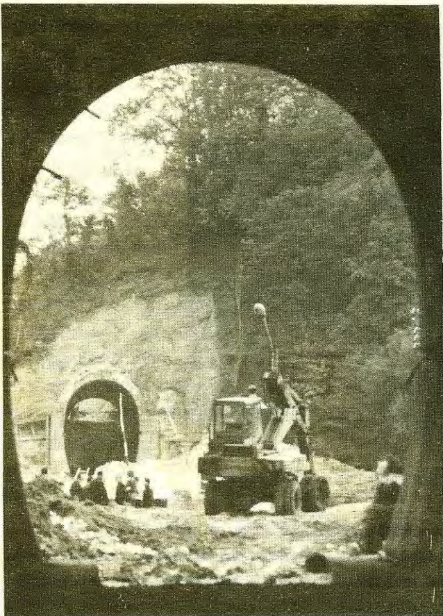
Az épülő 2.sz. alagut a 3.sz. alagutból nézve
